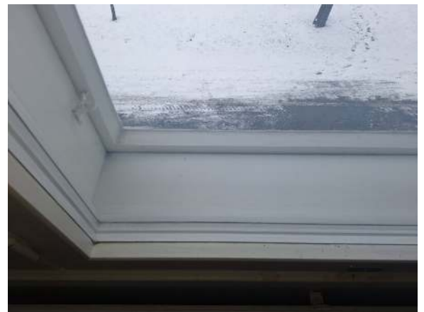
46. Ikkunat ovat MS -tyyppiset puuikkunat.
