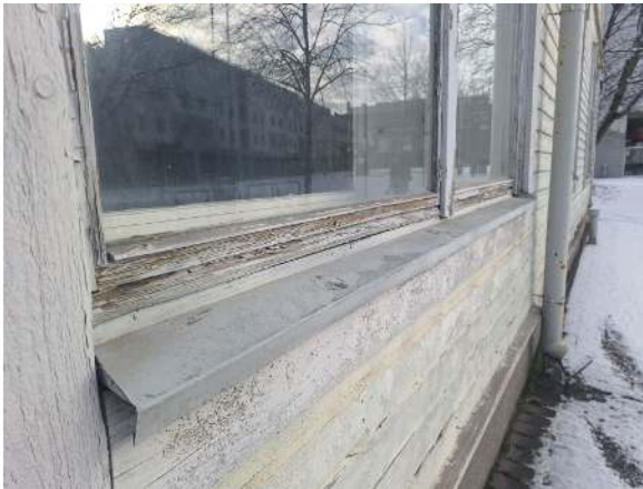
43. Vesipeltien kallistukset ovat kunnossa.
