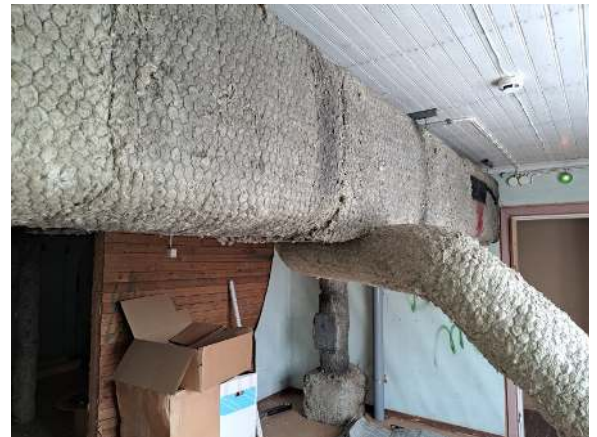
115. Ilmanvaihtokanavat on pääosin eristetty ylimmässä kerroksessa.
