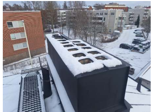
60. Piipunhattu puuttuu.
