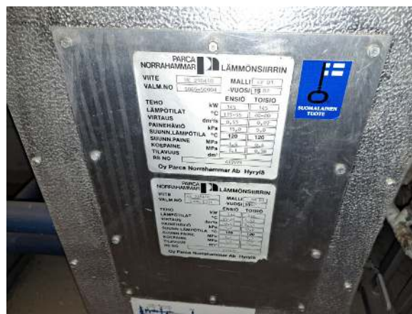
93. Lämmönjakokeskuksen tyyppikilpi.
