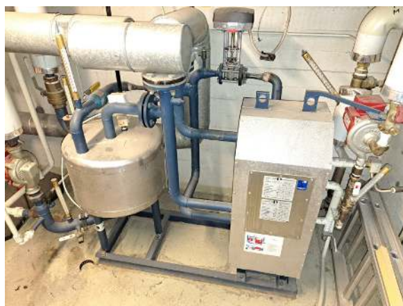
92. Lämmönjakokeskus.
