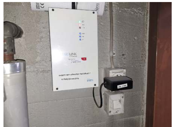
96. LVI jatkohälytykset lähtevät Smartlinkin kautta.
