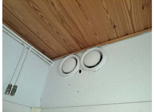
117. Poistoilmaventtiilit.
