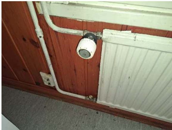
97. Termostaattinen patteriventtiili (vanha Danfoss).
