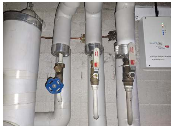
103. Käyttöveden linjaventtiileitä.
