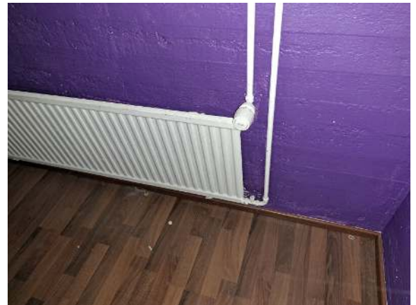
98. Termostaattinen patteriventtiili (uusittu Danfoss).
