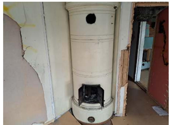
100. Kohteessa on kaksi tulisijaa (kakluunia).
