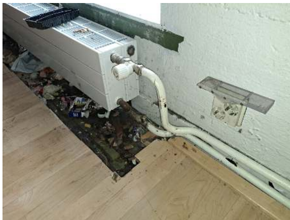
99. Käsikäyttöinen patteriventtiili.
