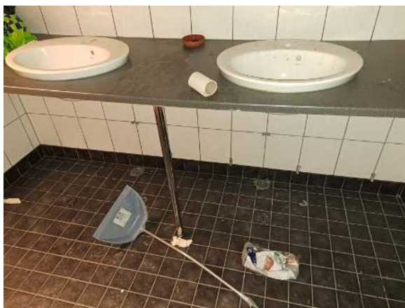
108. Vesi- ja viemärikalusteet on osin purettu.
