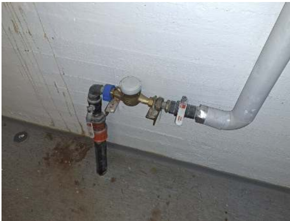
101. Kiinteistön päävesimittari.
