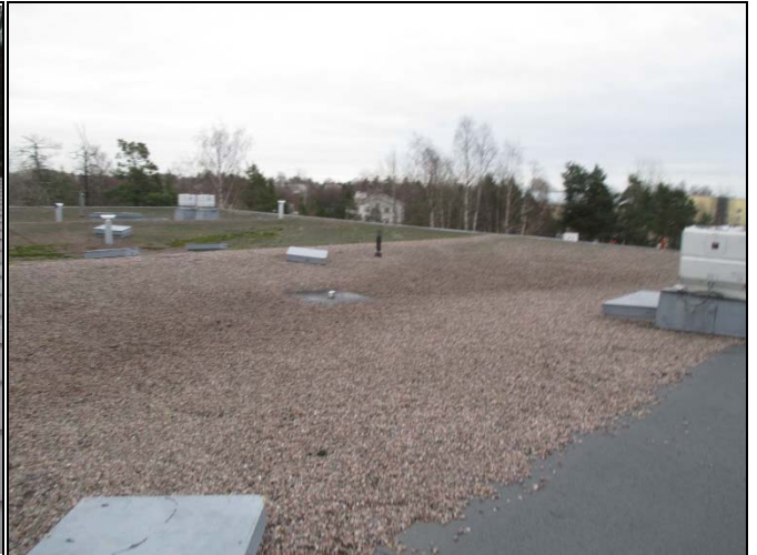
Yleiskuva liikuntasalin katolta
