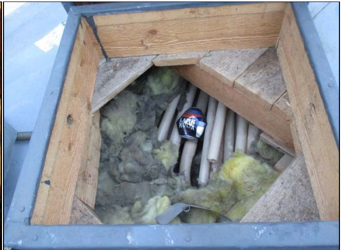
Pulpettikaton ontelotilassa runsaasti IV- ja sähkötekniikkaa
