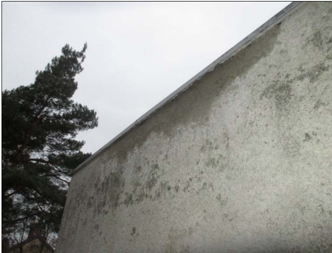
Paikkakorjattu alue räystäällä
