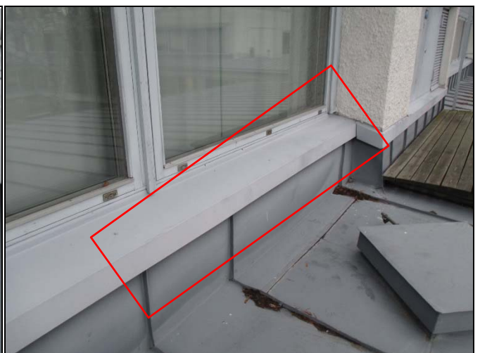
Havaintojen mukaan ilmaväli on ummessa alemman lappeen yläpäästä.
