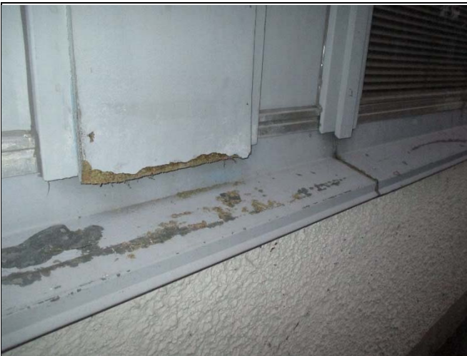
Kosteusvaurio ulkopinnan lastulevyssä
