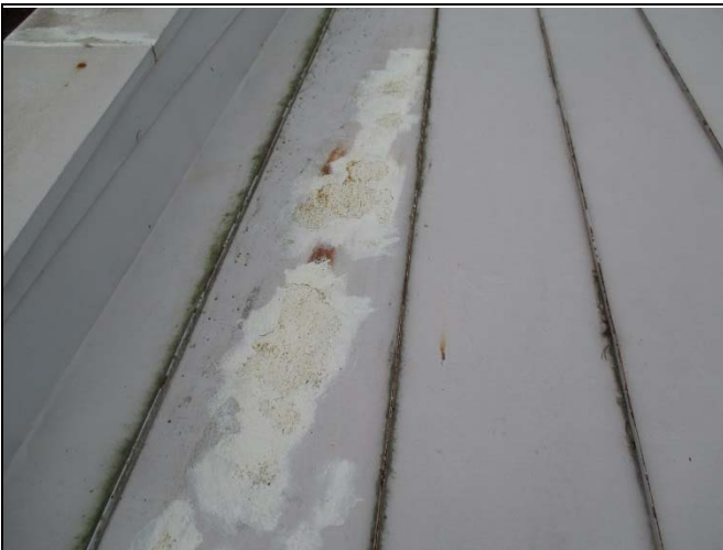
Maali- ja korroosiovauriot ovat yleisiä
