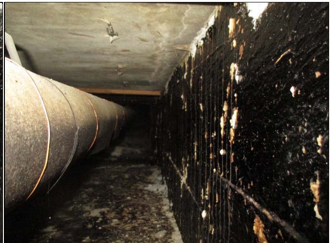
Matalaa putkikanaalia, katossa muottivaneri
