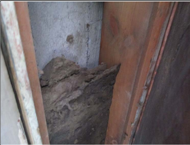
Puurakenteet betonia vasten, ei höyrynsulkua
