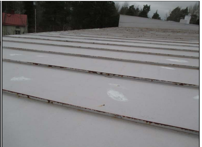
Pystysaumoissa laajat korroosiovauriot
