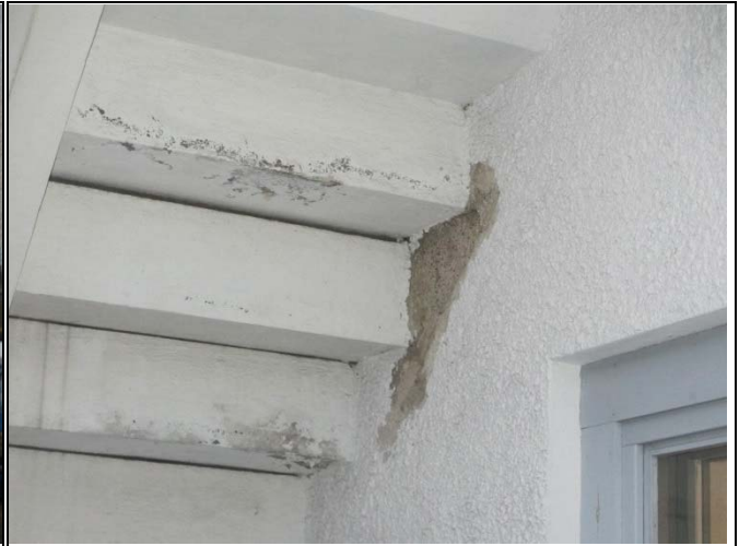
Vuotojälkiä ja maalivaurioita
