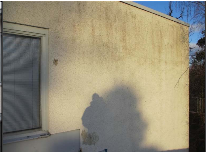
Valumajälkiä värjäytyksiä esiintyy monin paikoin
