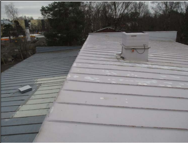
Yleiskuva pulpettikatolta, vasemmalla paikkakorjattu alue
