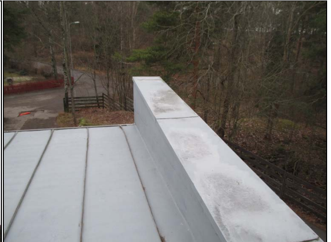
Päätyräystäillä ei ole kallistuksia
