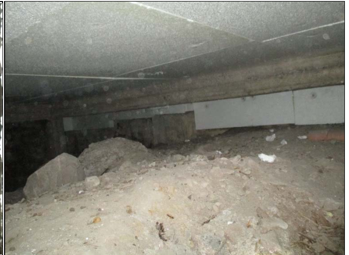
Ryömintätila jossa kallionpinta näkyvissä
