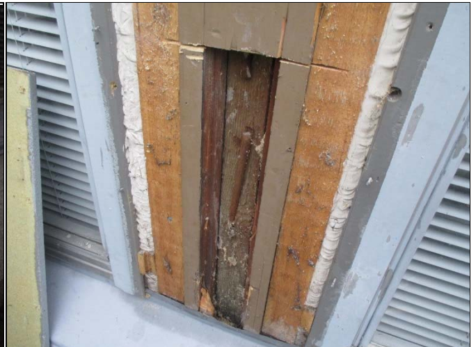
Rakenteet ovat täysin tuulettumattomia
