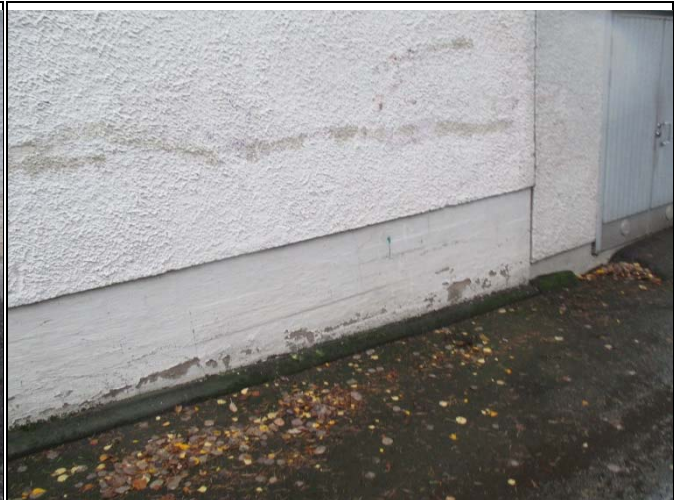
Maalivaurioita sokkelin alaosassa
