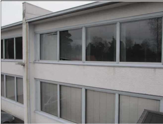
Nykyisiä ikkunarivejä lännen puolella
