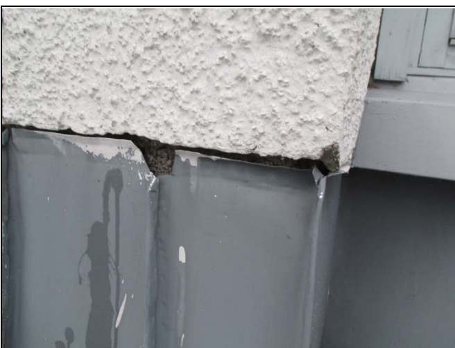
Epätiviitä pellitysten liittymiä havaittiin monin paikoin
