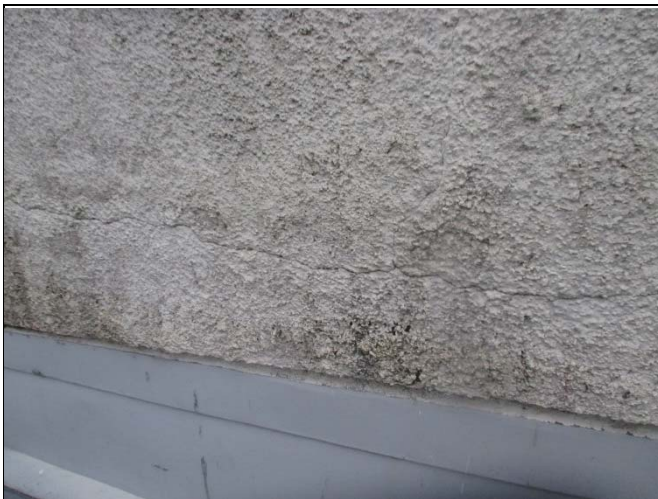
Suurehko halkeama rappauskerroksessa
