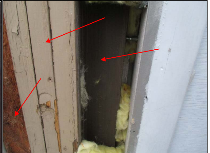
Avauksissa havaittiin useita purkamattomia vanhoja ikkunarakenteita.
