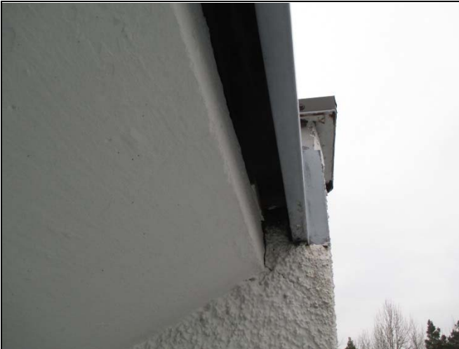
Räystäillä on pääosin riittävät tuuletusvälit
