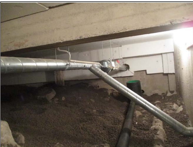
Koneellinen IV-on osassa ryömintätiloista
