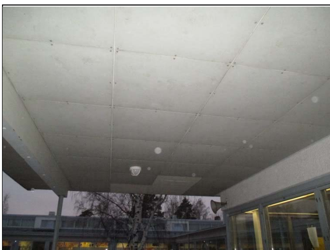
Katoksen alapinnan levytys
