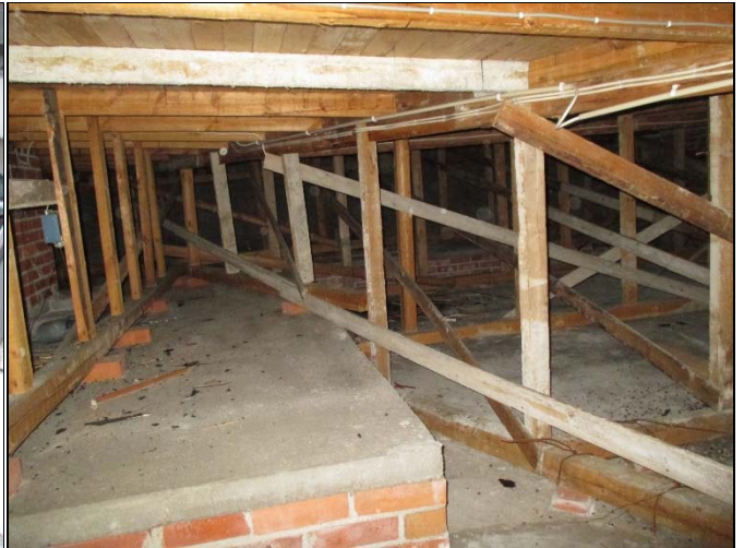
Yleiskuva liikuntasalin yläpohjasta
