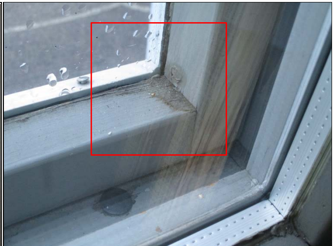
Kosteutta tiivistyy paikoin ulkolasin sisäpintaan
