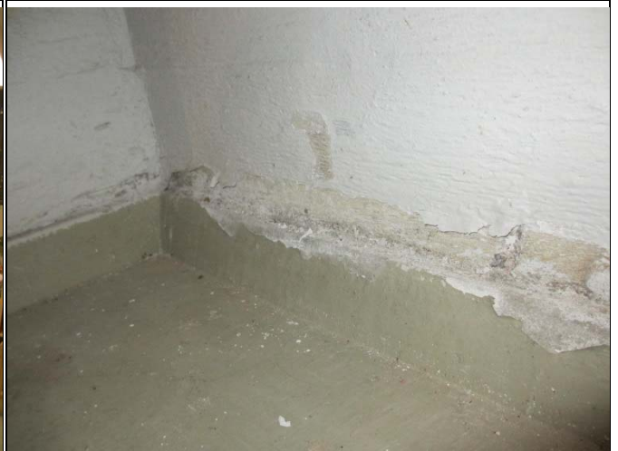
Seinän alaosan maalivaurio väestösuojassa
