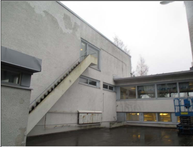
Portaat liikuntasalin päädyssä
