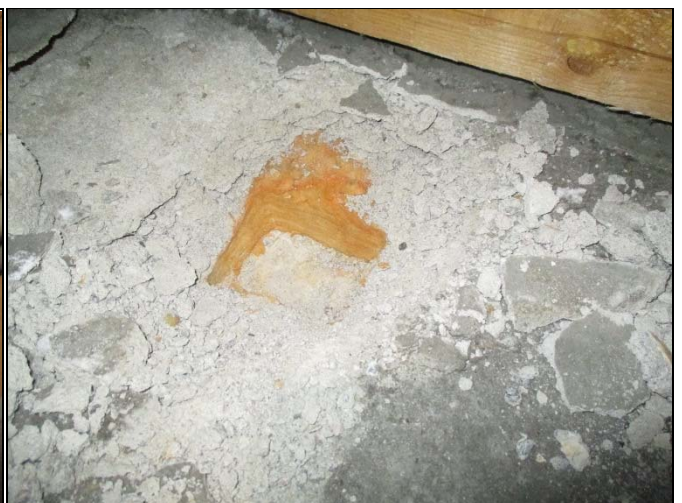
Rakenneavaus, liikuntasalin yläpohja
