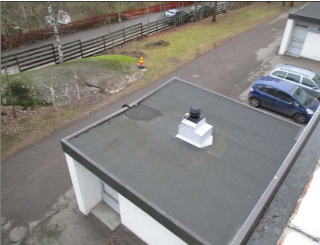
Lännen puolen ulokeosien katot on uusittu
