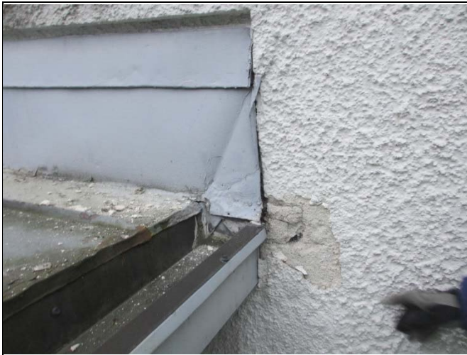
Liittymäpellitys epätiivis, alueella rappausvaurio
