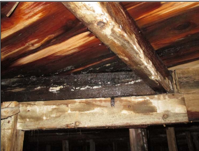
Liikuntasalin katto vuotaa paikoin
