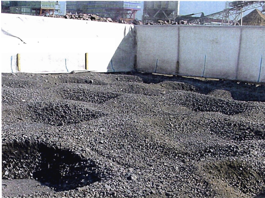
Kuva 5.12 Koealueen pinta toisen pudotuskierroksen jälkeen ennen tasausta
