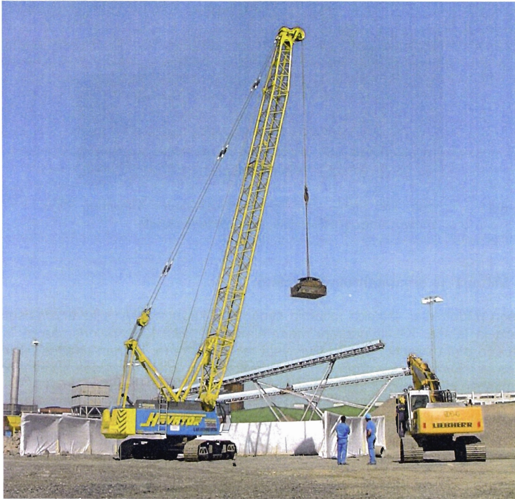
Kuva 5.2 Tela-alustainen ristikkopuominosturi, tela-alustainen kaivinkone ja koealueen suoja-aitaus
