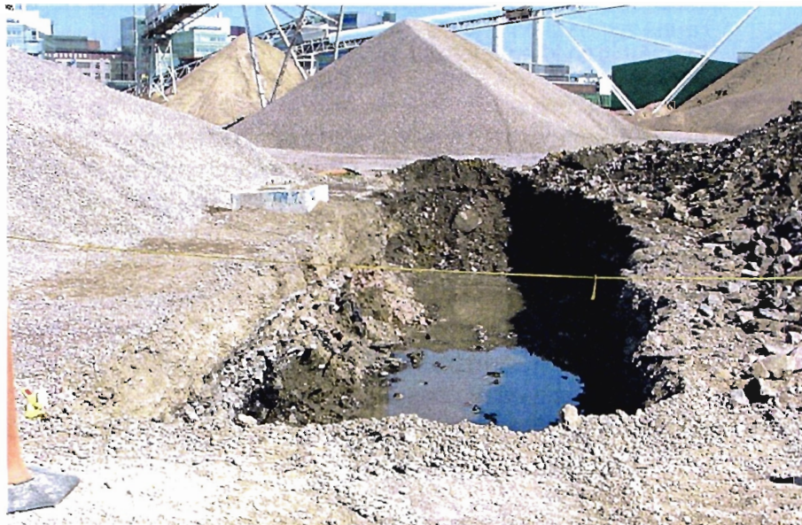
Kuva 5.7 Koealueen läheisyyteen kaivettu oja
