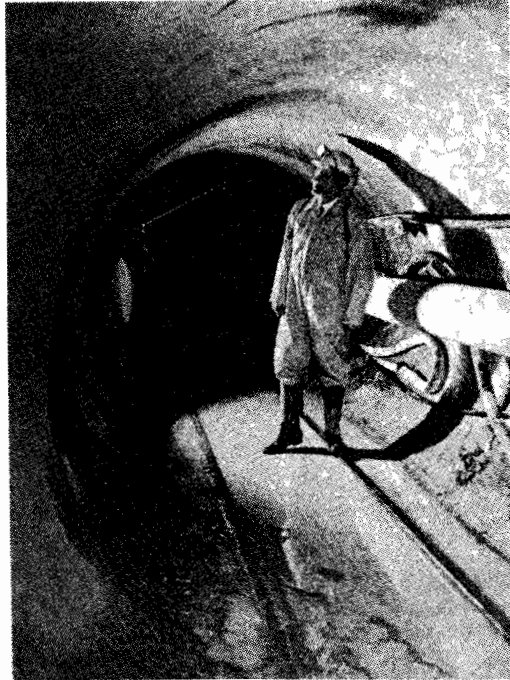
Kuva 47. Valmis sileäpintainen kalliötunneli /32/.
