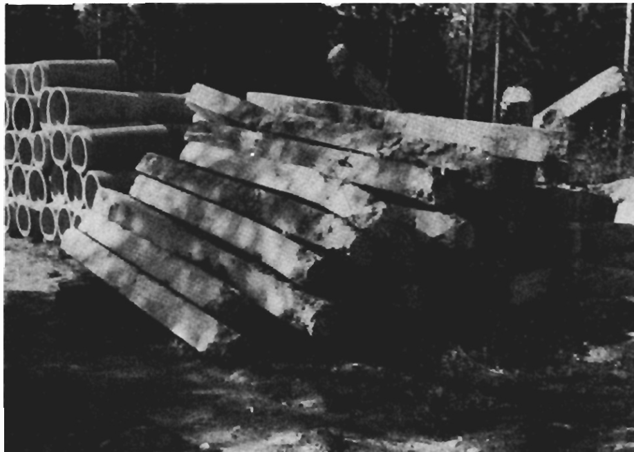
Kuva 6. Puutteellisten pohjatutkimusten takia joudutaan paaluista katkomaan usein pitkiä, kalliita hukkapätkiä.
