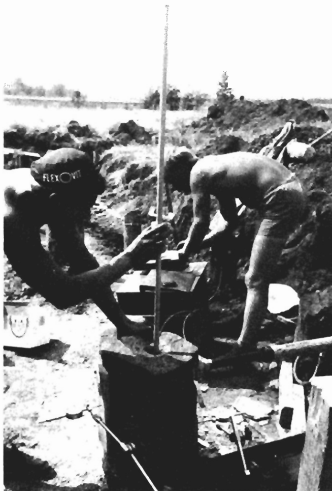
Kuva 4.23 Kaltevuusmittaus puupaaluun kairatusta reiästä. Marjaniemi.
