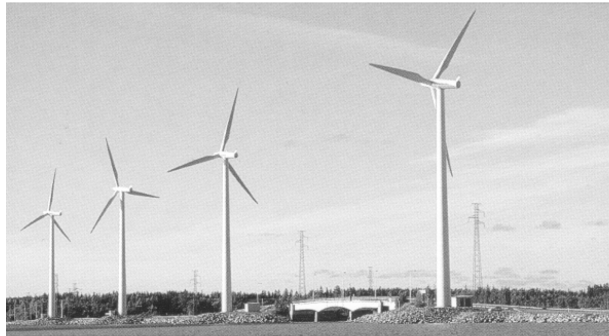
Meri-Porin tuulivoimapuiston voimaloita Reposaaaren pengertien varressa (kuva: Porin Energia)
