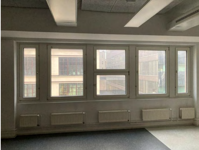
Kuva 3.12. Tyypillinen ikkunasarja Elimäenkadun julkisivussa ruutuelementin isossa aukossa.
