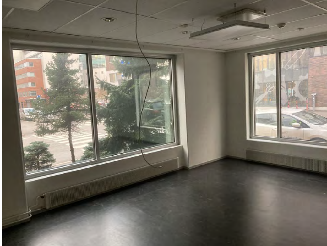
Kuva 4.15. Yleiskuva umpiolasielementeistä Elimäenkadun ja Telekadun nurkalla.
