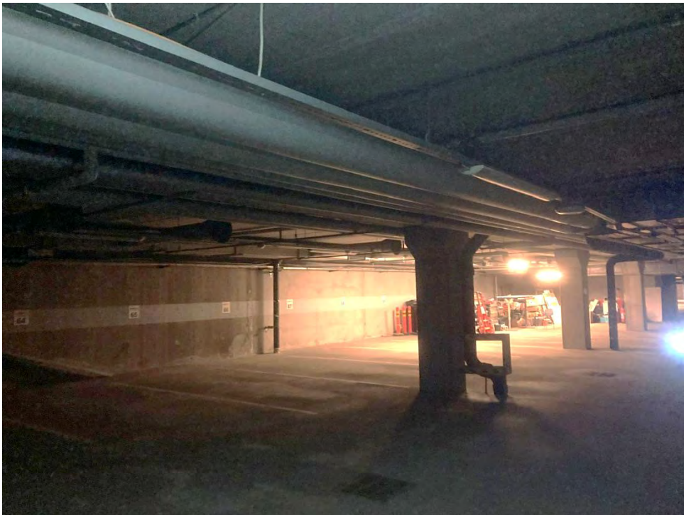
Kuva 3.5. Yleiskuva Elimäenkadun pysäköintilaitoksesta (marraskuu 2025).
