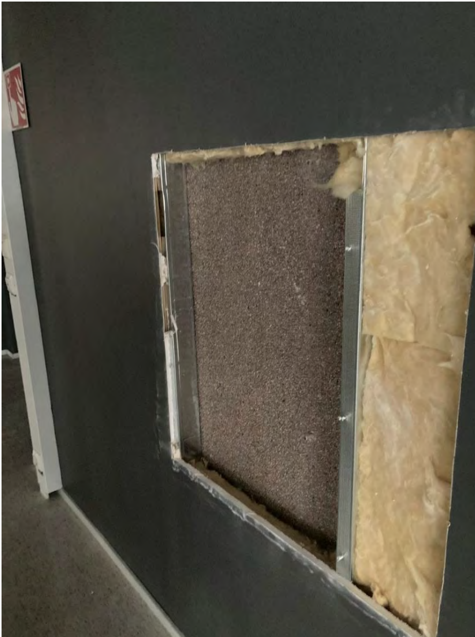
Kuva 4.12. Elimäenkadun puolella tehty rakenneavaus, jossa Teollisuuskadun puoleinen ulkokuori näkyvissä rakennuksen liitoskohdassa.
