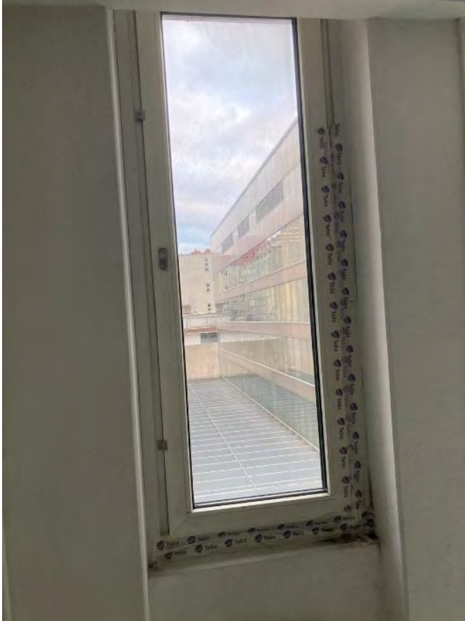
Kuva 3.14. Ikkunoissa olevia teippauksia, joilla on todennäköisesti estetty vedontunnetta työpisteellä.
