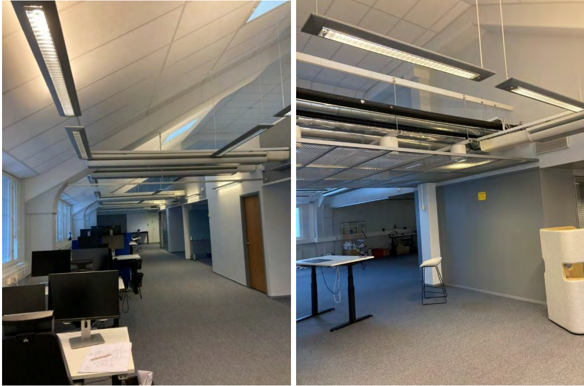
Kuva 2.10. Yleisvalokuvia 6. kerroksen tiloista osasta 3–4, joka puretaan kokonaan.
