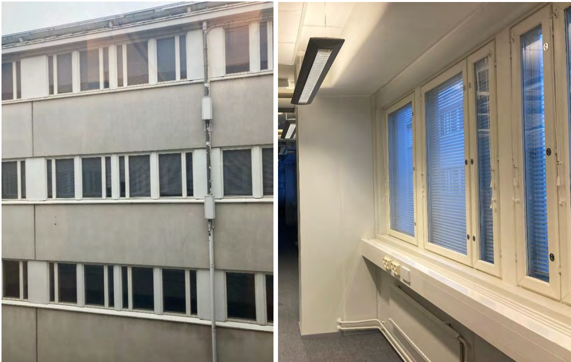
Kuva 2.14 Sturenportin sisäpihojen julkisivua/ulkoseinää sekä ikkunanauhvoja linjalla 3-4.
