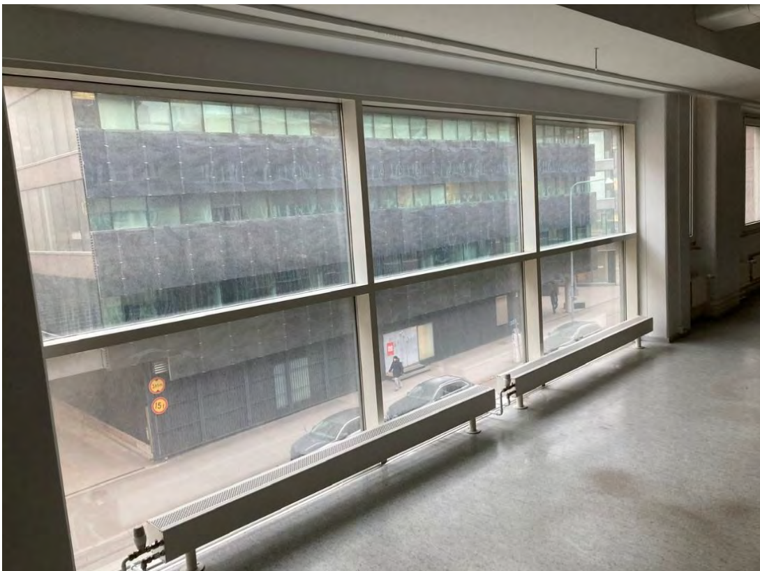
Kuva 3.15. Elinmäenkadun julkisivun kiinteä lasiseinä
