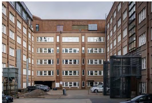
Teollisuuskatu 15 ja Elimäenkatu 6 sisäpihan julkisivuja, joista Teollisuuskadun osuus säilytetään pääosin
