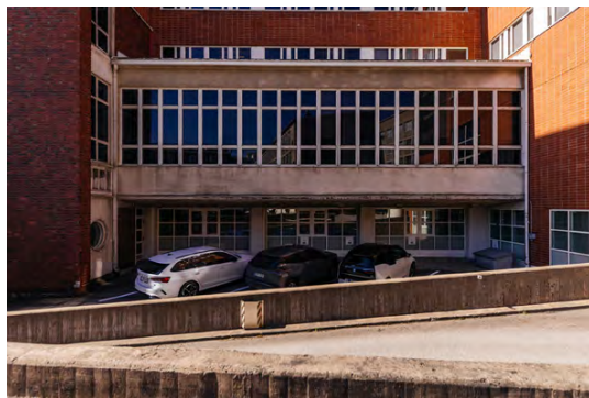
Sturenkatu 16 "leipomon alueen" osittain säilyvää julkisivua Elimäenkadulle
