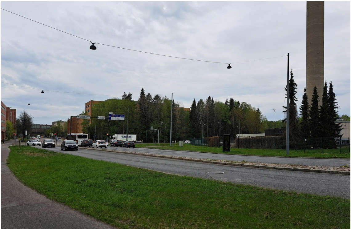
Kuva: Katunäkymä Kaupintieltä kohti länttä. Oikealla huippu- ja varalämpökeskuksen tontti. Kuva: Helsingin kaupunki, asemakaavoitus
