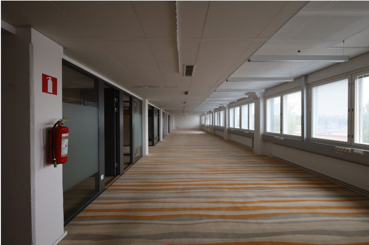
Laaja, yhtenäinen työtila rajautuu ulkoseinään ja pilaririvin väleihin rakennettuun väliseinälinjaan. Ikkunaseinän sienipilarirakenne on jätetty näkyviin.
