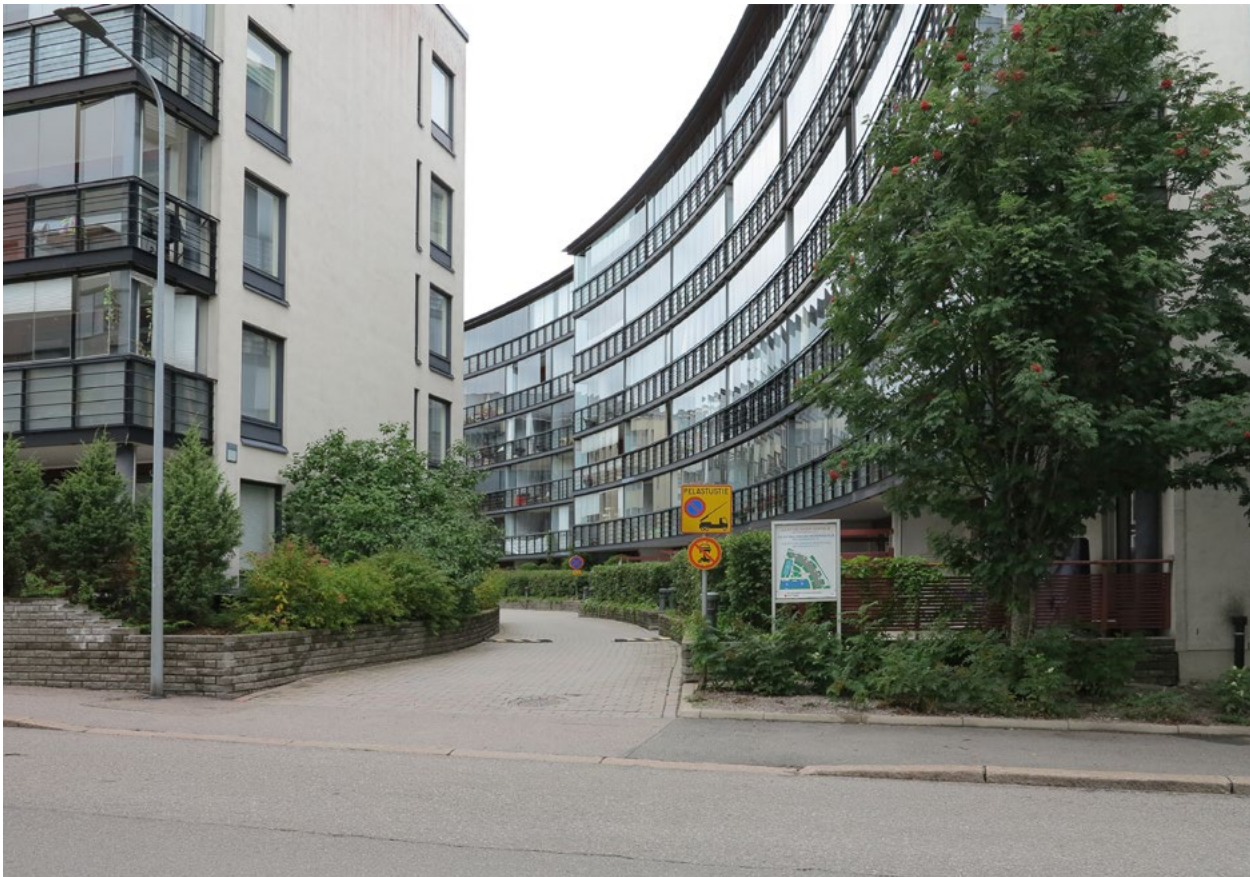
Korttelin 31133 asuinkerrostalot vuosilta 2005-2006, näkymä Vattuniemenkujalta.
