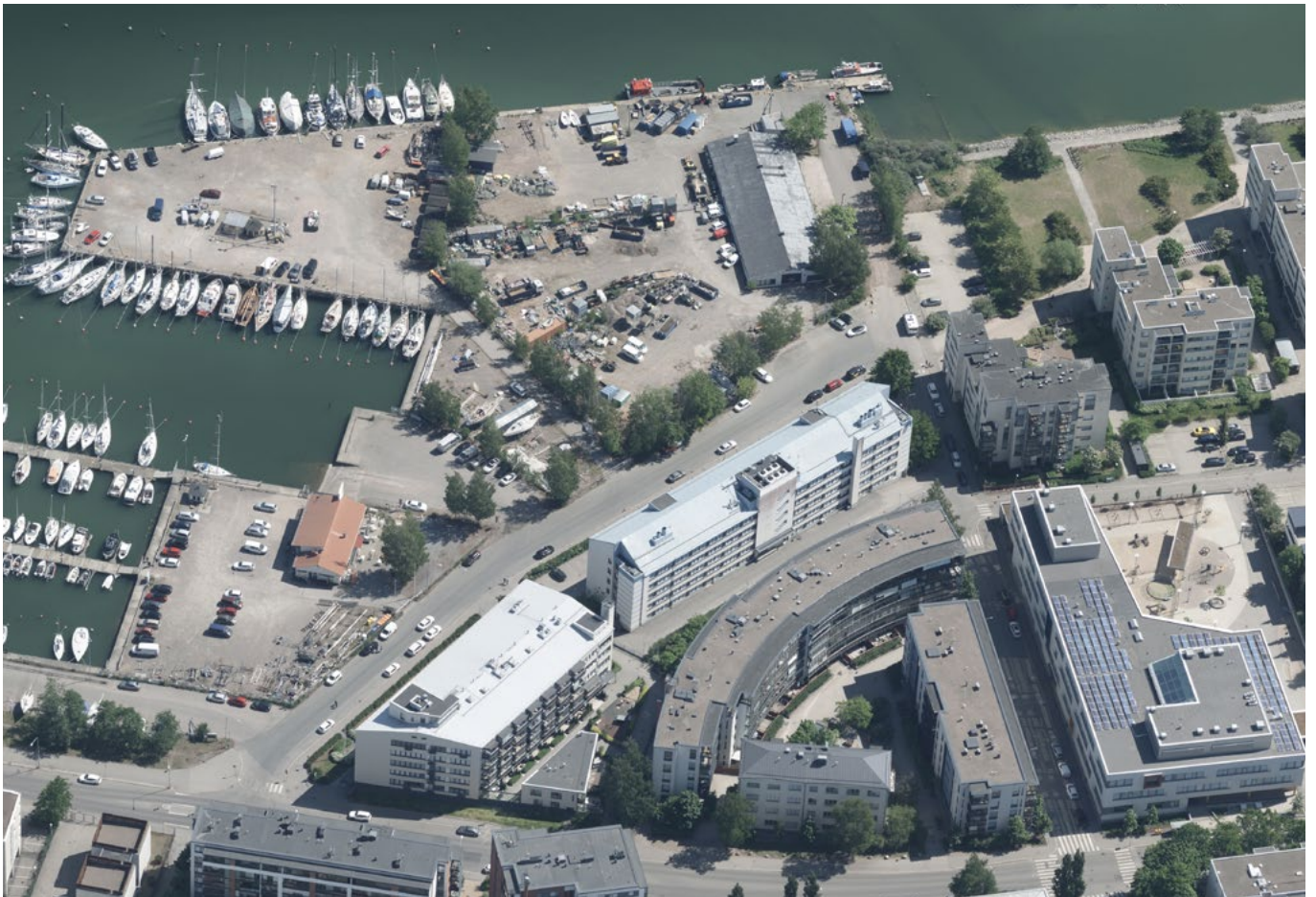
Viistokuva 2023 lännestä, Helsingin kaupunkimittaus. Pienveneslaitureiden, pурсiseuran ja Staran nykyisen varikon alueelle on asemakaavassa osoitettu kuusikerroksisten asuinkerrostalojen kortteli.
