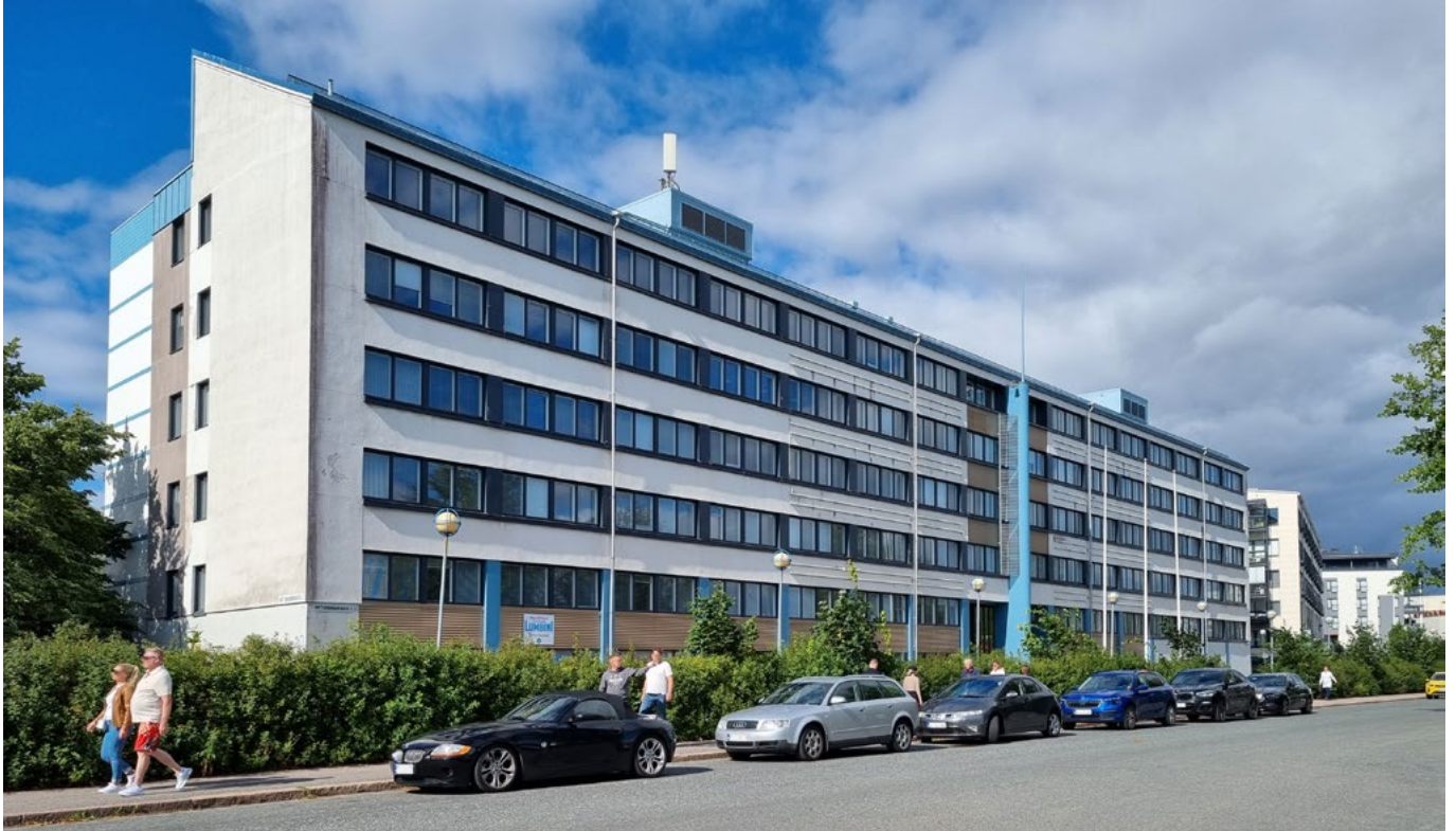
Koillisjulkisivu ja pääty kaakkoon 2025. Julkisivupinnat, pintarakenteet, ikkunat, ulko-ovet, yksityiskohdat ja väritys on muutettu 1990-luvulla.
