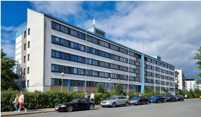
Koillisjulkisivun ulkoasu 2025. Julkisivupinnat, pintarakenteet, ikkunat, ulko-ovet, yksityiskohdat ja värit on muutettu.
