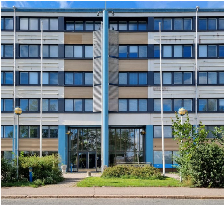
Keskiosan sisäänvedetty, peltiverhottu julkisivu ja spiira-aihe 1990-luvulta.
