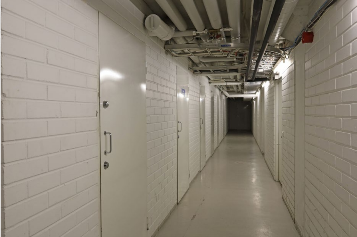
Kellarikerroksen käytävää rakennuksen luoteisosassa. Muuratut kahitiiliseinät ovat uusia, taustalla näkyy vanha, rapattu väestönsuojan seinä.
