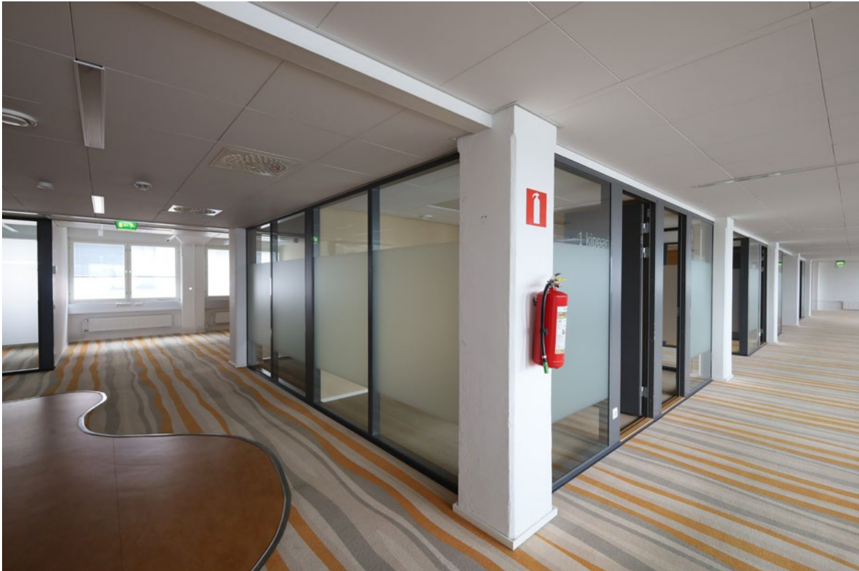
Tilajako toimistokerroksissa on pääosin 2000-luvulta. Väliseinät ovat osin lasia kaikissa toimistokerroksissa.
