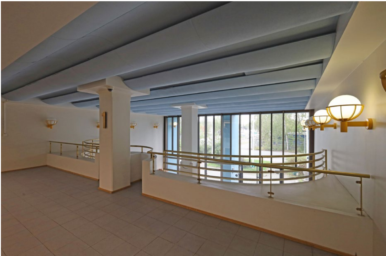
Sisääntuloaula 1. kerroksen tasolta. Sisustuksessa on 1990-luvulta periytyviä muotoaiheita, materiaaleja ja sävyjä: pyöristettyjä yksityiskohtia, kiiltävää keraamista lattialaattaa, messinginväriset kaiteet ja aaltoileva vaimennuskatto.
