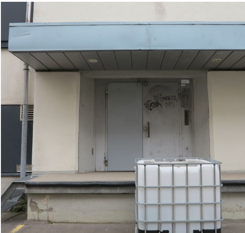
Pihajulkisivun lastauslaituri ja sivu-ulko-ovi .
