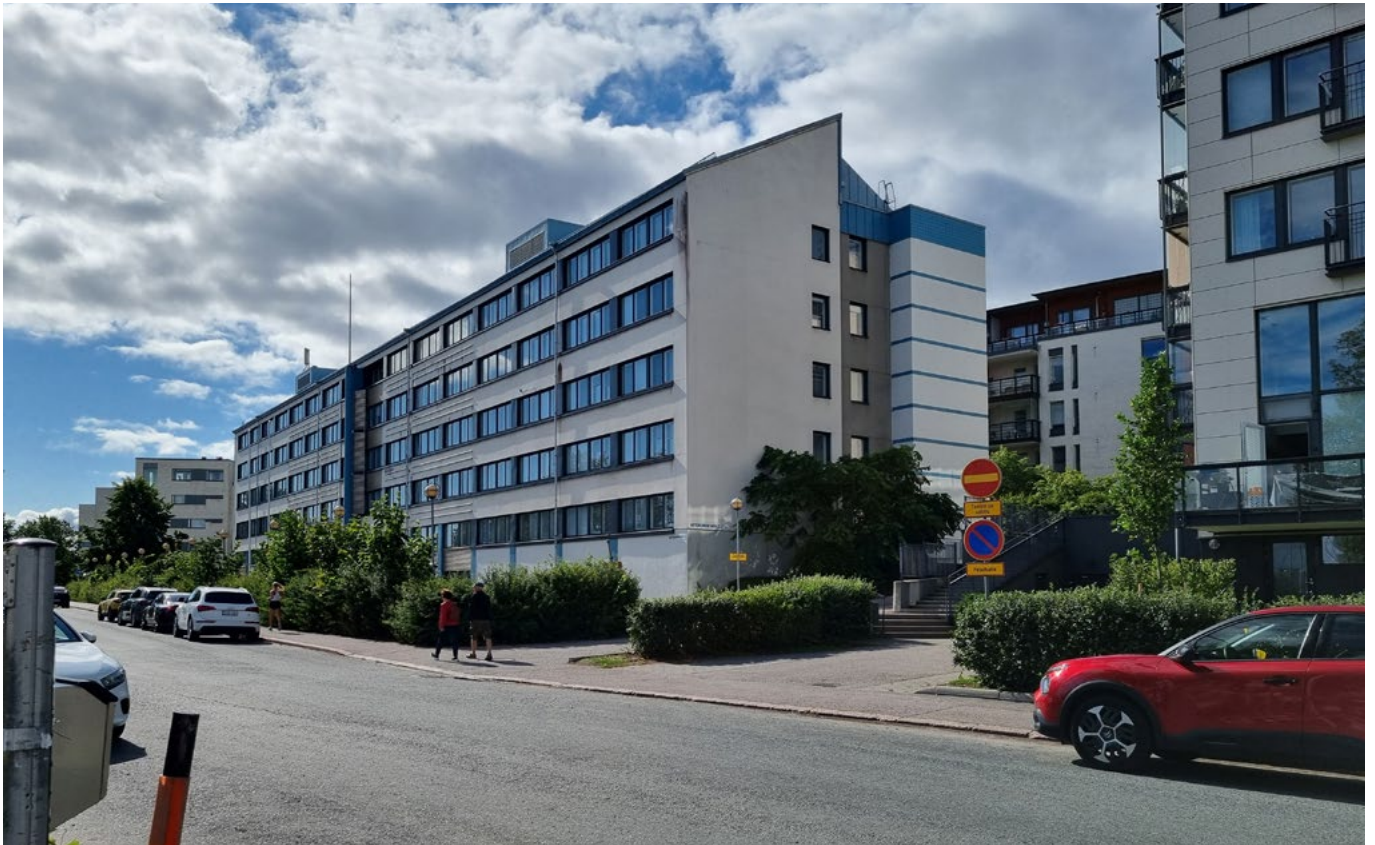
Koillisjulkisivu ja pääty luoteeseen 2025.
