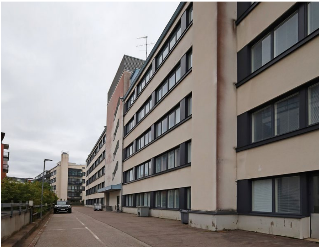
Pihajulkisivu lounaaseen. Eristerappauksen takia ikkunat ovat syvennyksessä julkisivupintaan nähden.
