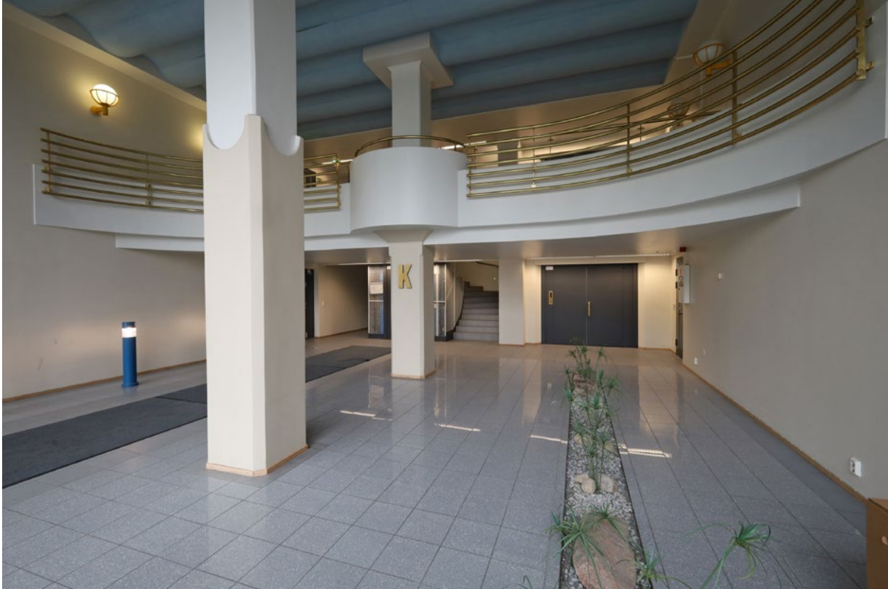
Maanpäälliseen kellarikerrokseen muodostettiin 1990-luvulla korkea sisääntuloaula purkamalla aukko välipohjaan. Alkuperäisiä kantavia sienipilareita on purkutöiden jälkeen muotoiltu korostamaan aulan ilmettä.
