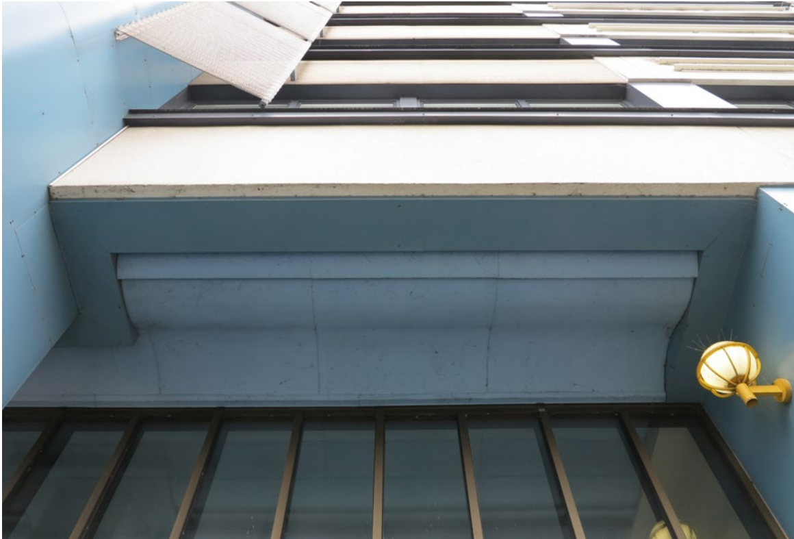
Koillissivun 1990-luvulla rakennetun sisääntuloaulan pyöreä seinävalaisin.
