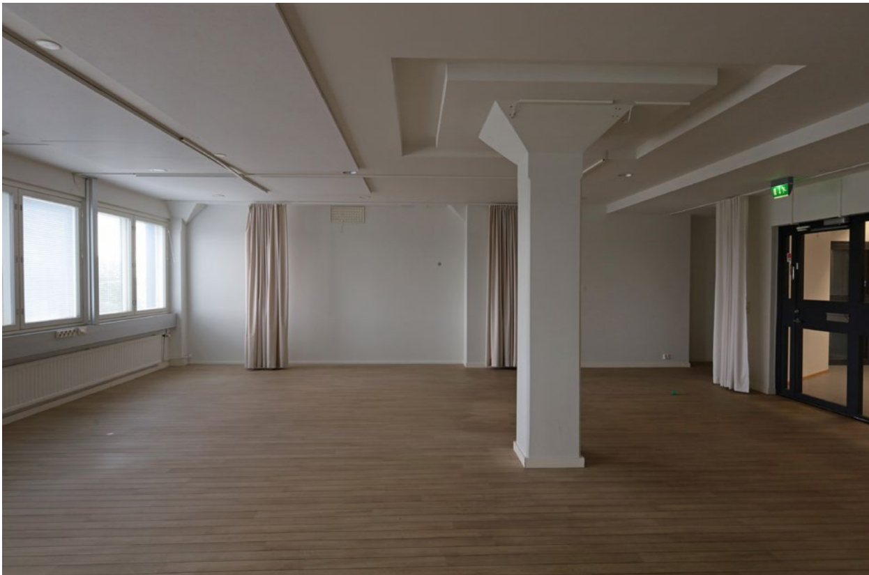
Sienipilarin kohdalla näkyy välipohjan neliömäinen vahvistusosa.
