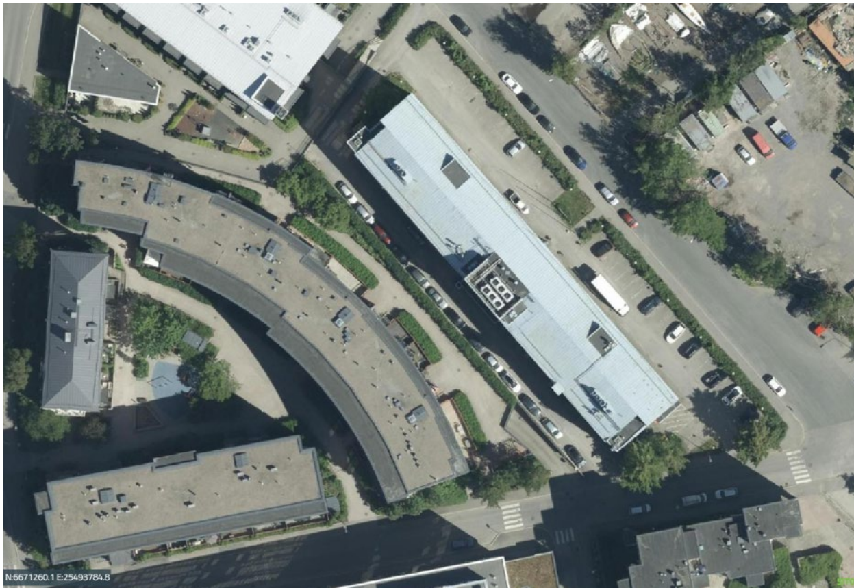
Ortokuva vuodelta 2024. Vasemmalla asemakaavassa sr-2-määräyksellä suojeltu, vuonna 1936 valmistunut aumakattainen rakennus ja asuin kerrostalot vuosilta 2005–2006. Helsingin karttapalvelu.
