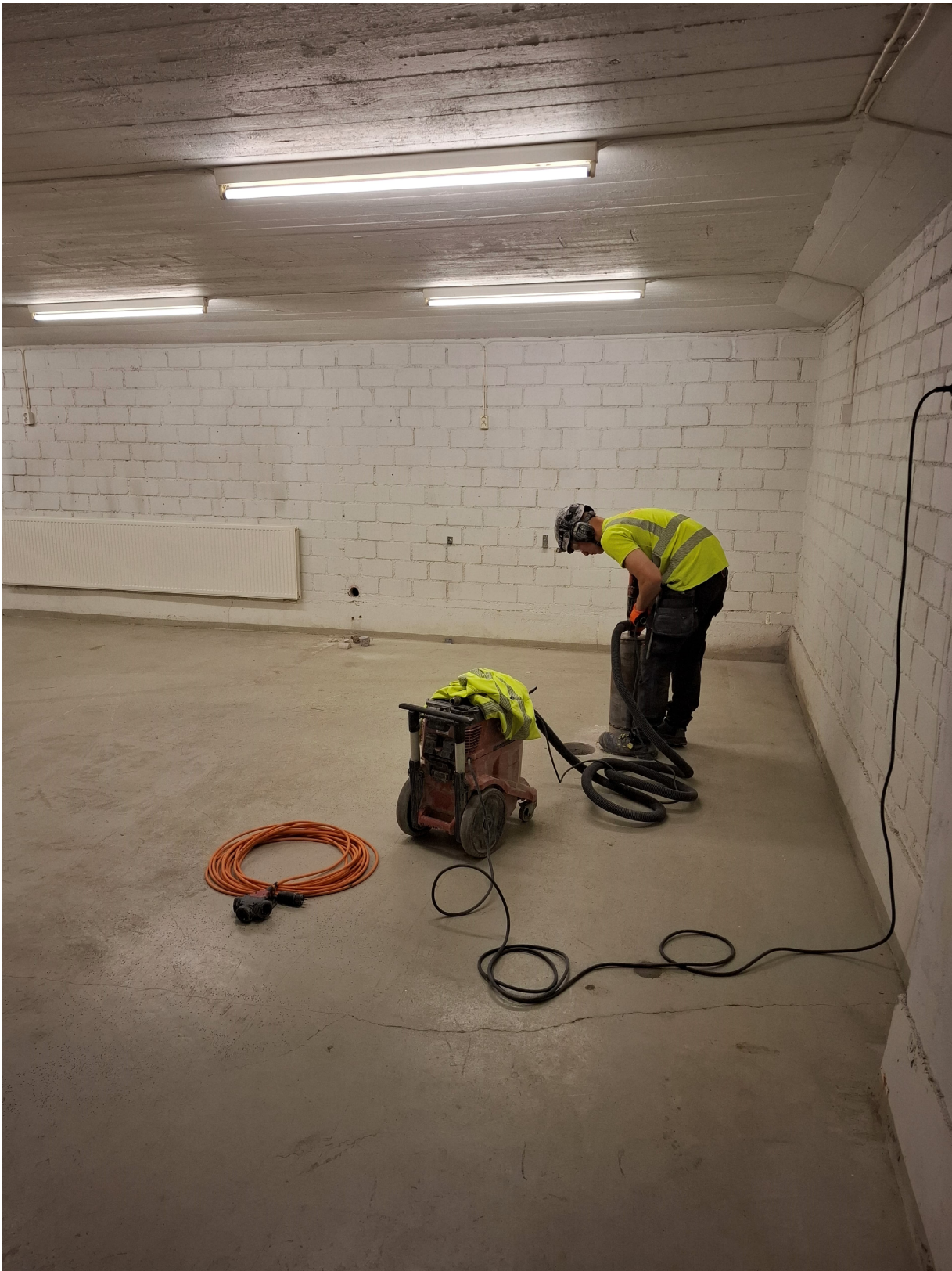
Kuva 5. Rakennuksen sisäpuolisten näytepisteiden läpäisyt toteutettiin timanttiorauksella. Tässä kyseessä näytepisteen SE9/0,0-0,5 m läpäisyn toteutus.
