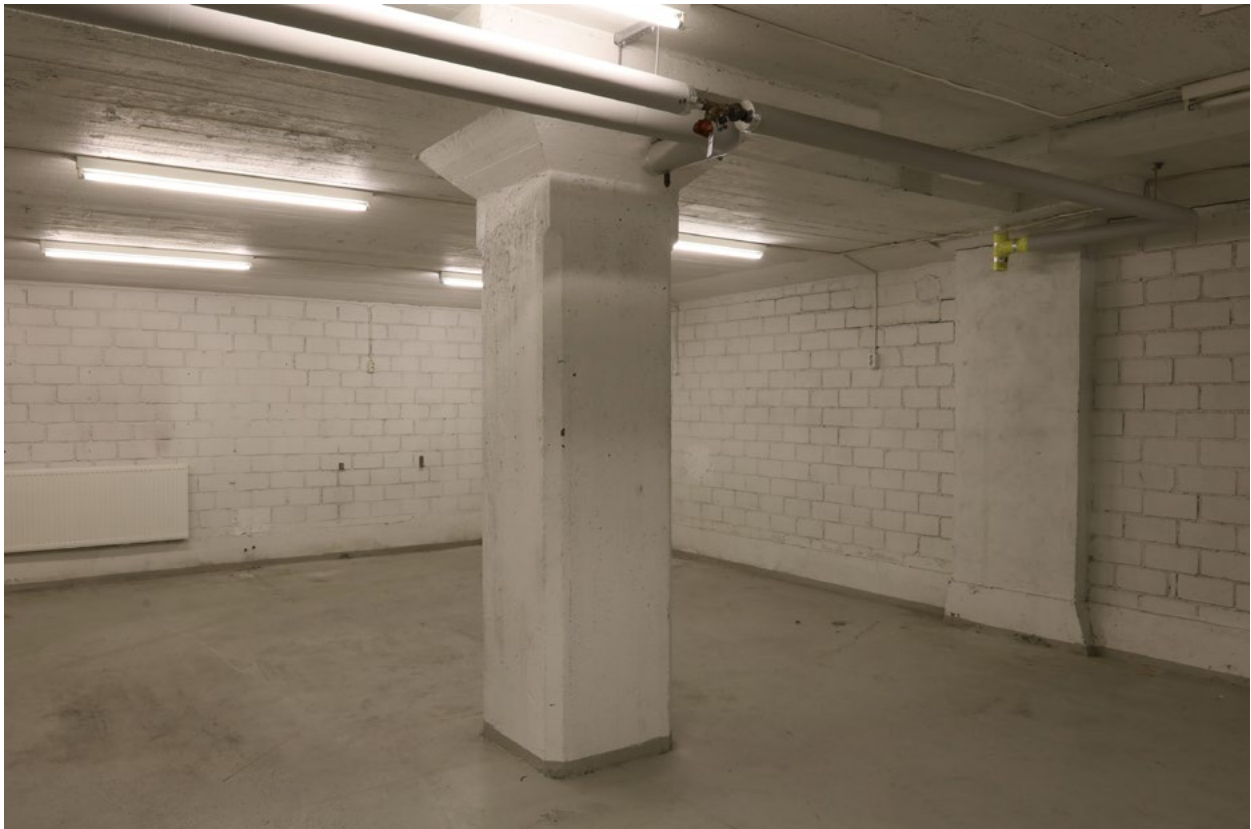
Väestönsuoja, kellarikerroksen järeä pilari, harkkoseinät ja raakavalukatto.
