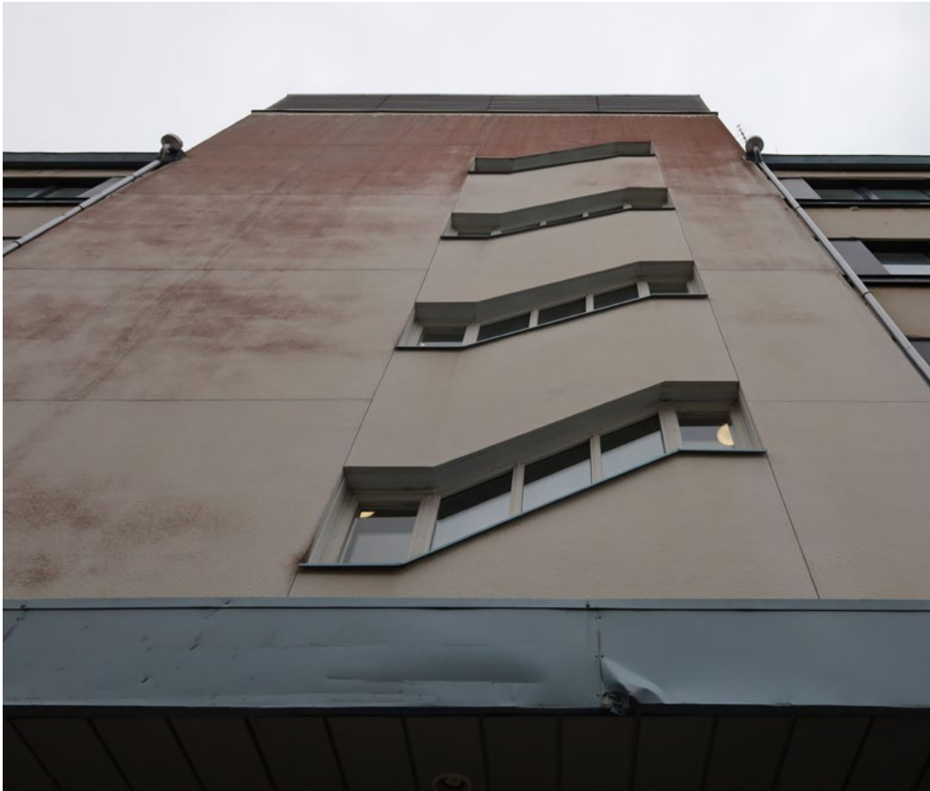
Porrashuoneen ikkunapieliä on pellitetty eristerappaustyön yhteydessä.
