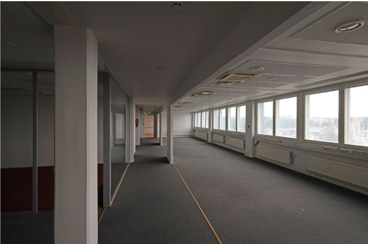
Alakattovyöhyke on kojeineen sijoitettu ulkoseinän yhteyteen.
