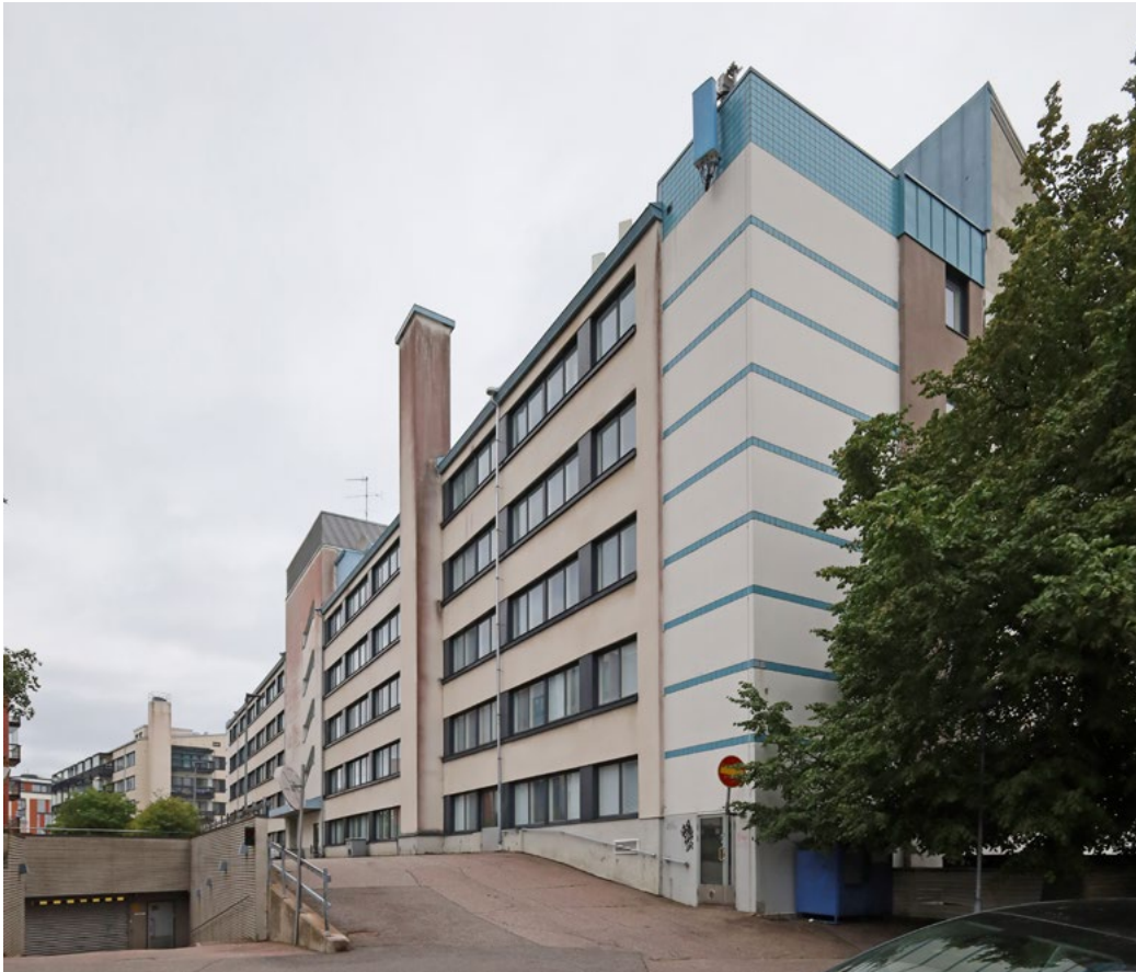
1990-luvun uusia päätyporrashuoneita on korostettu keraamisella laattaraidalla.
