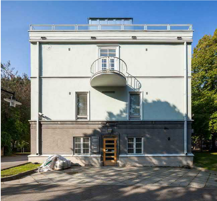
Rakennuksen eteläpään sisäänkäynti muutettiin vuonna 2004 esteettömäksi. Kattoterassin kaide uusittiin 50-luvun laajennuksen yhteydessä.
