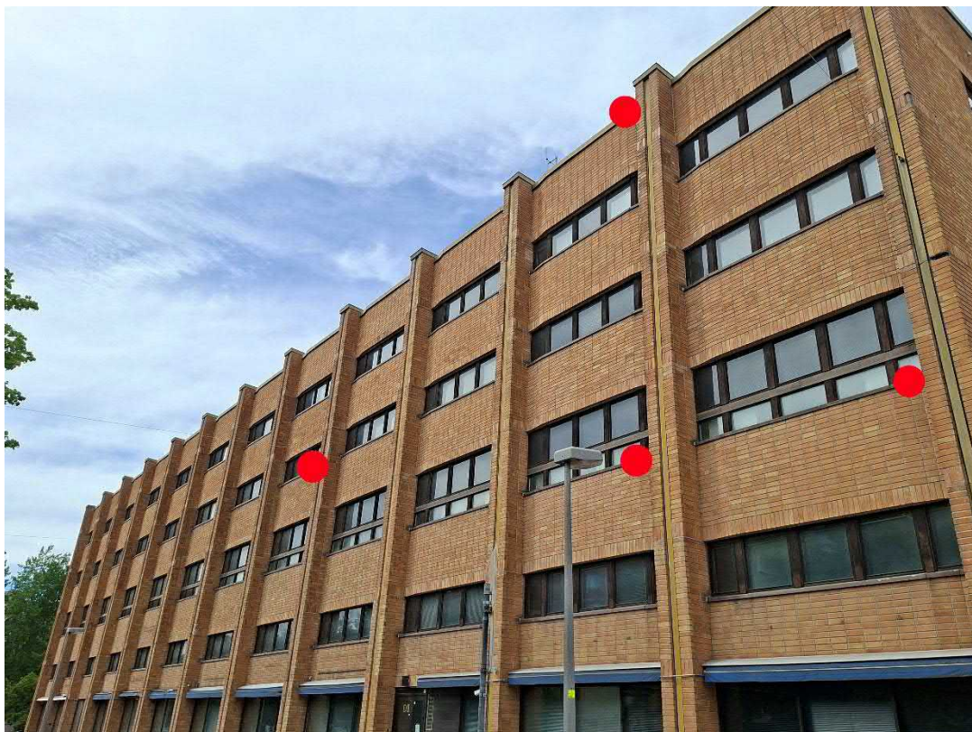
Kuva 1. Tervapääskyn todetut pesäpaikat läntisen rakennuksen eteläseinustalla eli Kaupintien puolella. Valokuva © Marko Vauhkonen.
