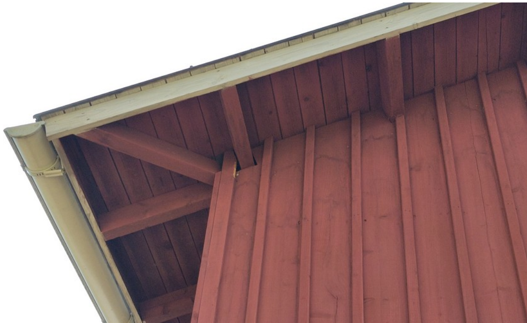
Kuva 7. Rako seinän ja kattopalkin saumakohdassa.
