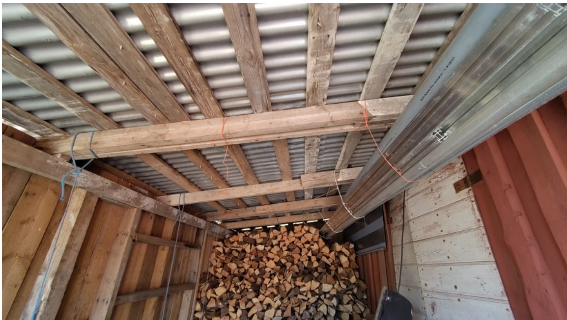
Kuva 3. Puuliiterin kattorakenne.
