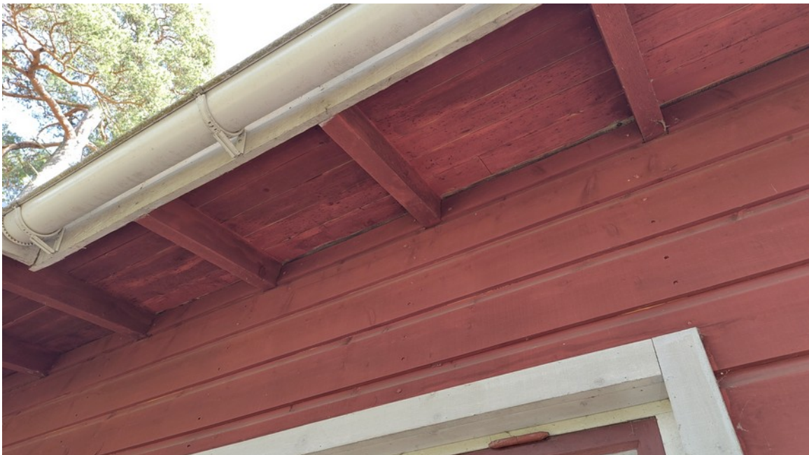
Kuva 5. Seinän ja katon välinen rako on verkotettu (suurennä kuvaa).
