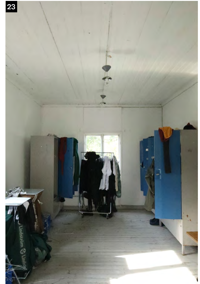
↑ Entiseen pesutupaan on sijoitettu ravintolahenkilökunnan sosiaalitiloja. Huoneen seinät on levytetty myöhemmässä vaiheessa valkoiseksi maala- tuin kovalevyin. Lautalattia on mahdollisesti alkuperäinen.
