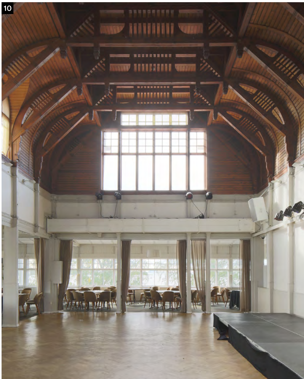
↑ Tanssisalin eteläpäätyä aukottaa suuri ikkuna. Salin kaakkoiskulmassa (kuvassa vasemmalla puolella) näkyy yhä jälkiä vanhasta orkesterikorokkeesta, sillä sen alta on purettu kaksi pilaria, joiden kapiteelit näkyvät yhä yläpuolisen seinäpinnan alaosassa.
