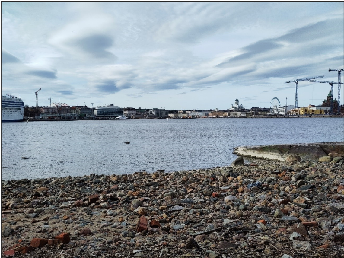
Kuva 18. Rakennusjätettä Valkosaaren luoteisrannalla, kuvaussuunta luoteeseen. Kuva: Aki Hakonen.
