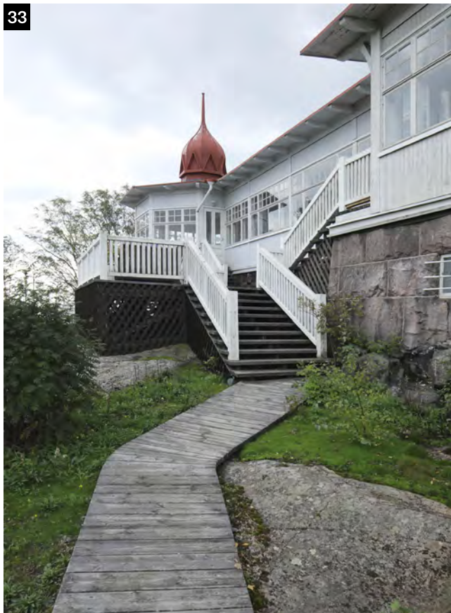
↑ Itäjulkisivun eteen on lisätty pieni puuterassi 2010-luvun alkupuolella. Terassi yhdistyy portain ravintolan vanhoihin sisäänkäynteihin.
