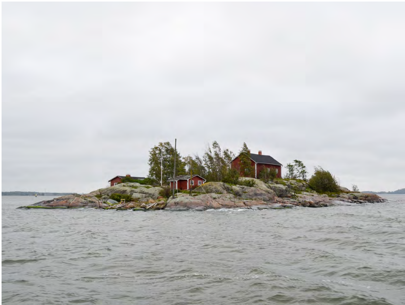
↑ Nykytilakuva Ryssänsaaresta kuvattuna veneeltä lännestä päin saapuessa. Päärakennuksen piiput ja länsipuolen ikkunat ovat vanhoilla paikoillaan. Rakennuksen päätyjen ikkunajakoa on muutettu. Saaren muut rakennukset on uusittu 1900-luvulla, mutta ne sijaitsevat pääosin samoilla paikoilla kuin 1800-luvulla.
