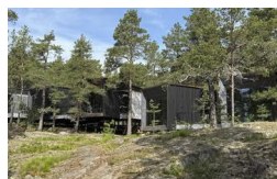
Rakennukset sijoittuvat luontevasti osaksi maastoa, ja niiden läheisyydessä säilytettävä puusto luo näkösuojaa.
