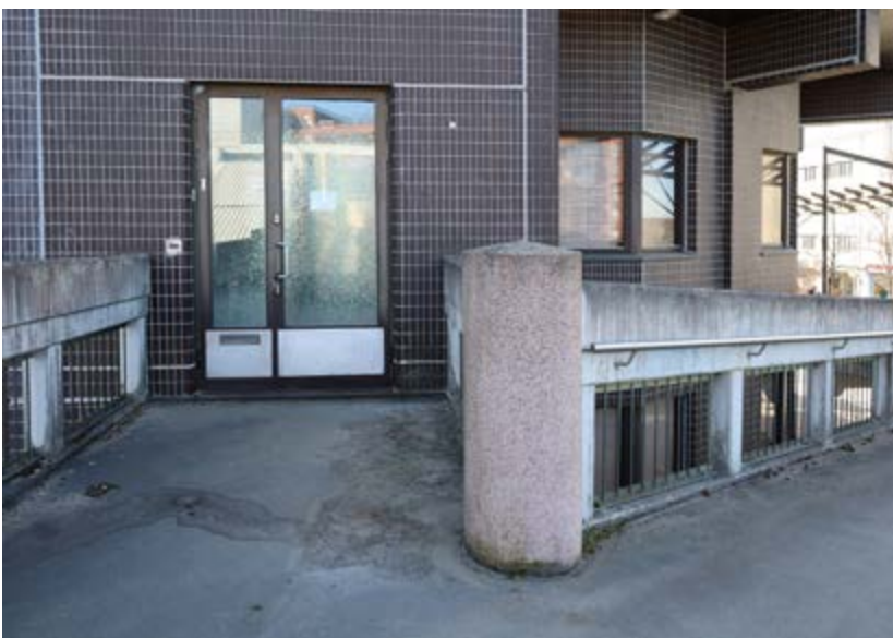
Rumpupolun kaiteissa on betonikehikko, teräspankset ja järeät, pyöreät graniittipilarit.
