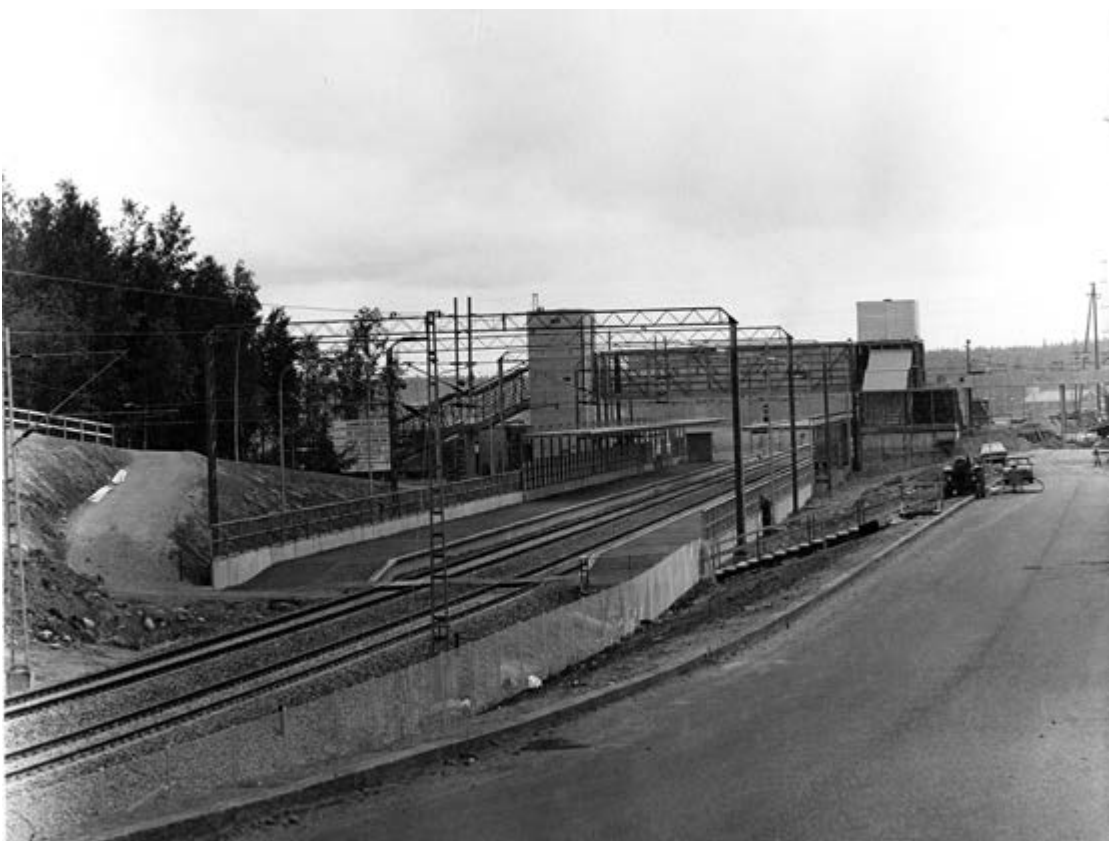
Kannelmäen asema rakenteilla vuonna 1974. Salpa Oy:n kokoelma. VKM
