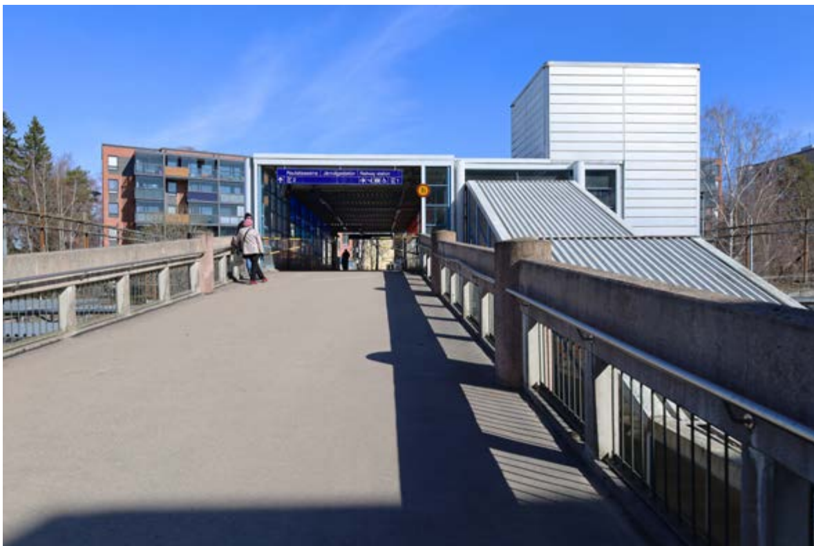
Sitratorin suunnalta aseman sillalle johtava Rumpupolun siltaosa, jossa on järeät betonikaiteet.
