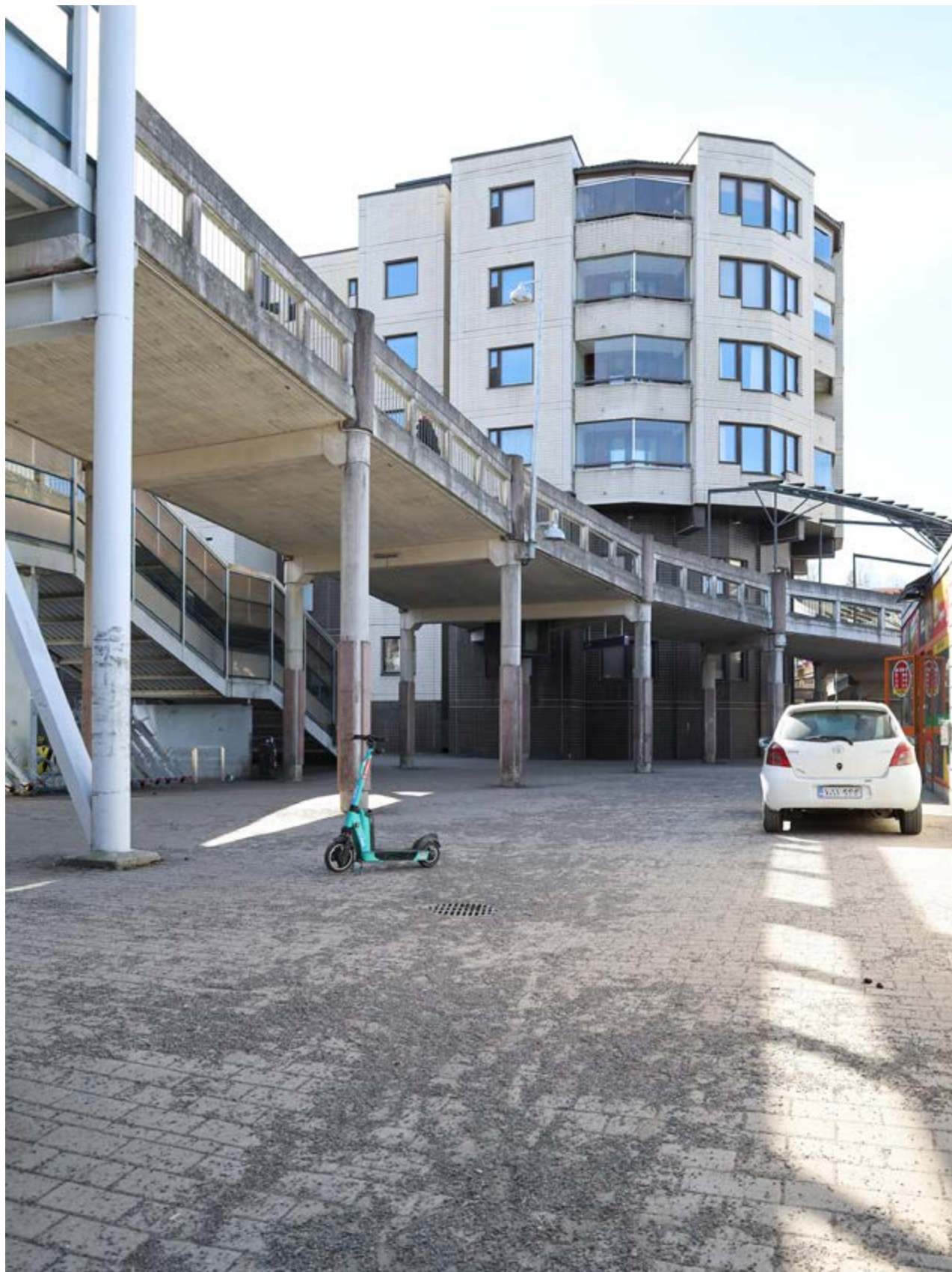
Rumpupolun betonisilta kaartaa kohti Sitratoria Asunto Oy Kannelkeskuksen päätyä myötäillen.
