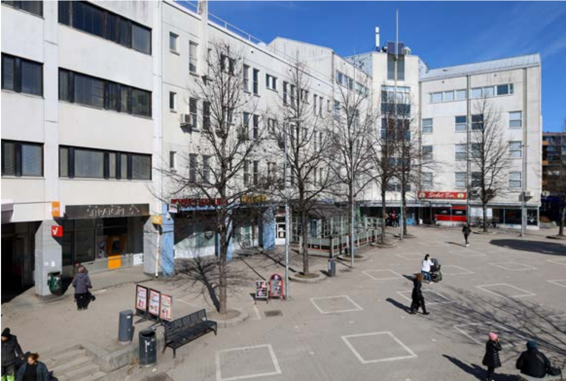
Sitratorin liiketalojen pohjakerroksessa on liiketiloja.
