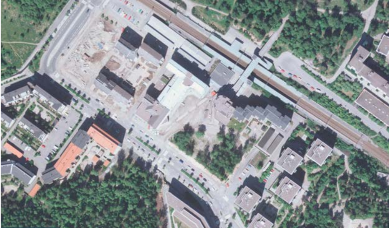
Ortokuva 1988. Helsingin karttapalvelu. Asuin- ja liiketaloista osa on valmistunut vuonna 1985 ja rakentaminen jatkuu.
