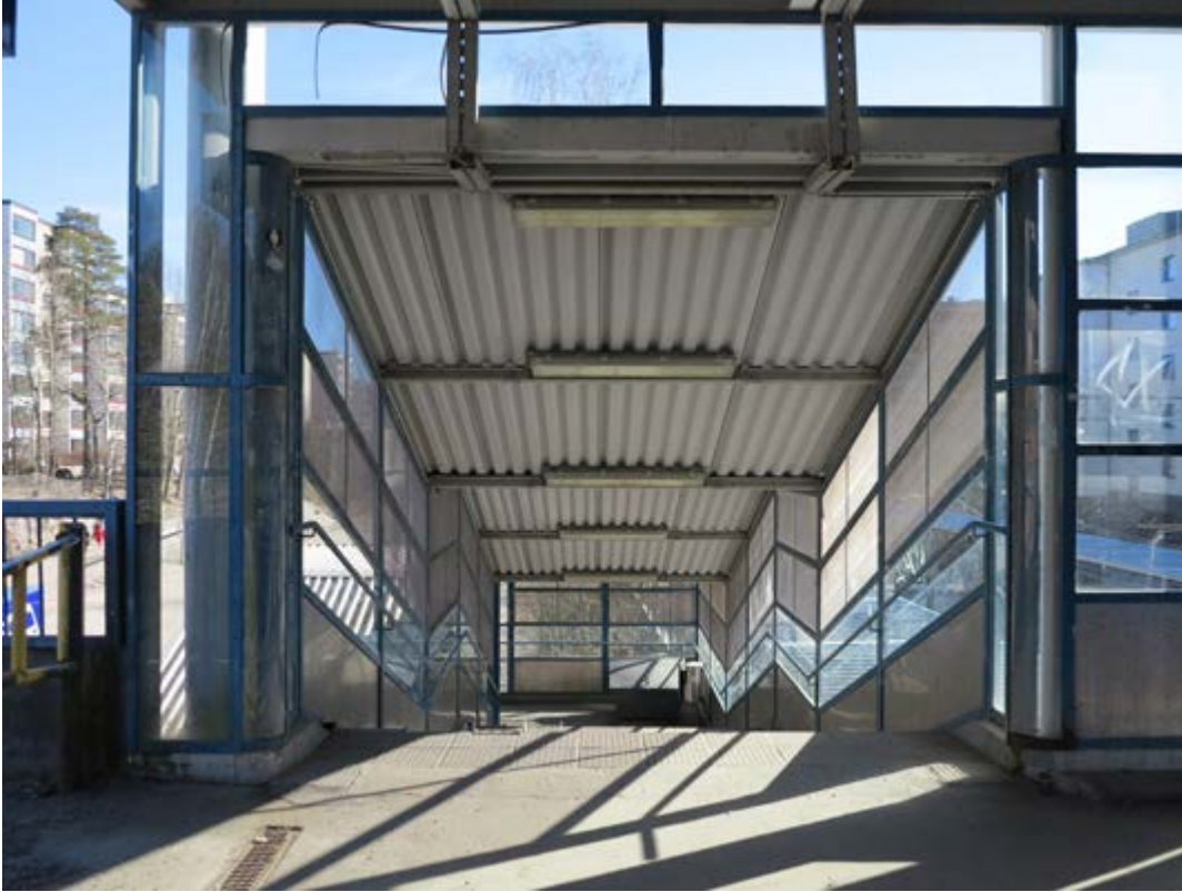
Radan koillispuolella on maantasolle johtavat kaksivartiset portaat.
