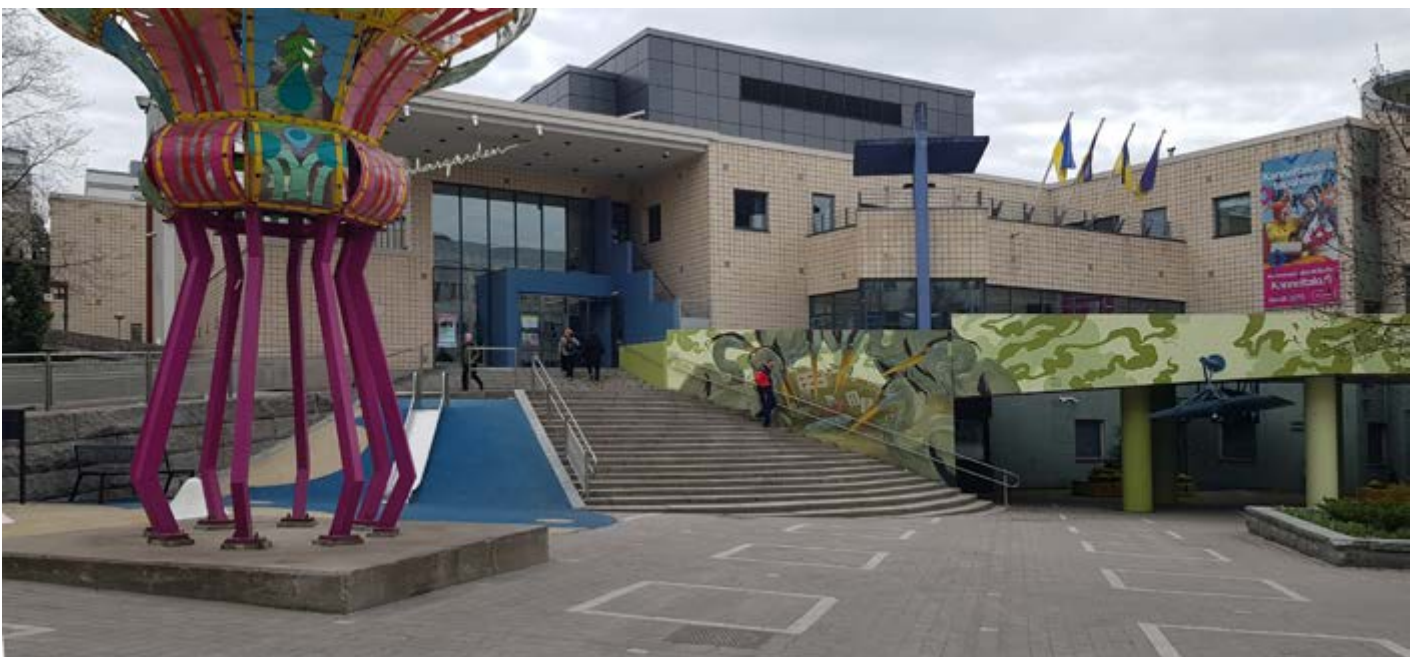
Kanneltalon, Rumpupolun ja Sitratorin jäsentely häivyttää rakennuksen ja julkisen ulkotilan rajan.
