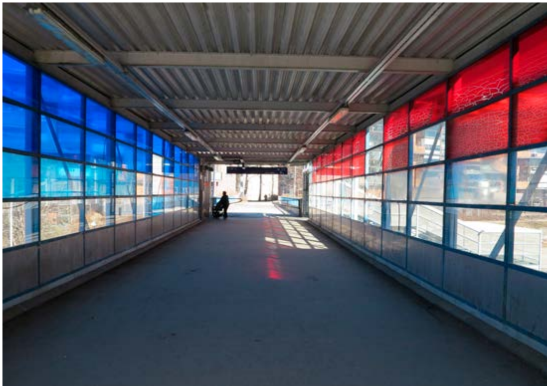
Aseman teräsristikkorakenteinen silta.
