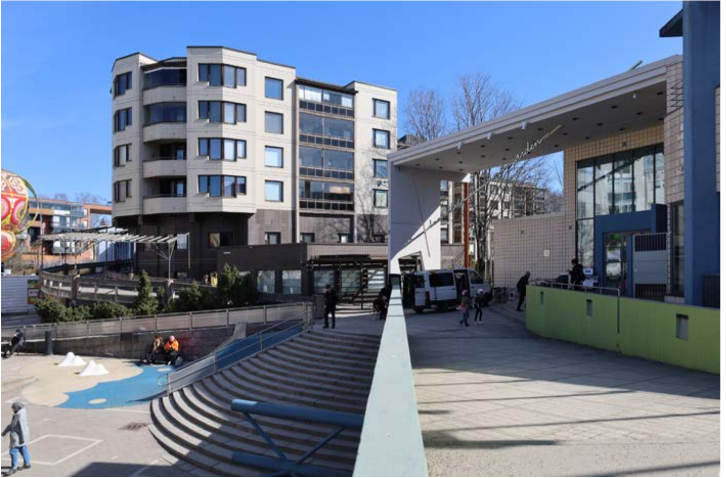
Näkymä Rumpupolulta koilliseen. Etualalla vasemmalla näkyy vuoden 1981 asemakaavaillustraation mukainen kuperan muotoinen avoporras. Portaan vieressä sijainnut katsomo on purettu ja korvattu liukumäellä. Portaan takana näkyy toritasoa ja Rumpupolkua yhdistävä luiska.
