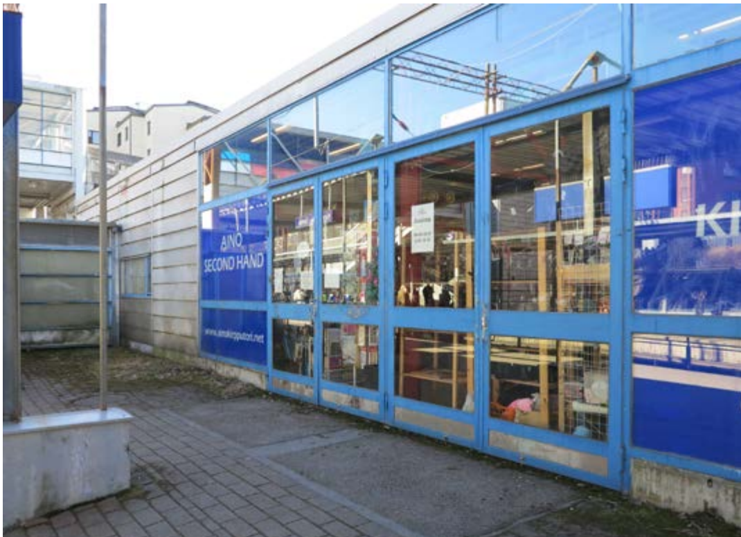
Aseman arkkitehdin, Paavo Mykkäsen suunnittelemat sirot teräsprofili-lasirakenteet.
