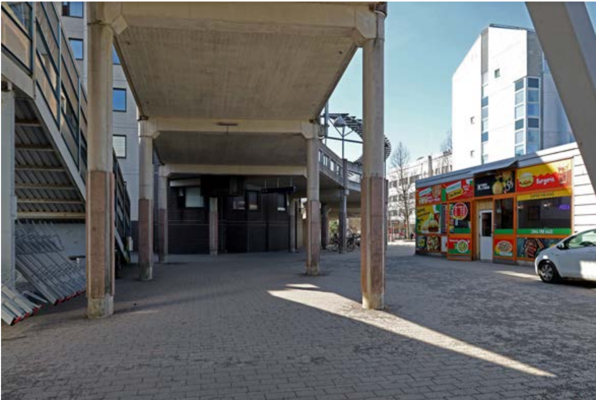
Näkymä aseman suunnalta kansirakenteiden alta. Kulkureittinä tämä vaikuttaa ahtaalta ja sokkeloiselta.
