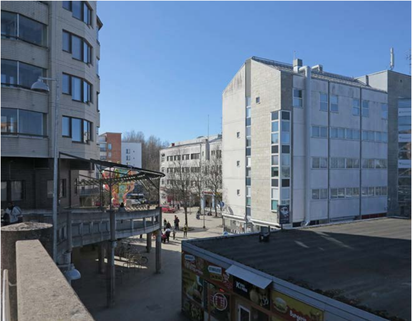
Näkymä Sitratoria kohti sillan kannelta katsoen. Entisen asemarakennuksen kulman ja kaarevan rumpupolun väliin jää mutkitteleva kulkureitti.
