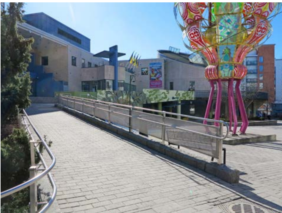
Sitratorilta Rumpupolulle johtava luiska. RST-suojakaiteita ja käsi-johteita on on lisätty mm. portaan viereen 2000-luvulla (HKR katu- ja puisto-osasto, Pöyry).
