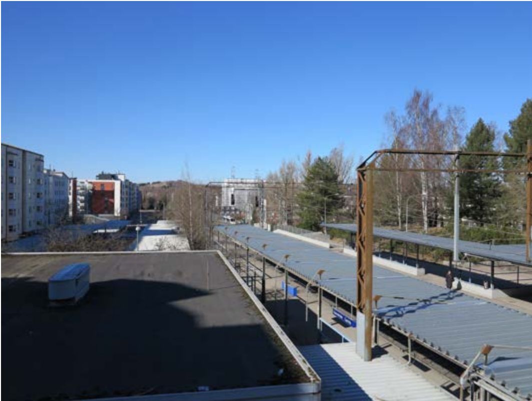
Näkymä radan ylittävältä sillalta luoteeseen, edessä vasemmalla entinen asemarakennus.
