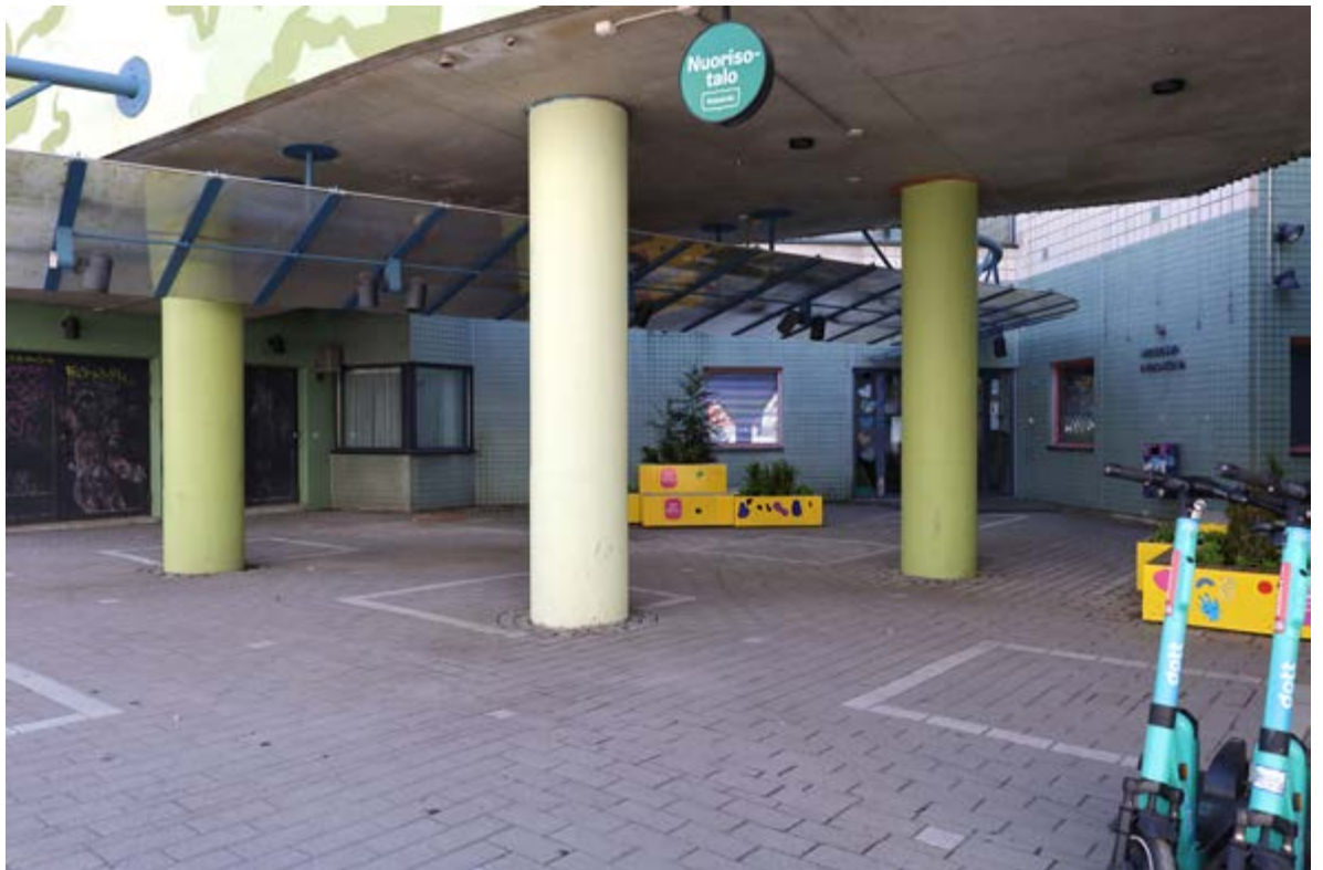
Kanneltalon nuorisotilojen sisäänkäynti sijaitsee siltarakenteiden katveessa.
