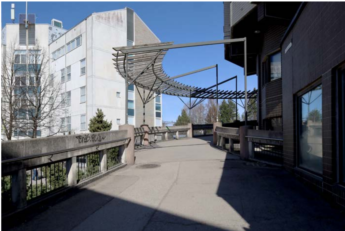
Asunto Oy Kannelkeskuksen kohdalla Rumpupolun silta on varustettu teräsrunkoisella pergolalla.
