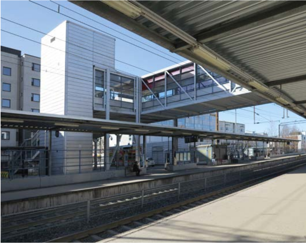
Näkymä idästä radan yli kohti aseman hissitornia ja siltaa.
