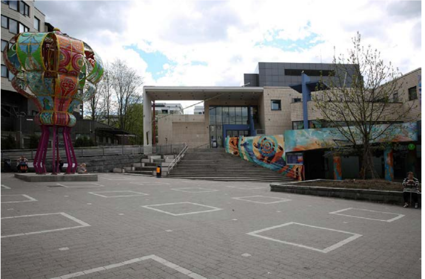
Kanneltalon torijulkisivun osa. Valokuvassa näkyvät kuperan portaikon vasemmalla puolella olevat istuimet, jotka purettiin leikkipaikan ja liukumäen rakentamisen yhteydessä. Kuva on otettu v. 2013 jälkeen. Arkkitehtuurimuseo.
