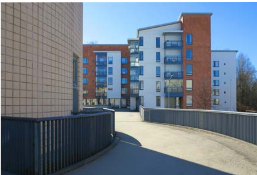
Kanneltaloa kiertävä kaareva silta muuttuu suoraksi ylittäessään Klaneettitien. Teräskaitteet jatkuvat tällä osuudella.
