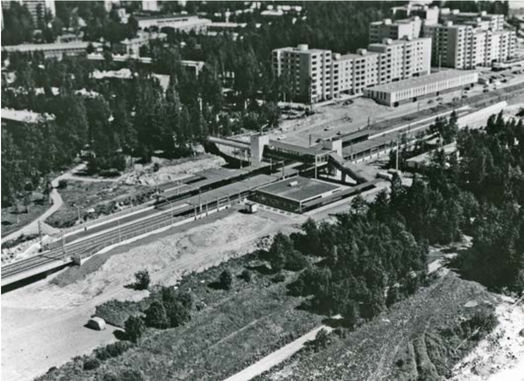
Viistokuva länsi-luoteesta oletettavasti pian aseman valmistumisen jälkeen. Kuvan keskellä näkyy yksikerroksinen asemarakennus. Kuvaajan nimi ei ole tiedossa. Suomen rautatiemuseo.
