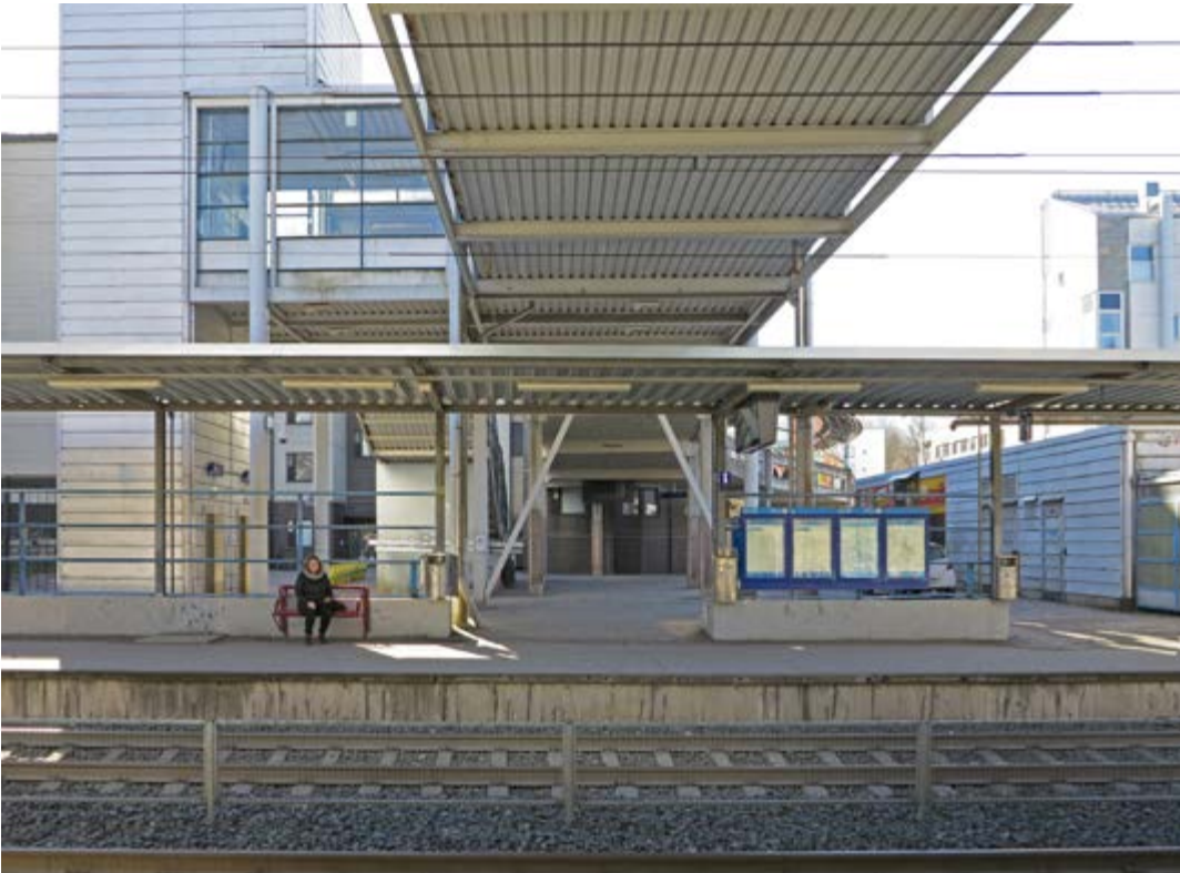
Näkymä koillisesta Sitratorin suuntaan radan ylittävän sillan kohdalla.
