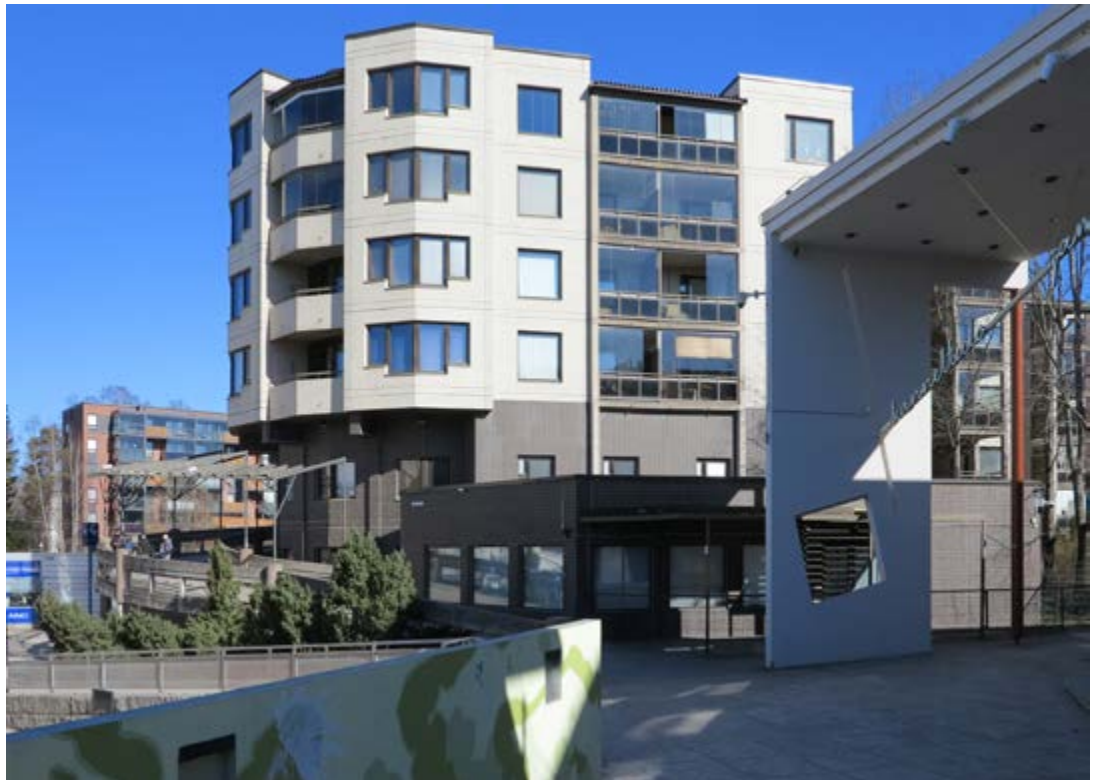
Asunto Oy Kannelkeskus. Julkisivuissa on käytetty vaaleaa ja tummanruskeaa klinkkerilaattaa.
