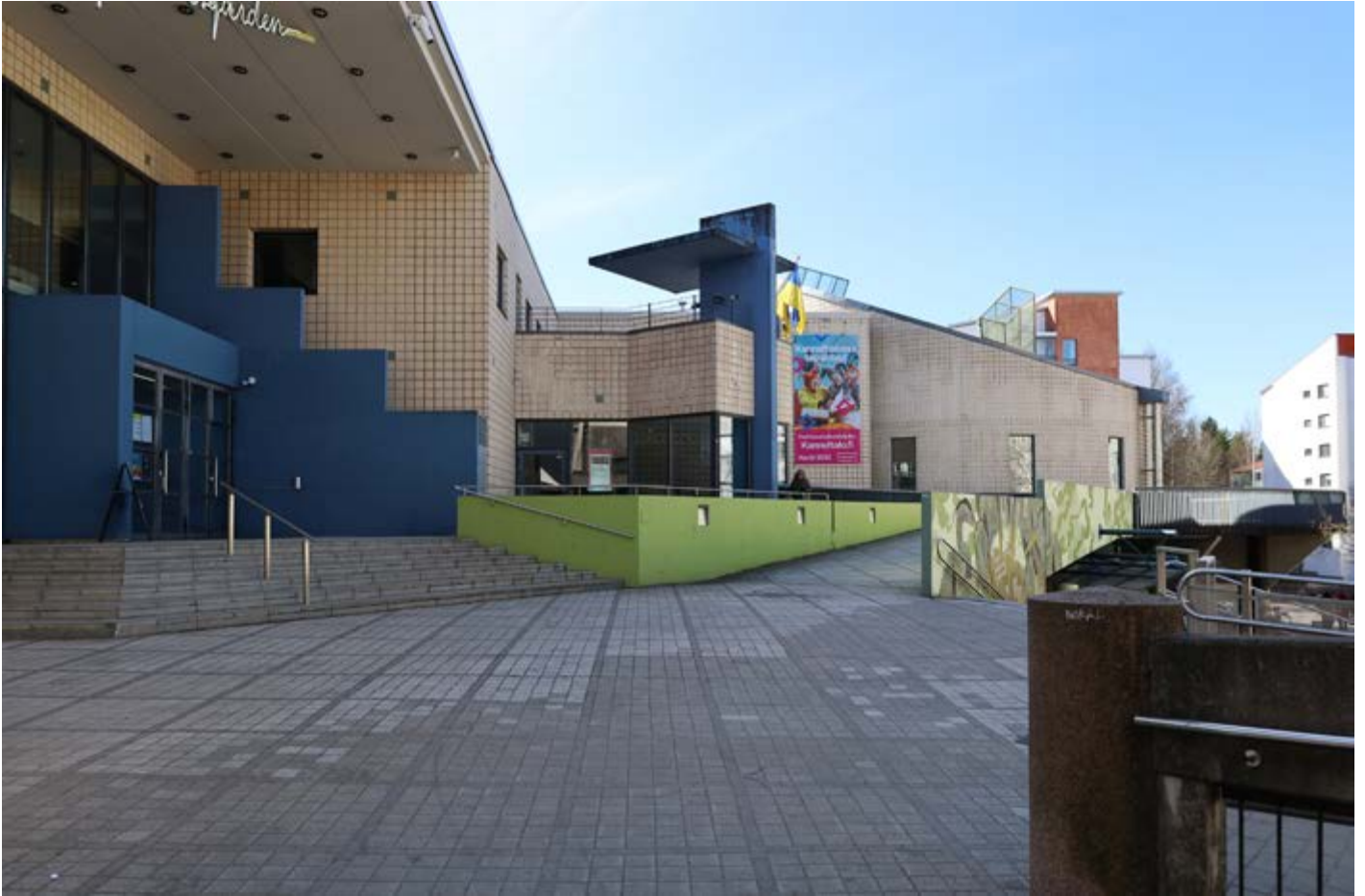
Kanneltalon sisäänkäynti sijoittuu ylemmälle tasolle Rumpupolun tasoon nähden. Vuonna 1992 laaditun kiveyssuunnitelman 26961 /10 mukaan tasanteella on Klaneettitien koordinaatistoa noudattava kiveyskuvio, joka koostuu valkoisista neliömäisistä betonikivistä ja harmaiden sauvakivilinjojen muodostamasta ruutukuviosta.
