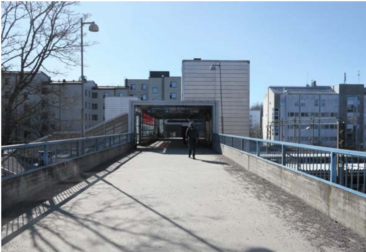
Rumpupolku aseman koillispuolella. Betonisilta johtaa aseman katetulle sillalle.
