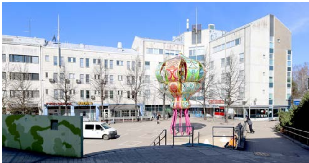
Korttelijulkisivu Sitratorille. Rakennukset ovat valmistuneet 1985. Vasemmalla Arkkitehtuuri-toimisto H. ja T. Seppälän suunnittelema Kiinteistö Oy Liikekannel, keskellä Suunnittelurenkaan suunnittelema Kiint. Oy Sitratori, oikealla Kahri Ky:n suunnittelema Kiinteistö Oy Sitratie 7.
