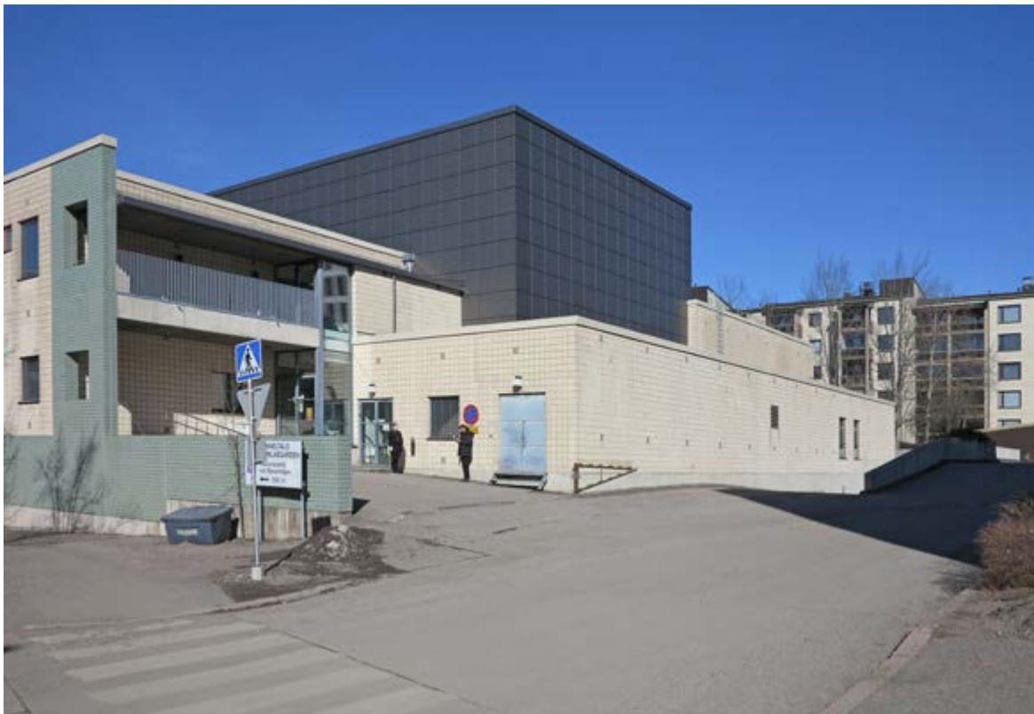
Kitarakuja ja Kanneltalon kaakkoisjulkisivu kuvattuna etelästä Klaneettitieltä.
