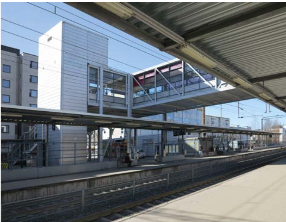
Aseman silta on siro teräsristikkorakenne 1970-luvulta. Teräsrakenteet vaihtuvat raskaaseen betoniin Rumpupolun uudempien rakenteiden kohdalla.
