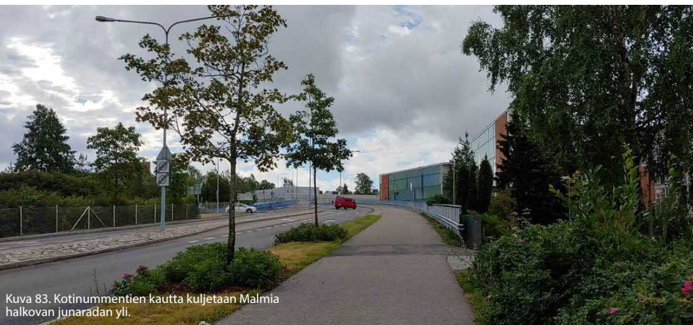
Kuva 82 Kaupparaitin päällystys on paikoin heikossa kunnossa.
