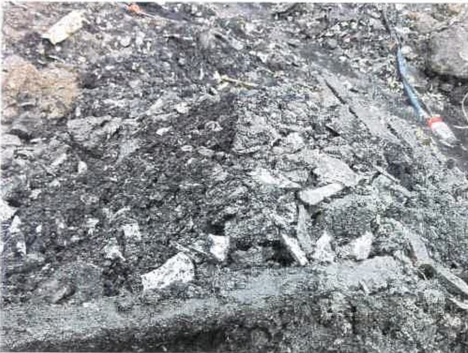
Kuvat 1 – 2 . Posliinijätettä L-talon kaivannossa
