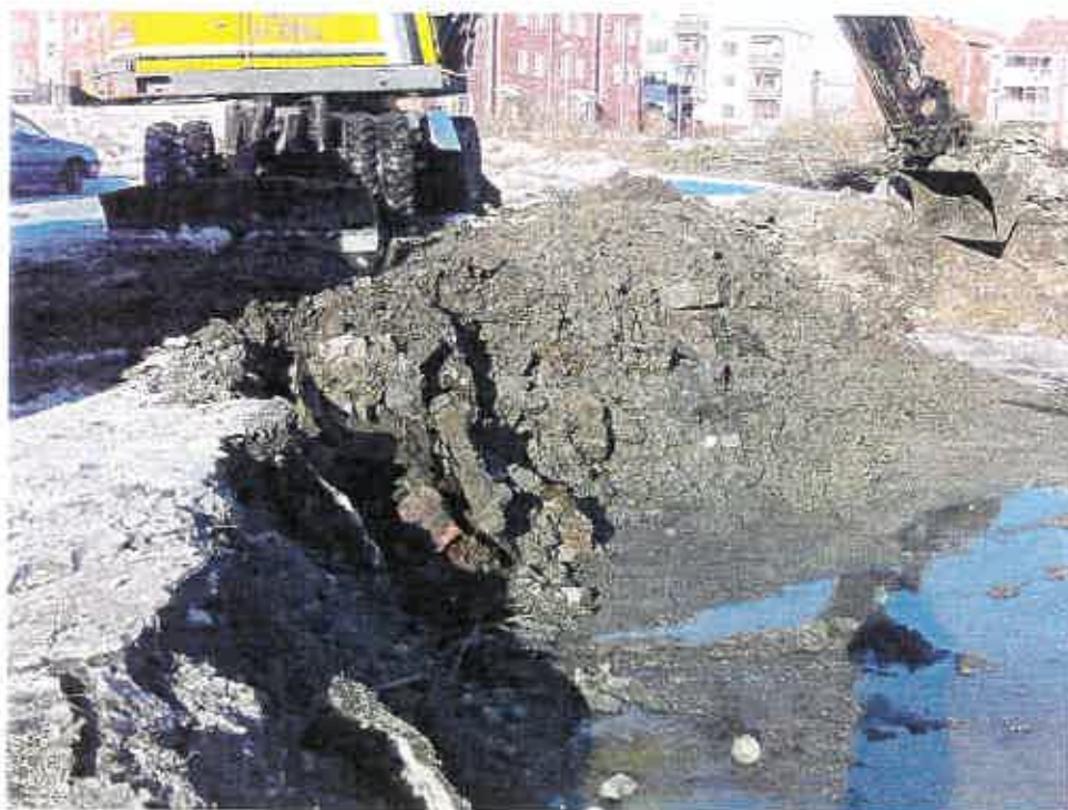
Kuva 4. L-talon kaivanto, reuna Jalo (piha I)
