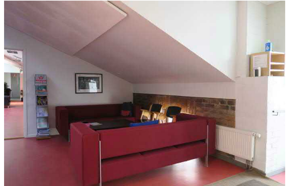
Käytäväosa (404) on katkaistu väliseinällä kahteen (ajoitus ei tiedossa). Katossa de-cocoat-vaimennuslevy.
