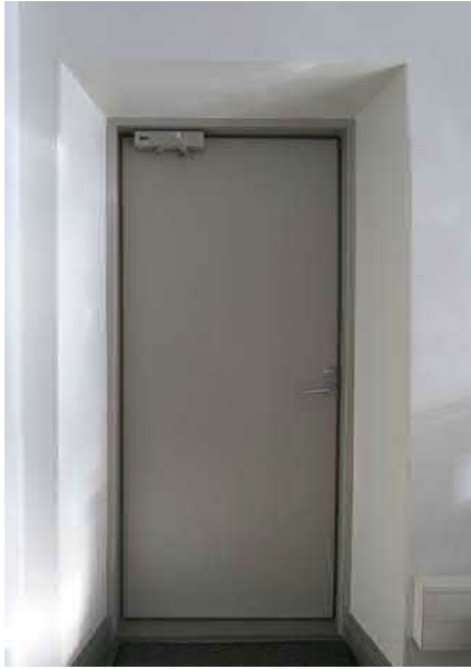
Porrashuoneen ovi huoneen puolelta, missä palo-osastoiva pellitysrakenne.
