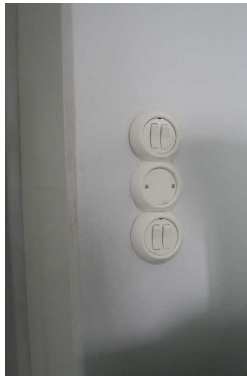
Renova-sarjan sähkökalusteet.
