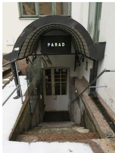
Historiallinen kellarin oven suojakatos, vasemmalla kuvattu- na 3/2004, oikealla 3/2024. Ahlmanin vaiheessa otsapellitys kasvoi paksummaksi, lisättiin käsijohde ja putoamista estävä lasirakenne.
