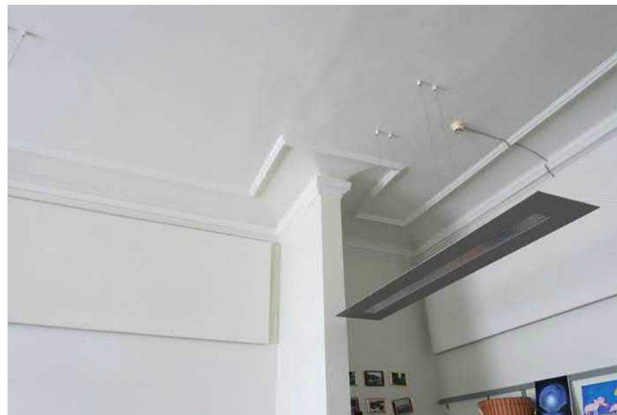
Vanha palomuuuri työntyy erikoisesti tilaan; kohta, jota vasten on ollut muurattuna kakluuni (kts. RHS 2004, s. 161)
