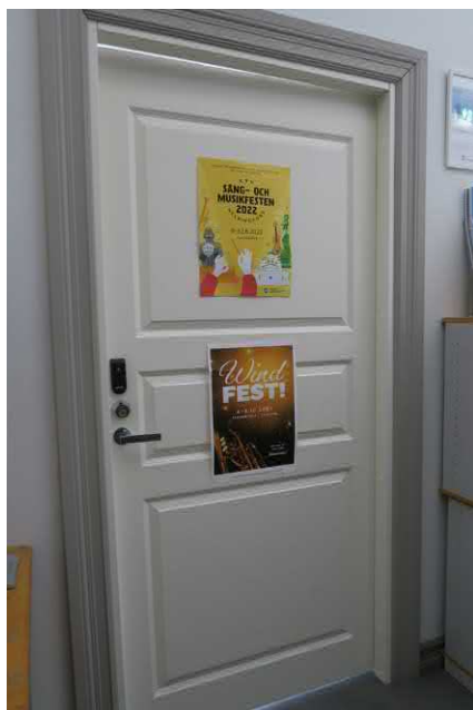
Toimistohuoneiden ovet ovat laminaattipuristeisiä "peiliovia", historisoivin listoituksin.
