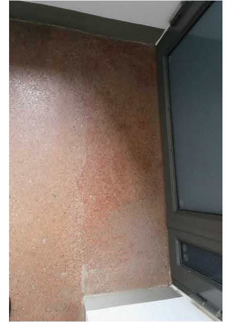
1,5-kerroksessa tehdyn uuden oviaukon edustalle on tehty punaista mosaiikkibetonia vastaava täydennys
