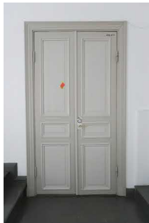
Alkuperäiset peliovet; NRT:n vaiheessa ovien huoneen puolelle tehty palosuojausrakenne.
