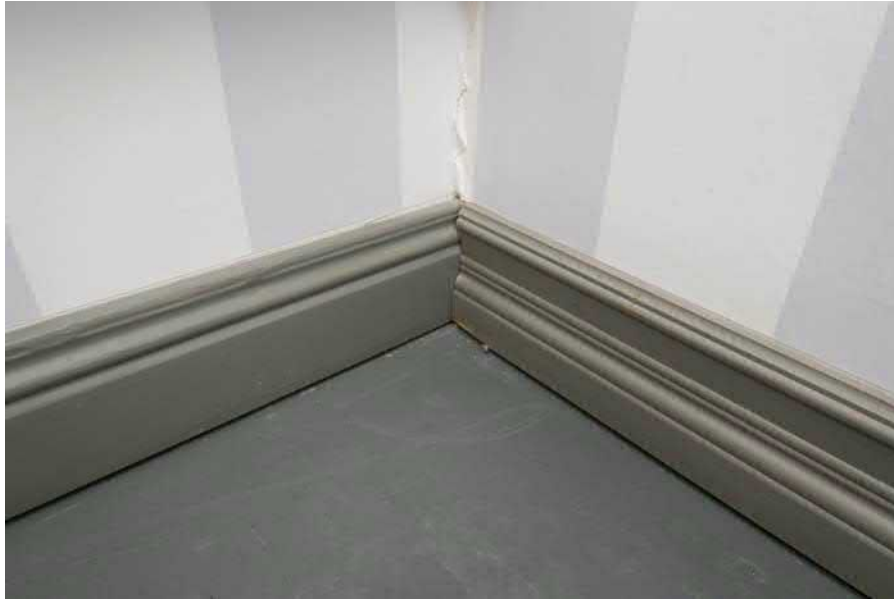
Talon alkuperäistä mallia noudattava profiilijalkalista JL1 kuvassa vasemmalla. Oikealla taas neuvotteluhuoneen "4" yhteydessä lisätty seinärakenne ja siinä voimakkaammin profiloitu historisoiva lista.
