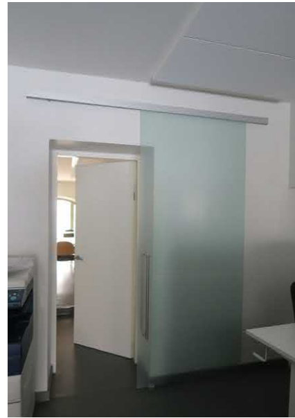
Ovi tilan 157 suuntaan; laakaovi + lasiliukuovi
