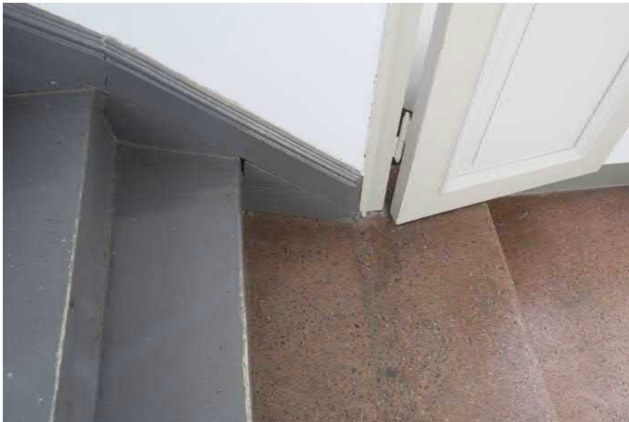
3,5-välitasanteella mosaiikkibetoni päättyy ja alkaa puinen porrasrakenne
