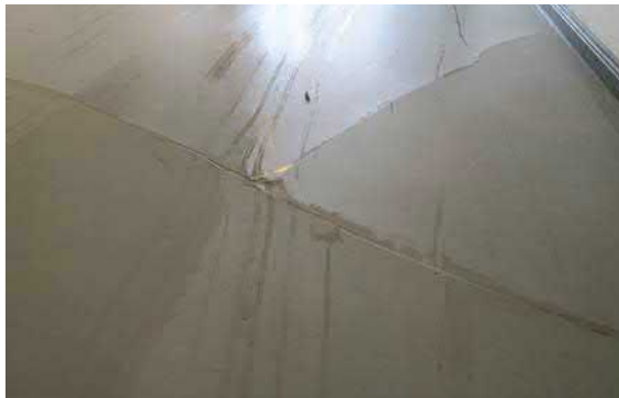
Yllä 2. kerroksen käytävän lattia, alla 1. kerroksen.
