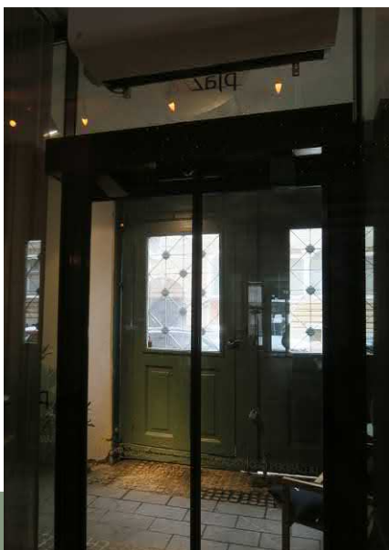
Katupuoolella on vanhat puiset porttikäytäväovet, tuulikaappirakenteen edustalla
