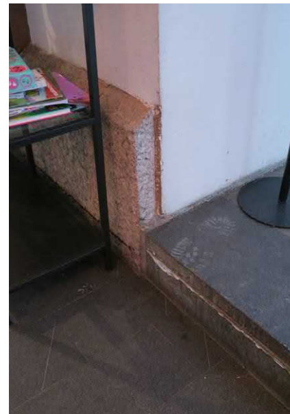
Salin ja aulan välille muodostuu osin kynnyks
