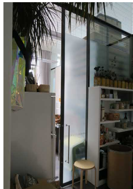
Tiloja 216 ja 217 (aula) erottava lasiseinä- ja liukuvoirakenne
