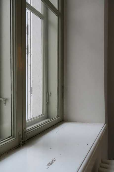
Vanhat ikkunat puisine ikkunapenkkeineen ja alkupeäisine heloineen on kunnostettu.
