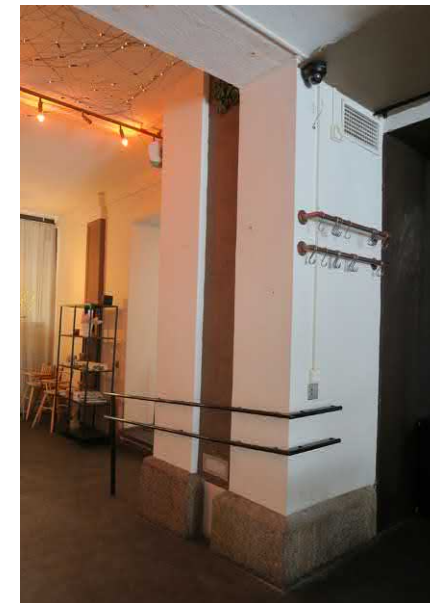
Viättävässä tilassa on käsijohteet
