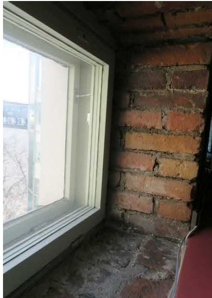
Ikkunat ovat NRT:n vaiheesta 3-kertaiset, kytketyin sisäpuitein.
