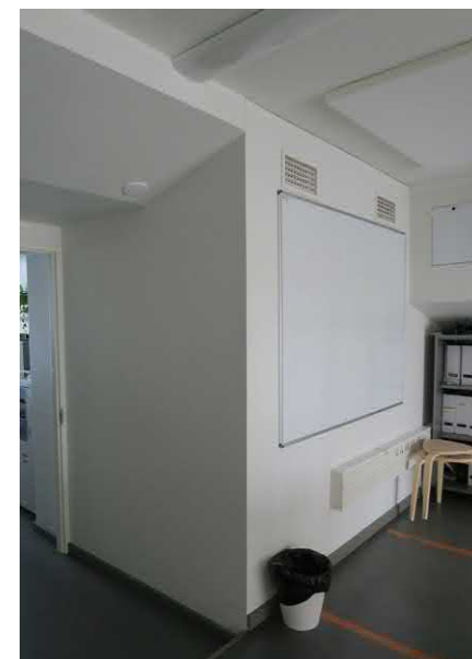
IV-pystykanavia peittävä kotelorakenne
