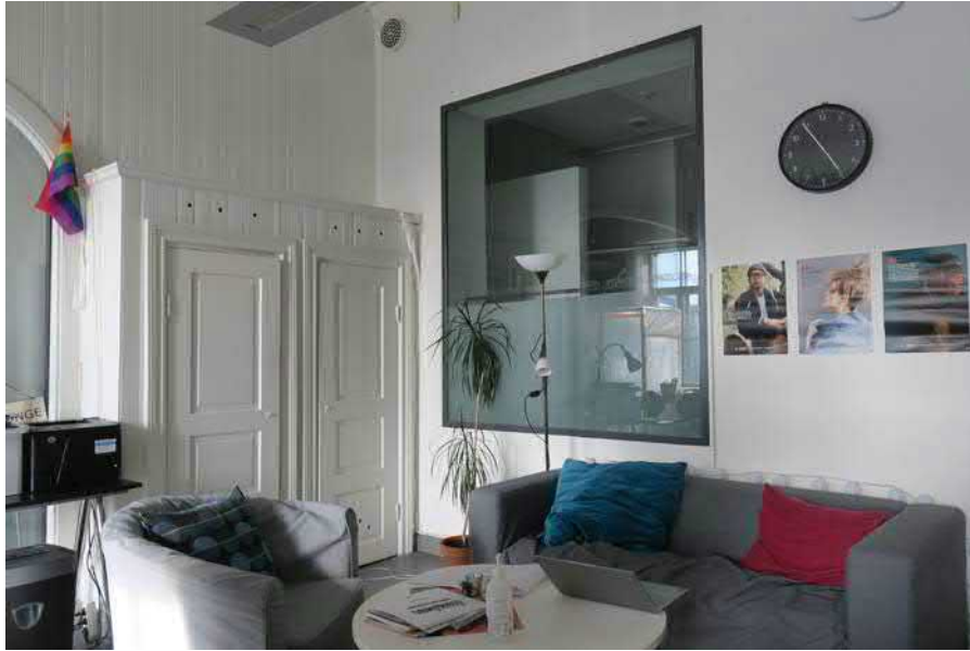
Kiinteät kaapit ja paneeliseinät kaariaukolla rakennettiin 1928 kotitalousluokkavaiheessa. Ahlmanin vaiheessa on puhkaistu kuvassa näkyvä ikkuna tilaan 418.
