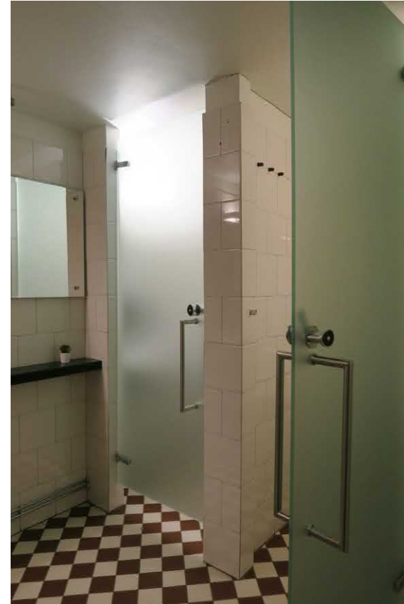
3/2024, esimerkki Ahlmanin vaiheen WC-tilasta ja laatoitustavasta.
