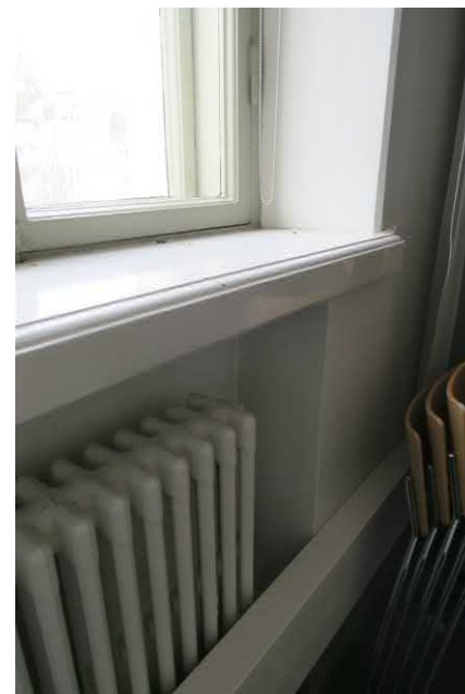
Sähkökouruasennus ja Siro-radiaattori
