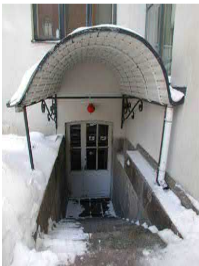
Historiallinen kellarin oven suojakatos, vasemmalla kuvattu- na 3/2004, oikealla 3/2024. Ahlmanin vaiheessa otsapellitys kasvoi paksummaksi, lisättiin käsijohde ja putoamista estävä lasirakenne.
