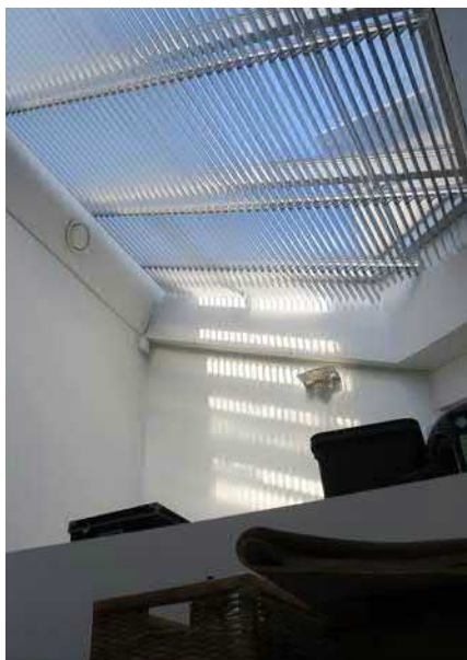
Katon lapeikkunoissa on varjostavat säleiverhot. Ilmanvaihdon pääte-elimet ovat harjalla.
