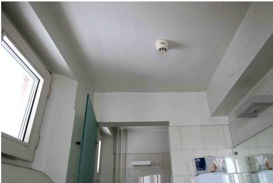
Kipsilevyalakattoa AK1, WC-tilassa 214 (esimerkki).
