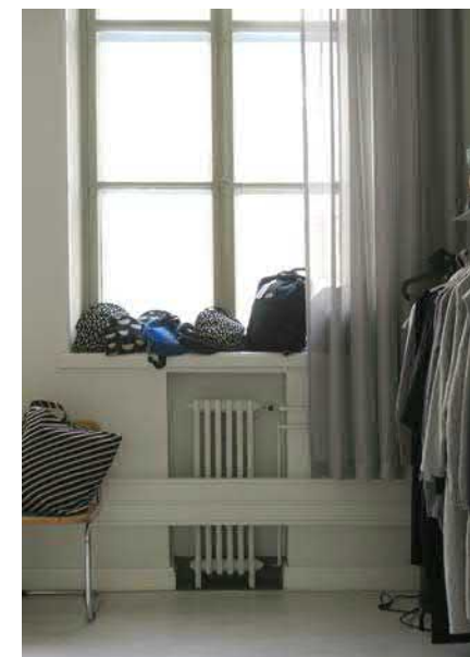
Yleisperiaatteen mukaisesti sähkökourut kulkevat radiattoreiden edestä.
