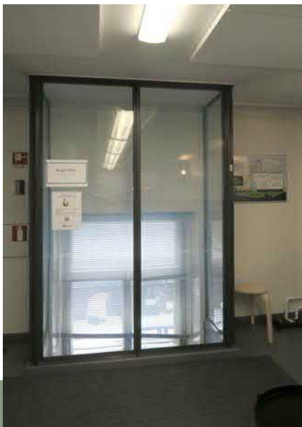
Tilan 158 pihapuolen vanha puolikerrokseen jäänyt ikkuna on rajattu lasirakenteella
