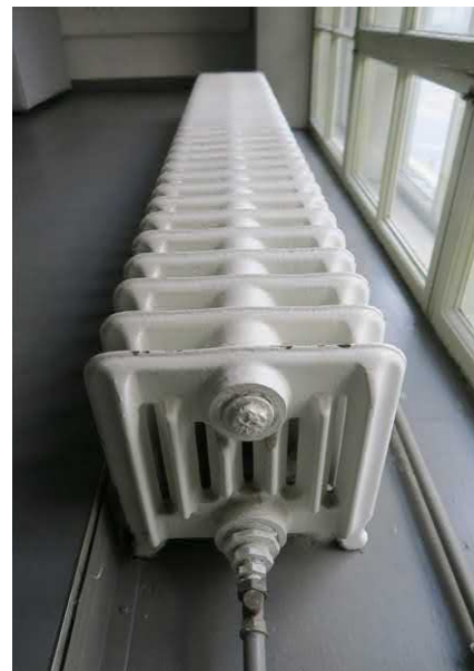
Matala radiaattori (1929?) edelleen käytössä, huone 157.
