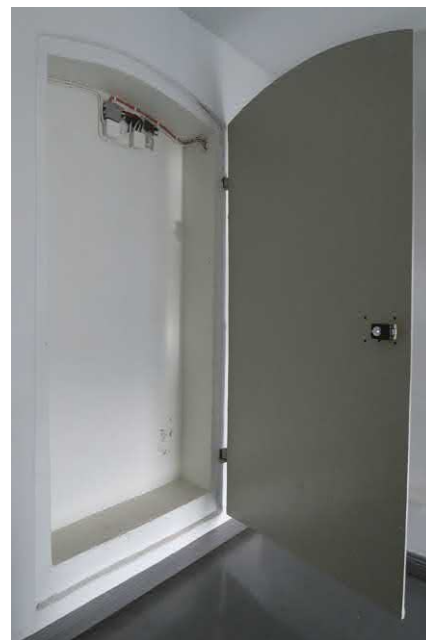
Entinen ullakon peltinen palo-ovi avattuna
