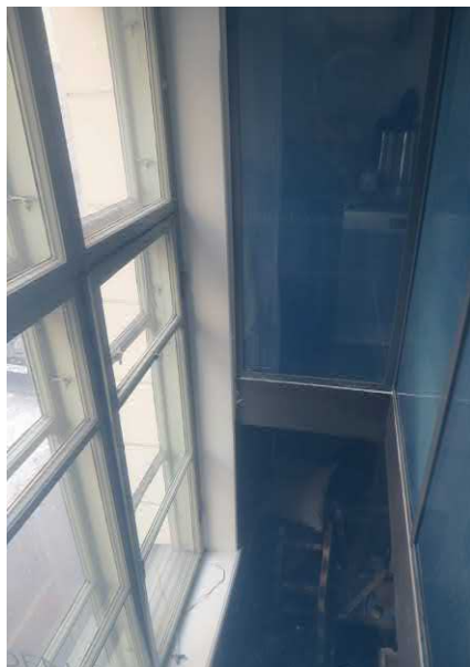
Tilan 159 katupuolen vanha puolikerrokseen jäänyt ikkuna on rajattu lasirakenteella
