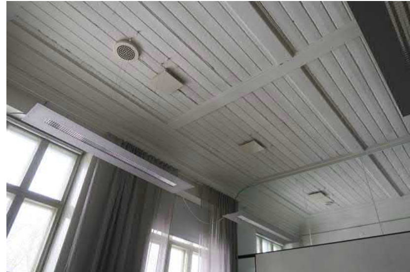
Kolmannen kerroksen ilmanvaihtoasennukset tehtiin ullakon kautta katto lävistäen.
