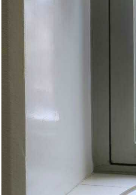
Smyygin maalin kiiltoaste on seiniä korkeampi
