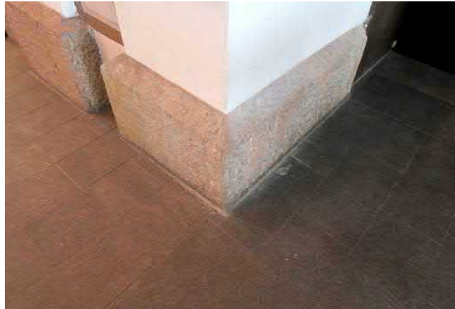
Entisen porttikäytävän vanha luonnonkivisokkeli on täydennetty uudella samansävyisellä graniitilla. Tila 122.
