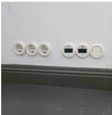
Ahlmanin vaiheen pistorasiat ja kytkimet ovat Renova-sarjaa.
