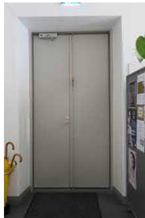
Alkuperäiset peliovet; NRT:n vaiheessa ovien huoneen puolelle tehty palosuojausrakenne.
