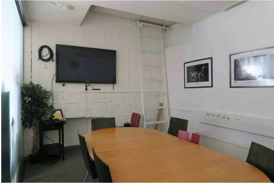
402 tilassa on huoltokäyntiporras hissien konehuoneelle / vesikatolle
