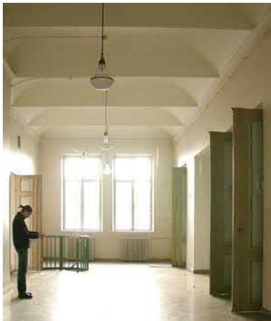
Yläkuva 3/2004, oikealla 3/2024. 3. kerroksen käytävä. 1- ja 2-kerroksen käytävistä poiketen Ahlmanin vaiheen valaisimet asennettiin kosketinkiskoihin, ei seinille.
