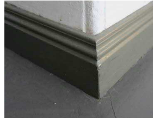
Tyypillinen JL 1 -tyypin jalkalista. Paikoin listat ovat vanhoja, paikoin uudempia vanhan mallin mukaan höylättyjä.
