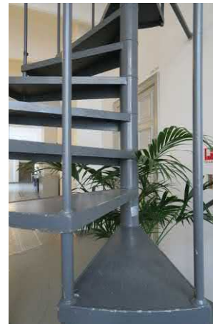
Ahlmanin työselitys 2004: "2-3 välinen kierreporras: Porras on valurautarakenteinen. Ei muutoksia."
