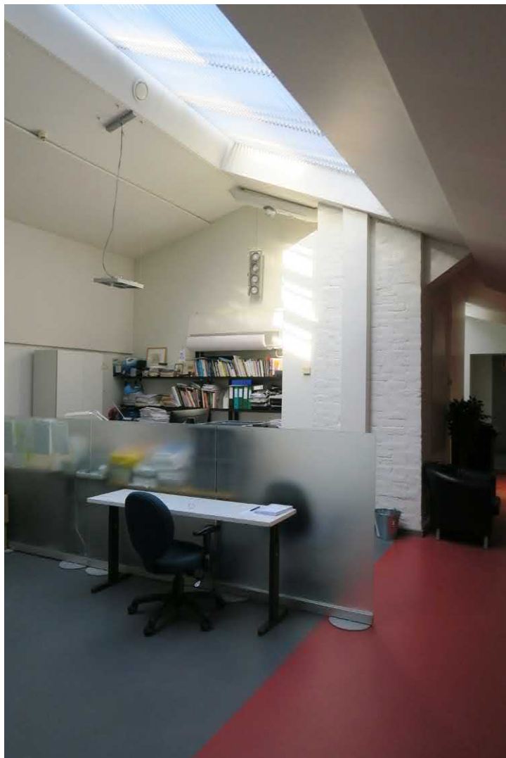
Ullakon toimistotilojen perusratkaisut ovat NRT:n vaiheesta, mutta Ahlmanin vaiheessa tiloja jakaneita kevyitä väliseiniä purettiin, lattian pintamateriaalit uusittiin, pinnat maalattiin ja uusittiin valaistus.
