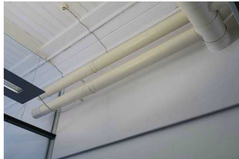
Kellarikerroksessa ja 1.-2. kerroksessa huoneiden kanavat asennettiin seinälle, tulo- ja poistokanavat päällekkäin ja vietyinä lasirakenteeseen leikatusta reiästä läpi.
