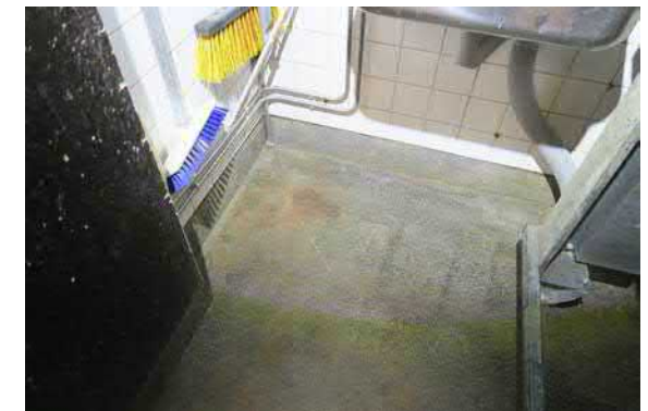
Keittiön 119 akryylibetonilattia ja pinnoitteen nosto seinille.
