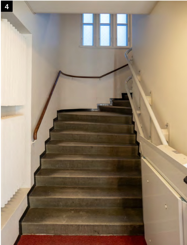
↑ Yläkellarin eteishalliin johtavan portaan tilahahmo on pääosin alkuperäinen. Portaan yhteyteen on lisätty kaidehissi vuonna 2016.
