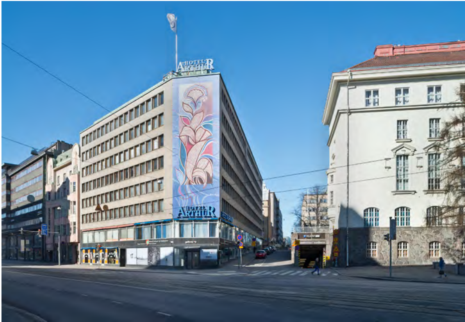
↑ NMKY:n hotelli- ja liikerakennus vuonna 2014 valokuvattuna. Kulmatontilla sijaitsevan rakennuksen julkisivu on rapattu vaaleanruskeaksi ja sen kulma Kaisaniemenkadun ja Puutarhakadun risteyksessä on viistetty, Juho Nurmi, HKM.
