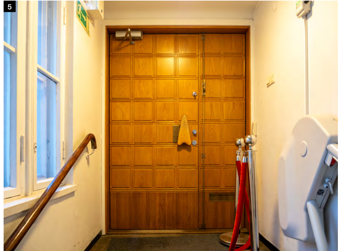
↑ Yläkellariin johtava umpinainen puinen peiliovi, joka on uusittu 2000-luvulla alkuperäisen mallin mukaiseksi. Ovessa on alkuperäinen nuolen mallisesti muotoiltu tamminen työntölevy, jossa on messinkikiinnikkeet.
