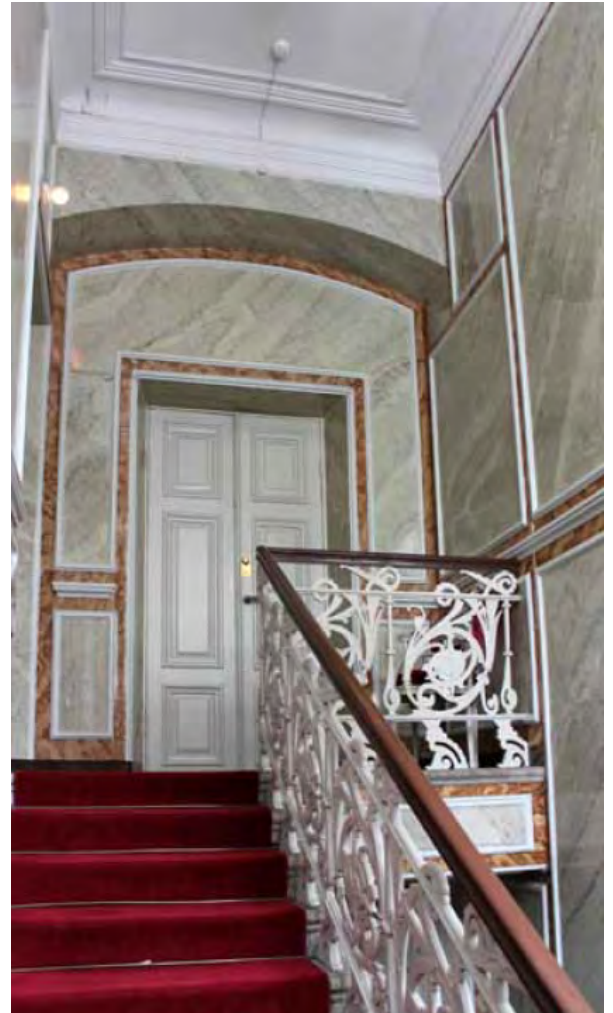
Keisarin aitiotiloihin johtava porrashuone. Kuva: Arkkitehtitoimisto Schulman Oy, 2015
