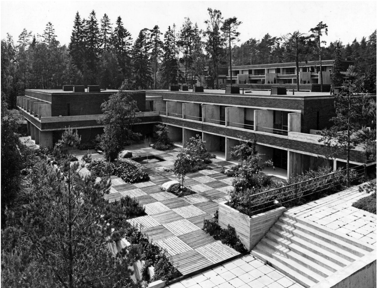
Kuva: Simo Rista. Alkon koulutuskeskus Vuorannan majoitusrakennus 1970-luvun alussa.
