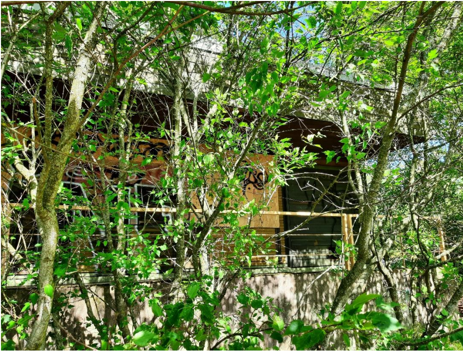
Alemman rakennuksen umpeenkasvanutta seinustaa.
