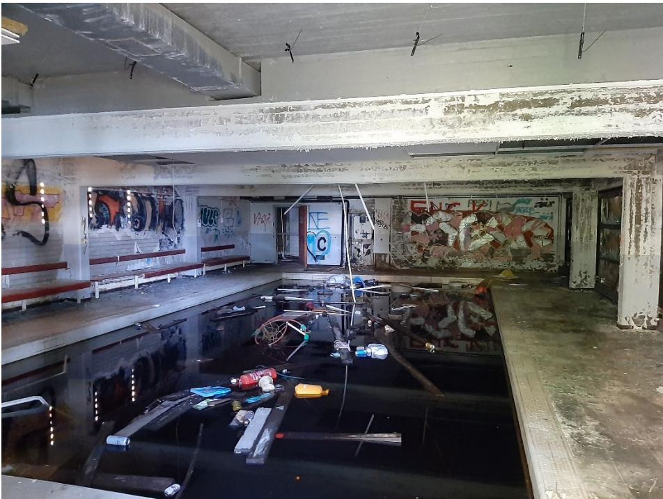
Alempaa rakennusta sisältä. Seinät ja katto ovat paljasta betonia, eikä lepakoille sopivia oleskelupaikkoja ole.
