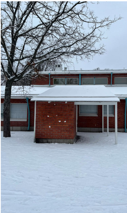
Kuva 2. Yksityiskohta pihan sisäänkäyntikatoksesta.
