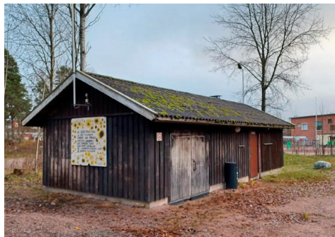
Kuva 4. Varastorakennus pihapiirin reunalla.
