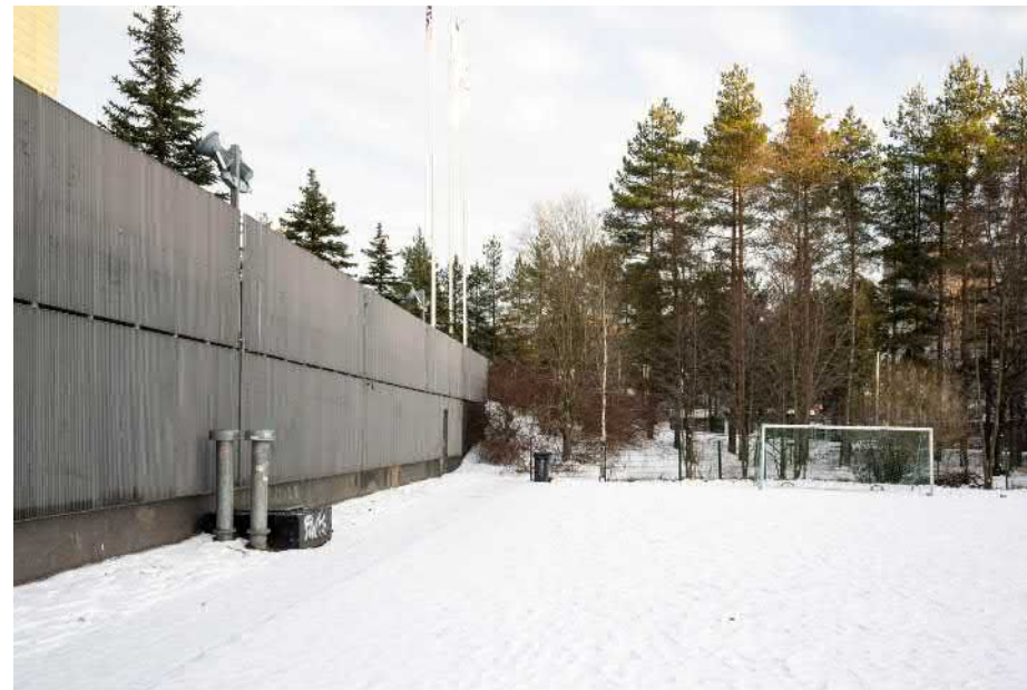
Pfizerin pääkonttori, julkisivu ja rakenteet tontin rajalla
