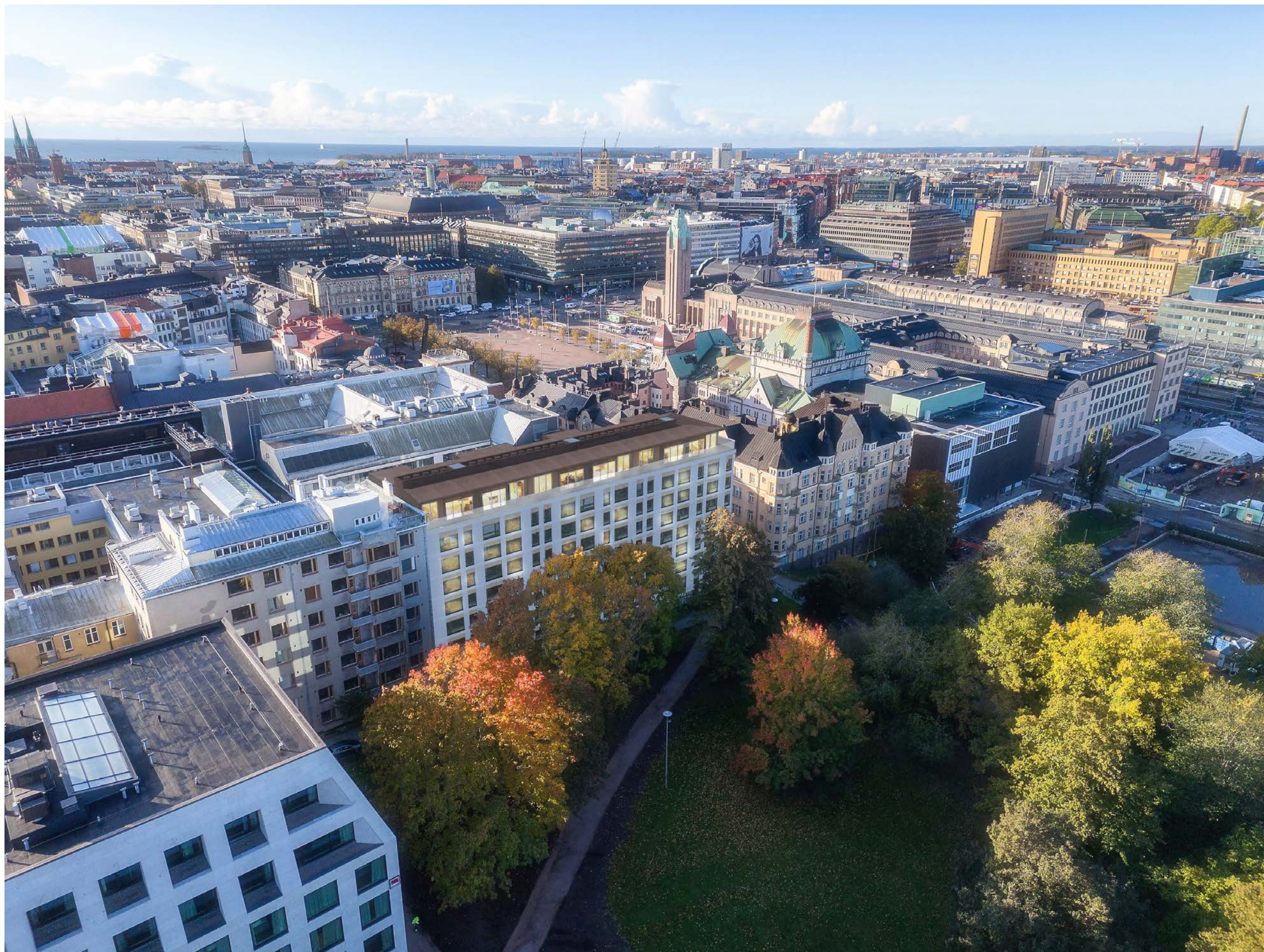
Näkymä puiston puolelta: lisärakentaminen ja uusi julkisivu
