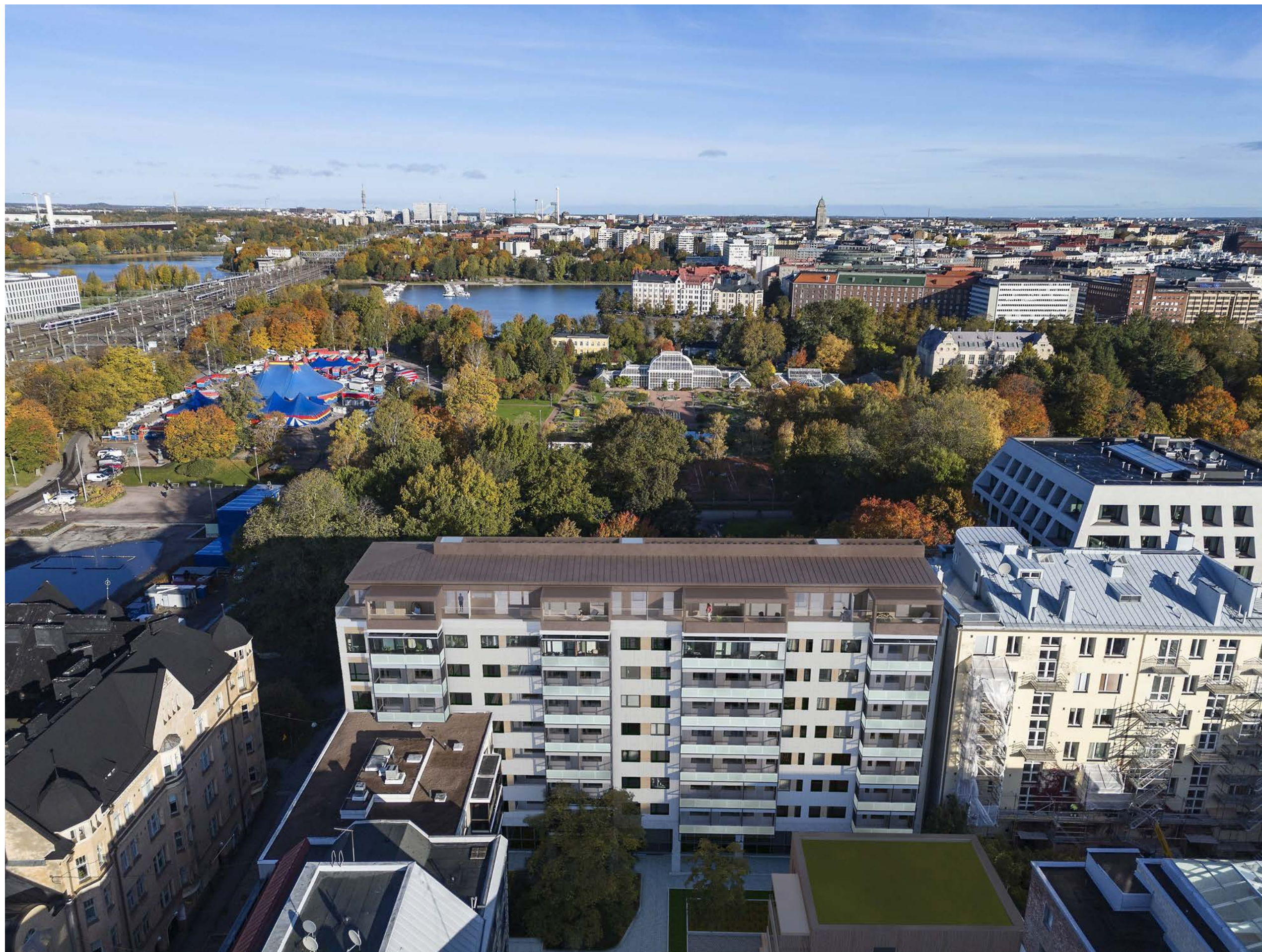
Näkymä etelästä: lisärakentaminen ja uusi julkisivu
