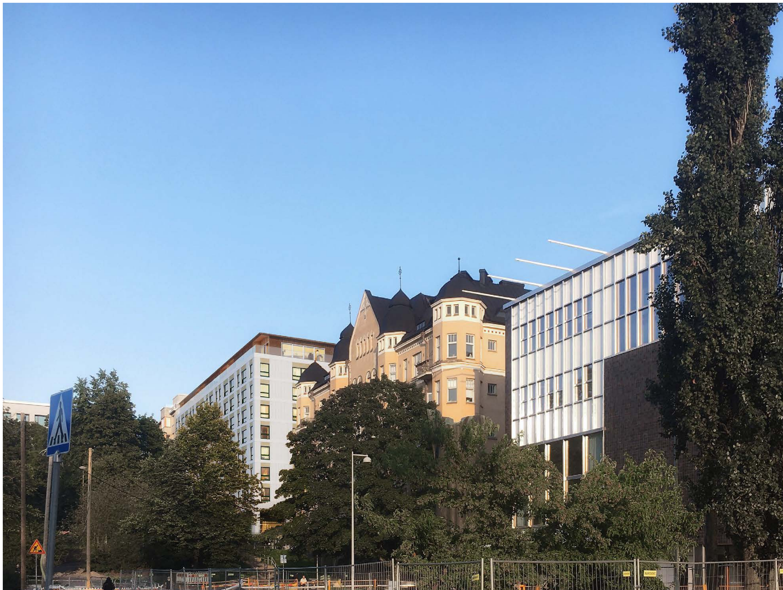
Näkymä puiston puolelta: lisärakentaminen ja uusi julkisivu
