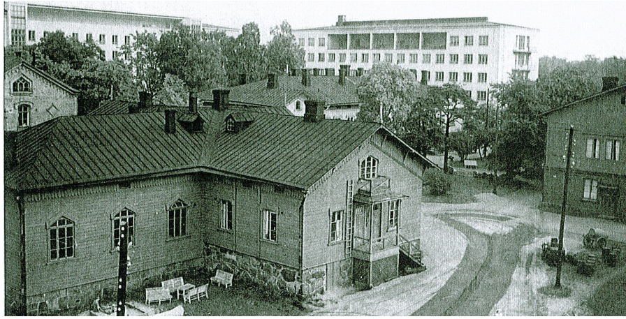
Kuvassa näkyy sairaalan puurakennuksia vuoden 1949 elokuussa Eino Heinosen kuvaamana. Etualalla on 1960-luvulla purettu läntinen sivurakennus. HKM
