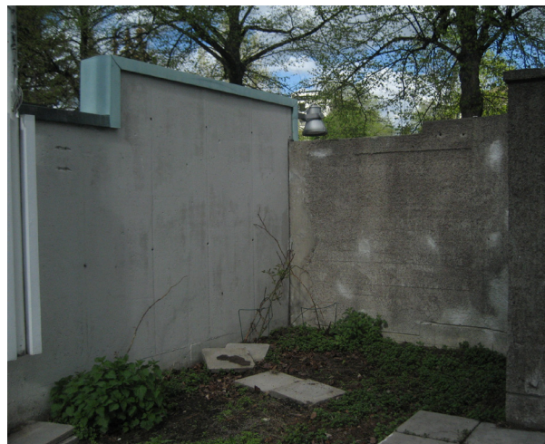
1940- ja 1960-luvun muurien liittyminen toisiinsa ruumishuoneen pohjoispäässä.
