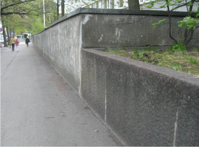
Graniittitukimuurin liittyminen betonimuriin Sibeliuksenkadulla.
