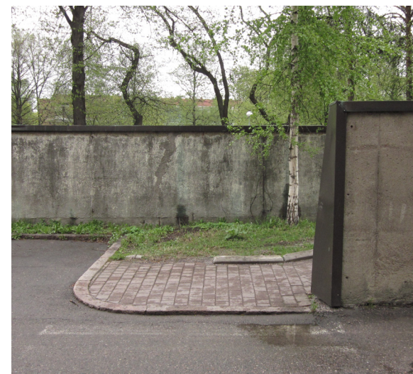
Rapattu betonimuuri Sibeliuksenkadun ja Välskärinkadun kulmassa.
