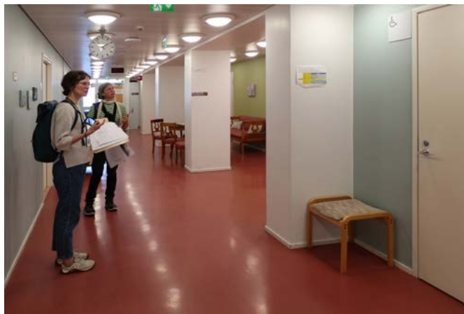
↑ Jalustaosan ja B-osan nivelkohdassa alkuperäinen pilari-palkkiratkaisu on edustavasti esillä.
