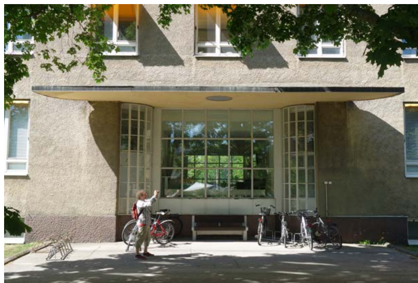
↑ Entinen porttikäytävä pihan puolelta nähtynä. Läpinäkyvyys säilyi osin, kun porttikongin molempiin päihin asennettiin teräslasiseinät. Nämä ovat 1970-luvun suunnitelmien mukaiset. Kaarevat ikkunat ovat todennäköisesti edelleen alkuperäiset.
