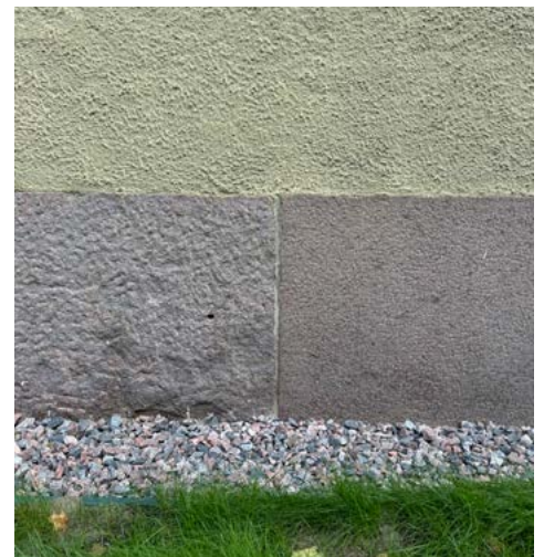
↑ ↘ Puretun pääsisäänkäynnin paikka erottuu kellarikerroksesta puuttuvista ikkunoista sekä sokkelin grafiittipinnan poikkeavasta käsittelystä. amoy 2024
