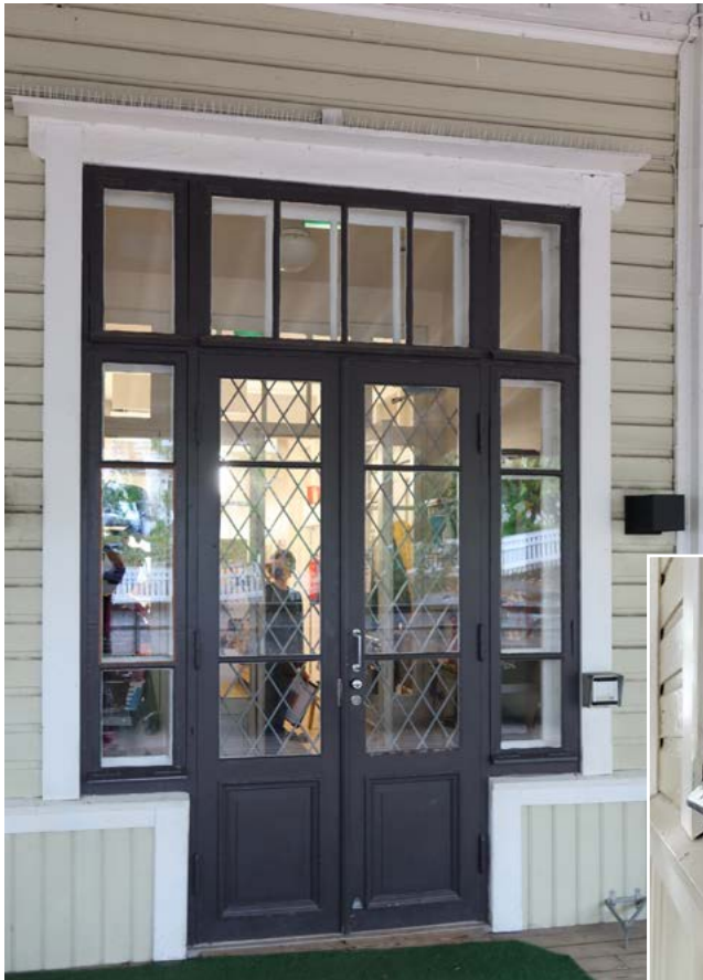
↑ Rak. 14. Avoverannan ulko-ovi, tuulikaapin ovi sekä niihin liittyvät lasiseinärakenteet ovat alkuperäisiä. amoy 2024
