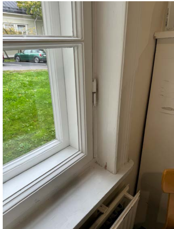
↑ Rakennuksen 13 alkuperäinen ikkuna ja vuorilista. amoy 2024
