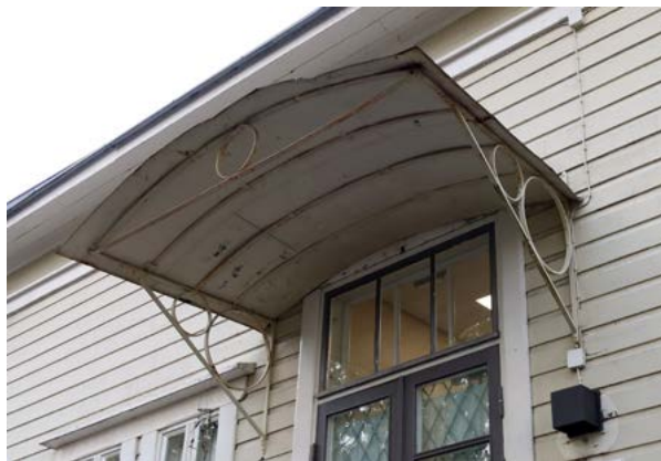
↑ Rakennuksen 14 pohjoisen sivusiiven sisäänkäyntikatos. amoy 2024
