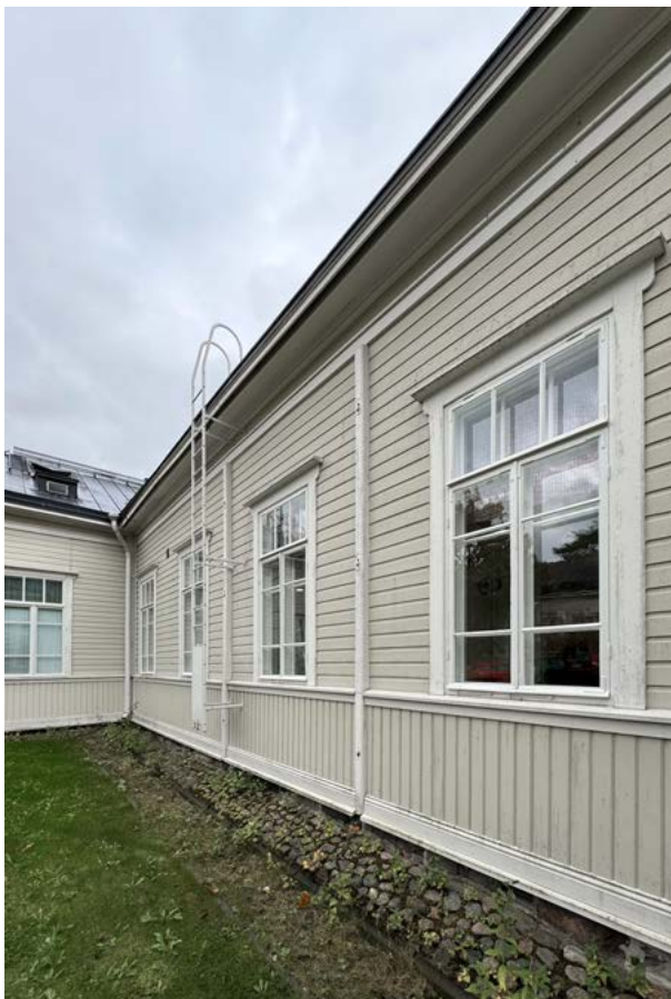
↑ Rakennuksen 13 keskikäytävän ikkunaseinän ikkunat ja mahdollisesti myös niiden väliset följarit ovat alkuperäiset. amoy 2024
