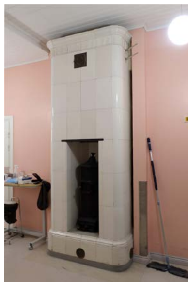
↑ Keskikäytävän alkuperäinen kaakeliuuni rakennuksessa 12. amoy 2024
