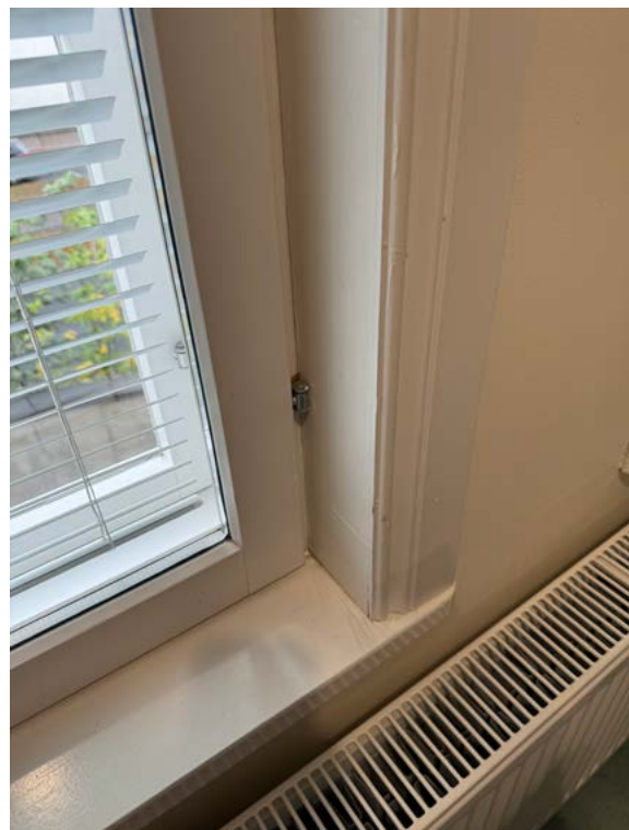
↓ Rakennuksen 13 uusittu ikkuna. amoy 2024
