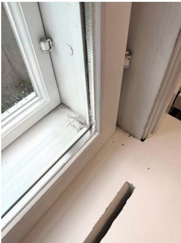
↑ Rakennuksen 14 uusittu perusikkuna. amoy 2024
