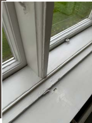
Rak. 13. Keskikäytävän alkuperäisikkunoiden vanhaa detailjointia ja heloitusta. amoy 2024
