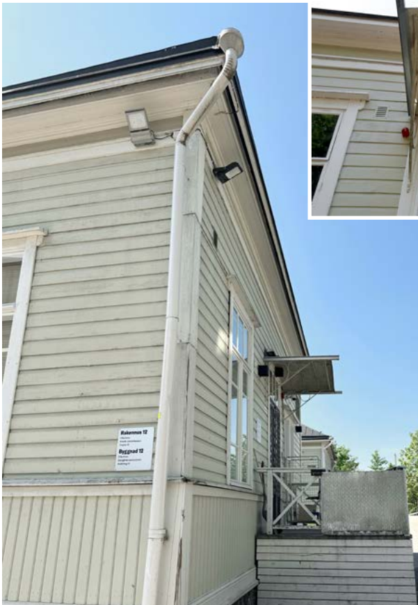
↓ Rak 13. Vesikaton alkuperäinen räystäskotelo on alapuolelta näkyvissä uuden räystäsrakenteen sisällä (vrt. rakennuksen 12 räystäsrakenne vieressä kuvassa). amoy 2024
