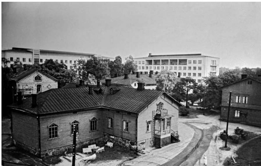
↑ Kuva Eino Heinonen v. 1949. HKA
