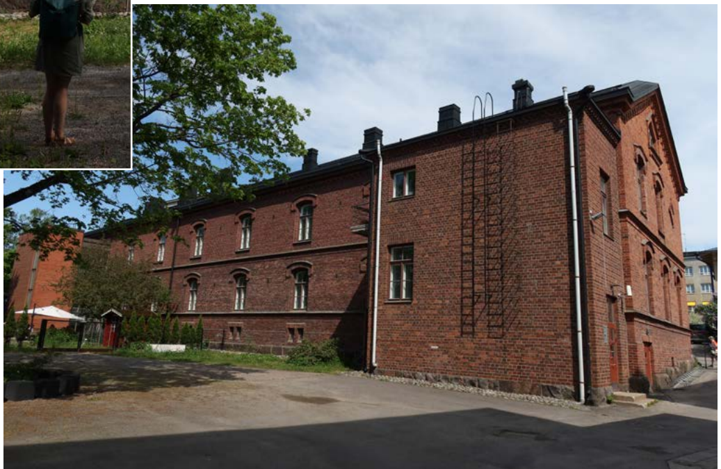
↓ Kellariin oli alun perin käynti myös takajulkisivulta, heti piha-aidan vieressä olevan kellarinikkunaparin kohdalta. Ikkunan holvaus on suora, kuten vanhimmassa osassa muuallakin. Piirustusten mukaan takajulkisivun yksittäiset ikkunat ovat saaneet myöhemmin vierelleen parin; ajoitus ei ole tiedossa. amoy 2024
