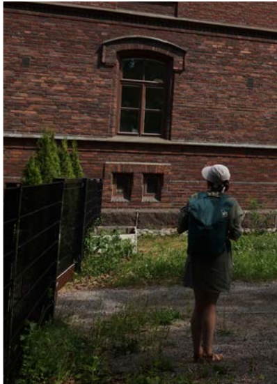
↓ Kellariin oli alun perin käynti myös takajulkisivulta, heti piha-aidan vieressä olevan kellarinikkunaparin kohdalta. Ikkunan holvaus on suora, kuten vanhimmassa osassa muuallakin. Piirustusten mukaan takajulkisivun yksittäiset ikkunat ovat saaneet myöhemmin vierelleen parin; ajoitus ei ole tiedossa. amoy 2024
