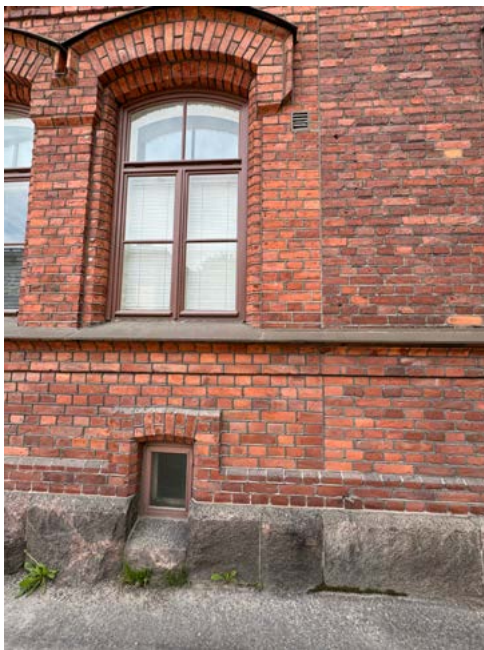
↑ Eteläinen laajennus erottuu pystysaumana julkisivussa. Koristelu on säilynyt samanlaisena, vain pienin vivahde-eroin. amoy 2024
