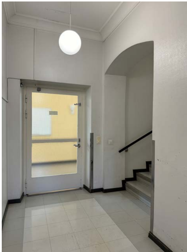
↑ Käytäväseinällä on ensimmäisen porrassyöksen kohdalla ollut alun perin aukko, ovi tai ikkuna. Aukkoa on muokattu jo ensimmäisen laajennusvaiheen yhteydessä. Mahdollisesti myös porrassyöksiä on muutettu. Myös toisessa kerroksen vastaa- vassa kohdassa olevalla lepotasolla on ollut aukko.
