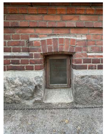
↑ Kaariholvattu kellarinikkuna pohjoisella laajennusosalla. amoy 2024
