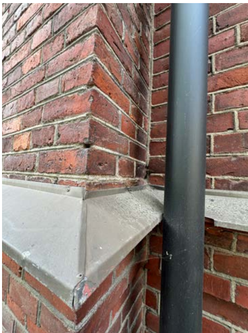
↑ Pohjoinen laajennusvaihe erottuu risaliitin oikealla puolella suorana liitossaumana sisänurkassa. Vasemmalla puolella sama kohta on tehty kokonaan ensimmäisessä vaiheessa, jolloin tiilet limittyvät toisiinsa eikä sauma ole suora. amoy 2024
