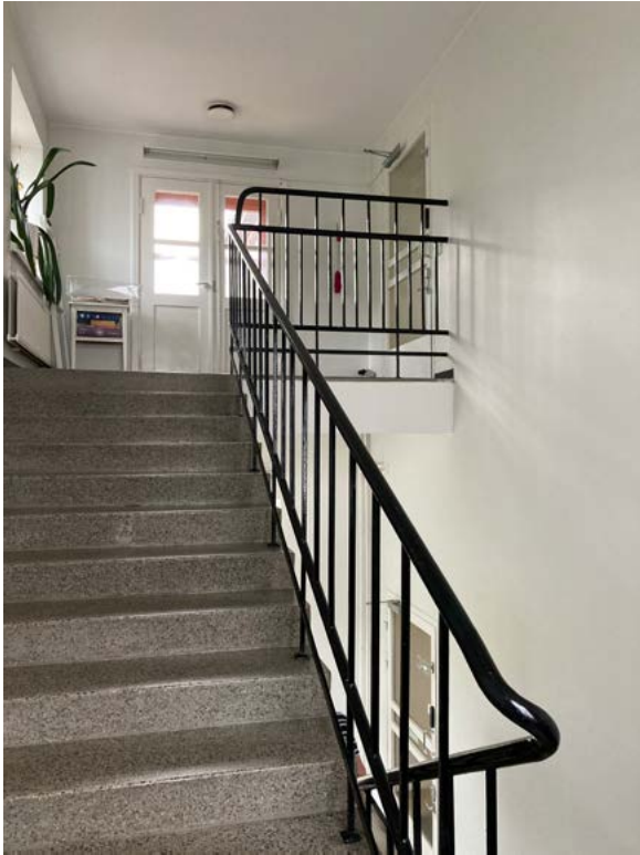
↑ Eteläinen porrashuone pohjoista kohti katsottaessa. Suljetut ikkuna-aukot eivät ole sivuseinällä enää näkyvissä. amoy 2024
