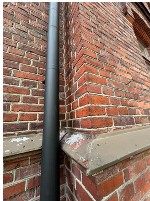
↑ Pohjoinen laajennusvaihe erottuu risaliitin oikealla puolella suorana liitossaumana sisänurkassa. Vasemmalla puolella sama kohta on tehty kokonaan ensimmäisessä vaiheessa, jolloin tiilet limittyvät toisiinsa eikä sauma ole suora. amoy 2024
