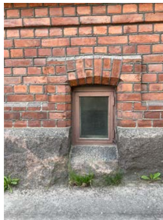
↑ Kaariholvattu kellarinikku- na eteläisellä laajennusosalla. amoy 2024
