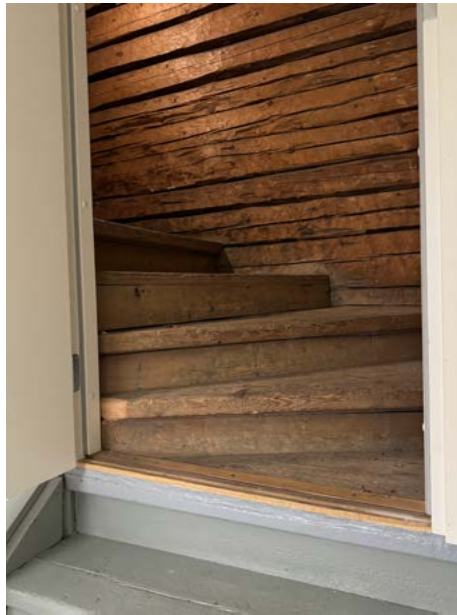
Ullakon porras ja ovi takajulkisivun keskisalista porrashuoneeseen näyttäisivät säilyneen vanhalla paikallaan. amoy 2024
