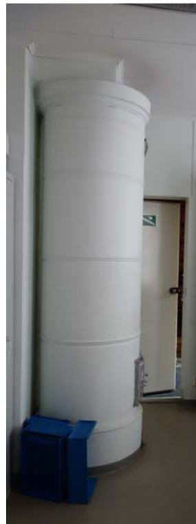
Ylemmän kerroksen peltipintaisia pönttöuuneja, tavallisten pyöreiden lisäksi harvinaisempi leveämpi ja kantikkaampi malli.
