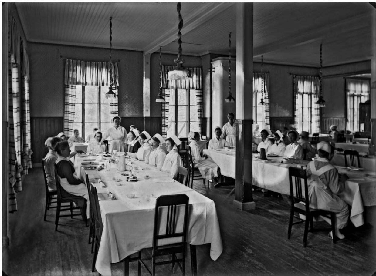
↑ Ruokasali. Kuva sähköjen asentamisen jälkeen, arviolta 1910-luvun loppupuolelta tai 1920-luvulta. (Rafael?) Roos. HKM.
