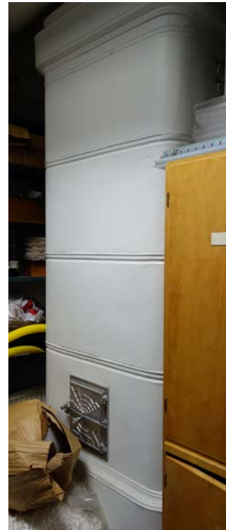
Ylemmän kerroksen peltipintaisia pönttöuuneja, tavallisten pyöreiden lisäksi harvinaisempi leveämpi ja kantikkaampi malli.
