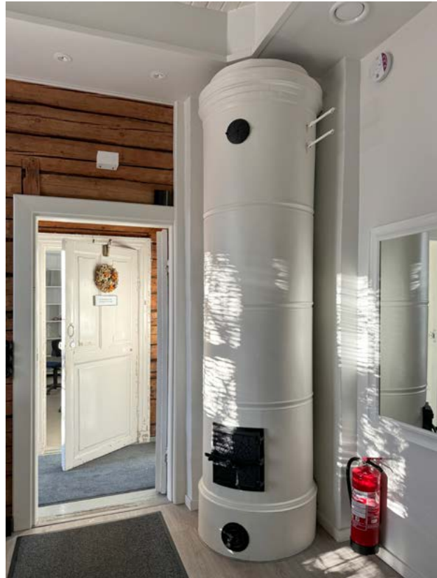
Ylemmän kerroksen peltipintaisia pönttöuuneja, tavallisten pyöreiden lisäksi harvinaisempi leveämpi ja kantikkaampi malli.
