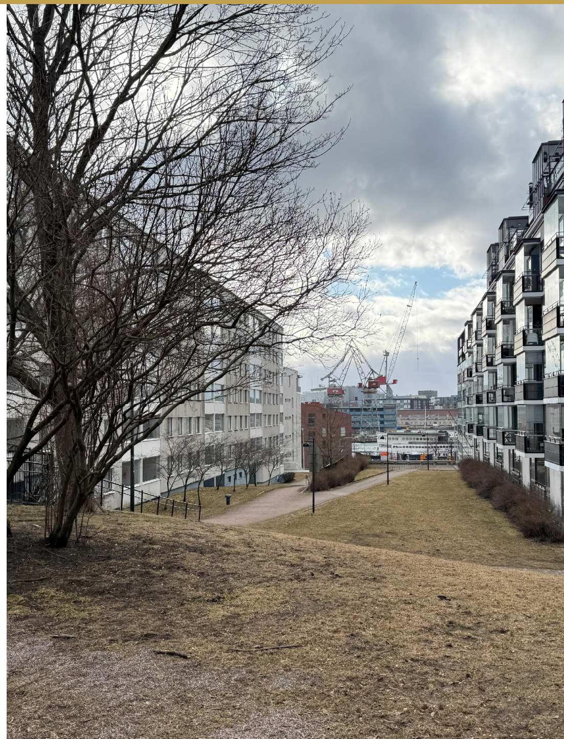
Pitkä näkymälinja kohti Hietalahdenrantaa. Puiston alla kulkee Mallaskatu. Kuvat: Aapo Niinikoski
