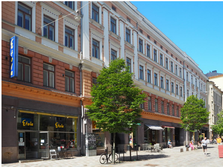
Iso Roobertinkatu 3-7(rakennusmestari E. Sihvola ja arkkitehtitoimisto Kiseleff & Heikel), Kuva: Elina Jaara
