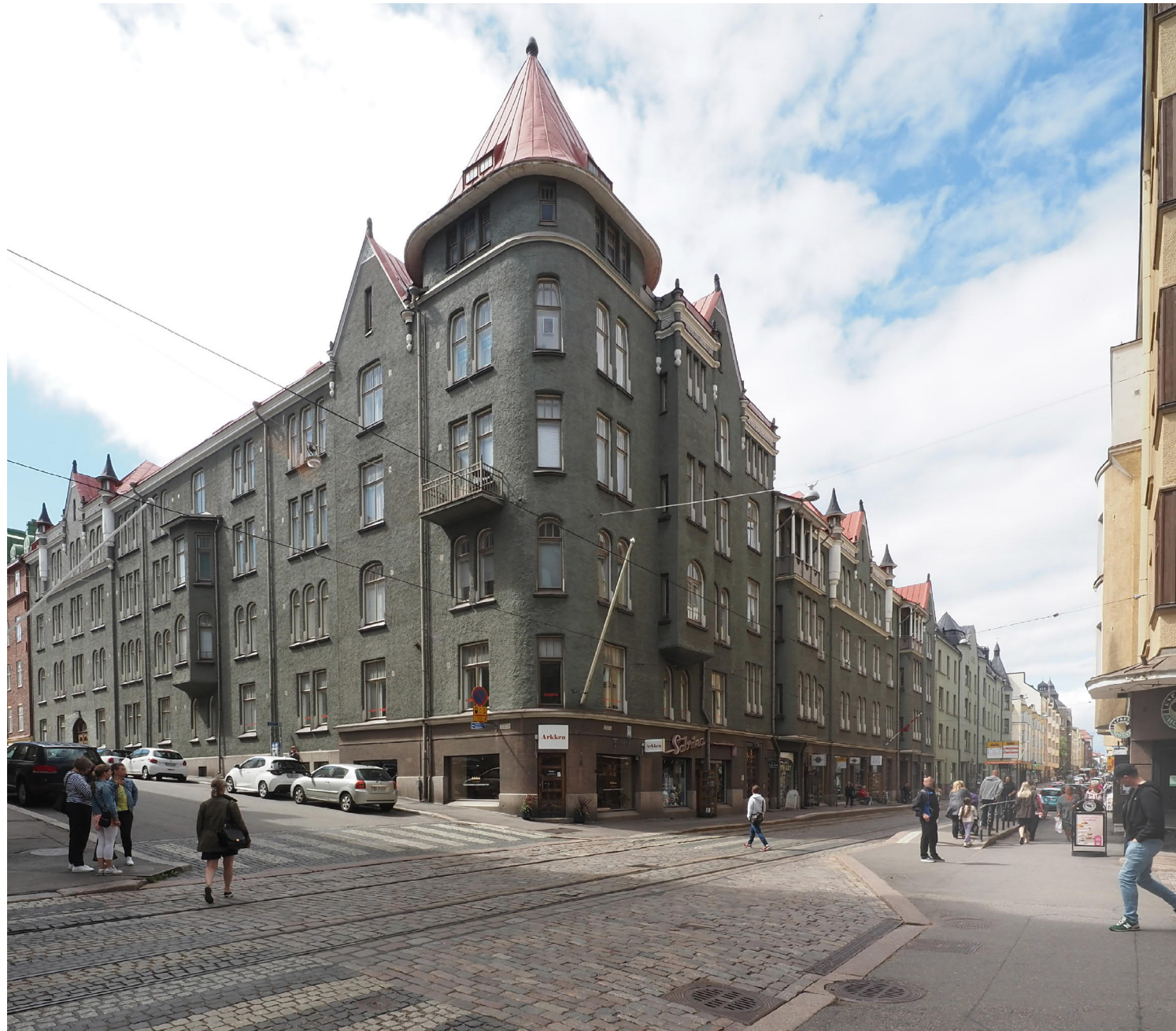
Fredrikinkadulla on Punavuorelle tyypillistä katutilaa: maantasokerrosten avoimuus, yhtenäiset räystäslinjat, katukuilun suorakulmainen läpileikkaus, kiveykset ja pitkät näkymälinjat. Kuva: Sakari Mentu
