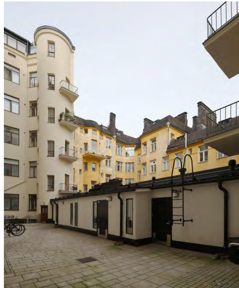
Tornimainen pihaporras, Korkeavuorenkatu 27, taustalla naapuripiha.
