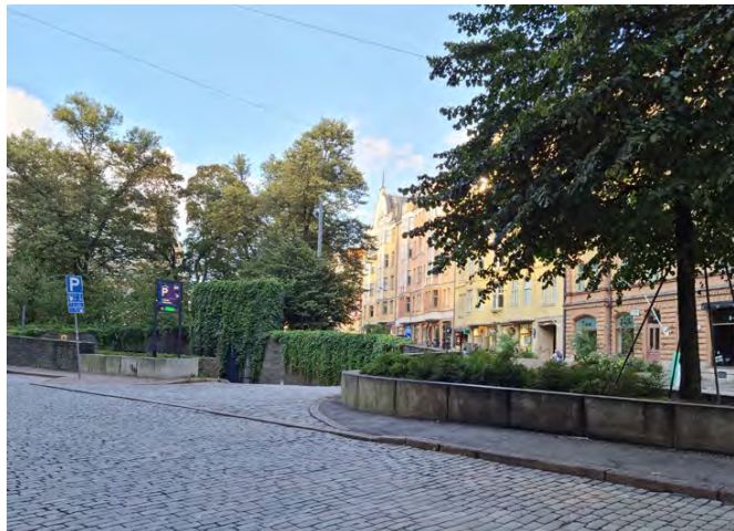
Yrjönkadun puoleinen reuna, pysäköintilaitoksen sisäänajoluiskan ympäristön rakenteet. Kuva 2023
