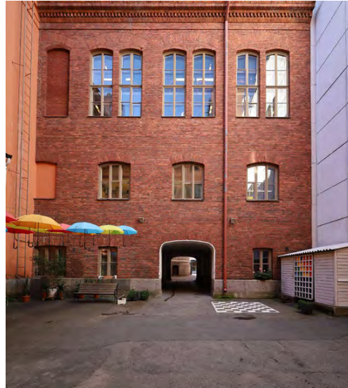
Sisemmän pihan puolella pihasiiven julkisivussa on käytetty puhtaaksi muurattua punatiiltä.
