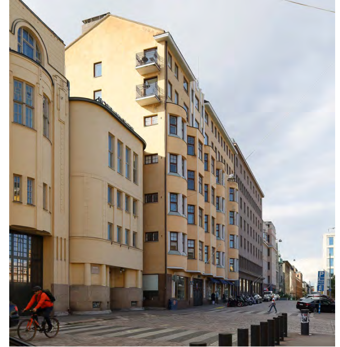
Kortteli 52. Kasarmikatu 34 (1912), arkkitehti Sigurd Frosterus. Vasemmalla Sähkölaitoksen julkisivu.
