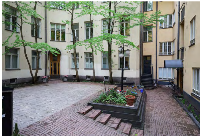
Kortteli 56, Unioninkatu 6:n kunnostettu, istutettu piha. Vasemmalla näkyy korkea pihasiipi 1890-luvulla. Saman pihasiiven punatiilinen palomuuuri kohoaa Fabianinkatu 5:n pihan taustalla.
