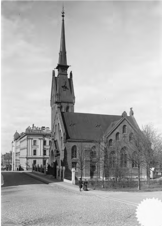
Saksalaisen kirkon suunnittelivat Harald Bosse ja Carl Johan von Heideken. Kirkko valmistui vuonna 1864. Vuoden 1897 korjaustöiden yhteydessä kirkkoon rakennettiin kuvassa näkyvä, Josef Stenbäckin piirtämä torni. Valokuva M. L. Carstens, kustantaja 1907–1909, MVHK
