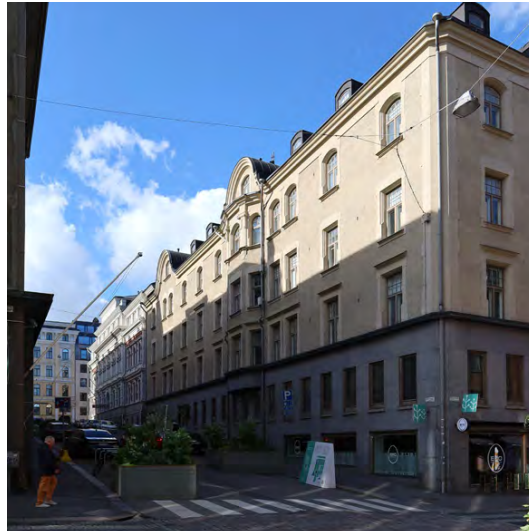
Kortteli 49. Rikhardinkatu 1 (1899), Arkkitehtuuritoimisto Grahn, Hedman & Wasastjerna. Rakennuksen ulkoasua on perusteellisesti uudistettu 1920- ja 1930-luvuilla.
