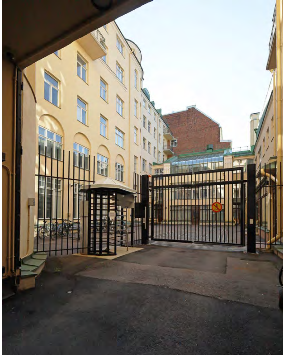
Eteläesplanadi 4, Kortteli 47, Armas Lindgrenin alun perin liike- ja asuintaloksi suunnitteleman ja valtion virastotaloksi vuonna 1913 valmistuneen rakennuksen piha. Lasikattoisessa siivessä on ollut kalastusmuseo.
