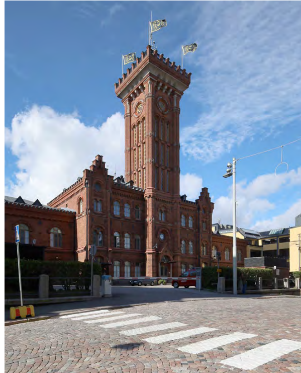
Theodor Höijerin suunnittelema, 1891 valmistunut Erottajan paloasema, Korkeavuorenkatu 26. Torni on kaupungin siluettissa kauas näkyvä maamerkki.
