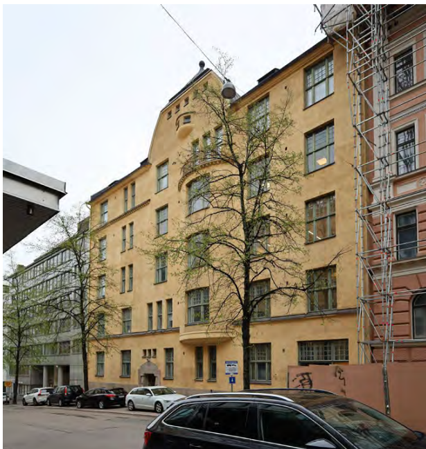
Kortteli 55. Unioninkatu 7, Eteläranta 6 (1903), arkkitehti Mauritz Gripenberg. Kuva Unioninkadulta.
