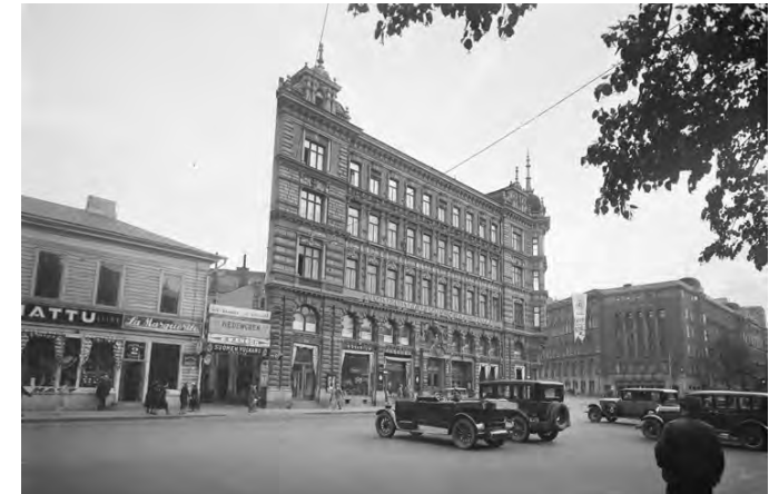
Eteläesplanadin päättää Erottajan päässä Girsénin viisikerroksinen uusrenessanssitalo, Eteläesplanadi 24. Vuonna 1893 valmistunut rakennus on Theodor Höijerin suunnittelema. Kuvakulman ja teräväkulmaisen tontin takia julkisivu näyttää valokuvassa pelkältä kulissilta. Valokuva Pietinen 1931. MVHK
