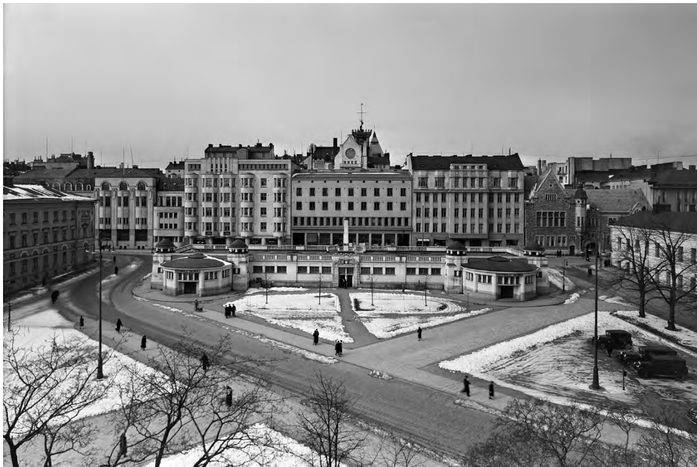
Näkymä kohti Kasarmikadun 1920-1930-luvuilla rakennettua julkisivurintamaa, valokuva Kasarmitorin itäreunalta Fabianinkatu 15:n katolta tai yläkerroksista. Vastapäätä näkyy Selim A. Lindqvistin suunnittelema yksikerroksinen kauppahalli kattoterasseineen. Kauppahalli purettiin 1958. Sen takana näkyy vasemmalta alkaen sähkölaitos ja sen laajennus, 1912 valmistunut Kasarmikatu 34, 1935 valmistunut Kasarmikatu 36, 1910 valmistunut Kasarmikatu 38, 1901 valmistunut Nylands Nation ja osakuntarakennuksen oikealla puolella Kasarmikatu 40 vuodelta 1934. Taempana näkyy puhelinyhdistyksen rakennuksen pihanpuoleinen pääty, sen oikealla puolella torni ja niiden takana paloaseman tunnusomainen torninhuippu. Valokuva 1930-luvun loppupuolelta. HKM
