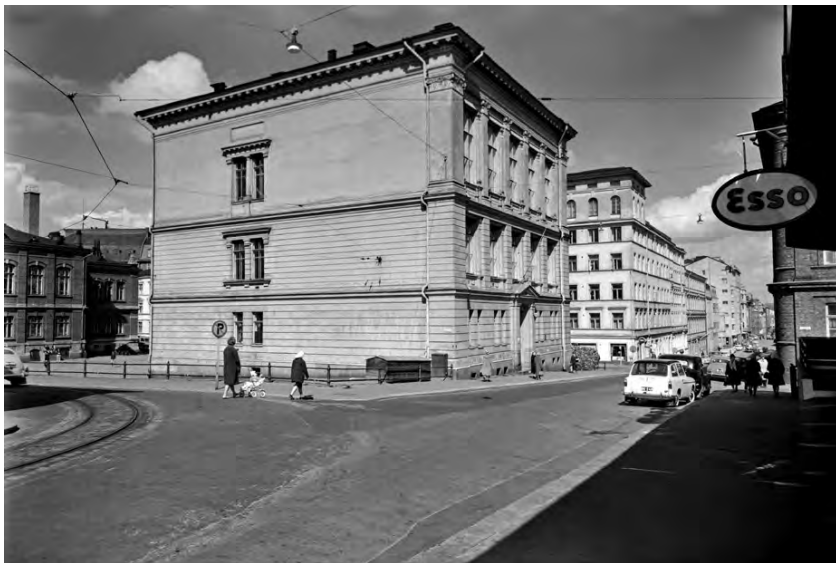
Entinen Tieteellisten seurojen talo (1898-1899), Kasarmikatu 24. Rakennuksesta toteutettiin aikoinaan vain keskiosa. Kuva Kasarmikadun ja Punanotkonkadun risteyksen suunnalta, Constantin Grünberg 1962, HKM
