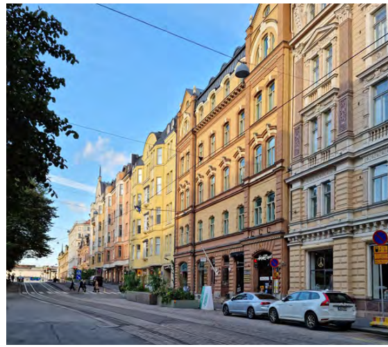
Kortteli 51. Erottajankatu 5, arkkitehti A. Boman (1880) korotus arkkitehti Onni Törnqvist (1895), korotus arkkitehti W.F. Gottkamp(1908).
