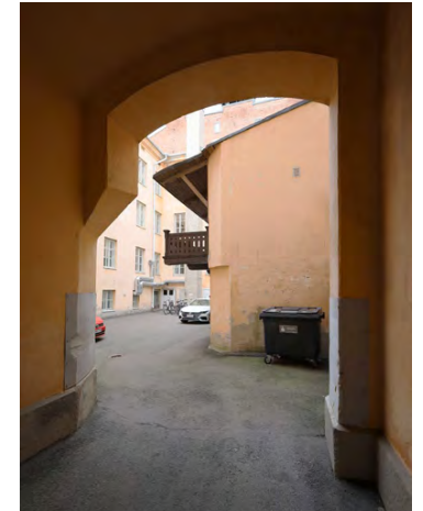
Holvattu porttikäytävä, Ullanlinnankatu 5.
