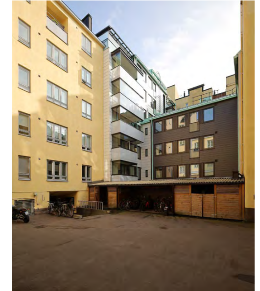
Gunnar Wuorion suunnitteleman Unioninkatu 10:n asuinrakennuksen rapattu pihajulkisivu (1933), taustalla naapuripihaan uudempi rakennus vuodelta 1962.
