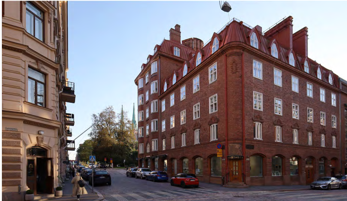
Kortteli 59, Ratakatu 1a - Pieni Roobertinkatu 10 (1920), arkkitehti Einar Sjöström.
