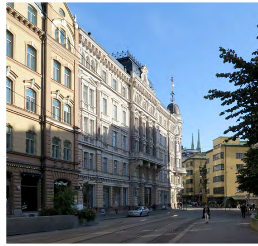
Kortteli 51. Erottajankatu 1-3 (1891), Rakennustoimisto Kiseleff & Heikel; August Nordberg.
