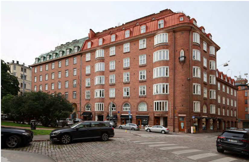
Ratakatu 1a:n ja 1b:n punatiilijulkisivut muodostavat Koulupuistikon taustalla kiinteän, yhtenäisen kortteliseinämän.
