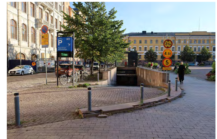
Kasarmitorin pysäköintilaitoksen toinen ajoramppi sijaitsee Fabianinkadun varrella torin koilliskulmassa.
