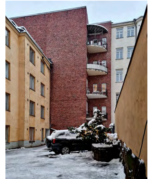
Fabianinkatu 5:n pihalla on autopaikkoja. taustalla kohoaa 1890-luvulla rakennettu Unioninkatu 6:n palomuuuri, jonka kulmassa näkyy tontinrajaa vasten jätetty, rakennusjärjestyksen mahdollistama 3x3 metrin valokuilu. Siihen on jälkikäteen rakennettu parvekkeet.
