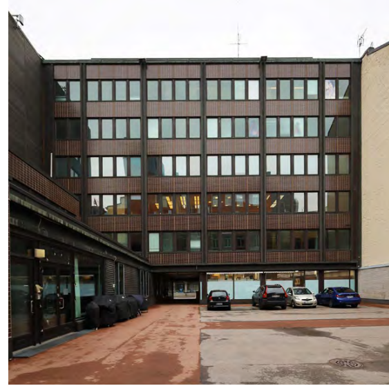
Fabianinkatu 8:n vuonna 1972 valmistuneen liikeraennuksen pihaa käytetään pysäköintiin.
