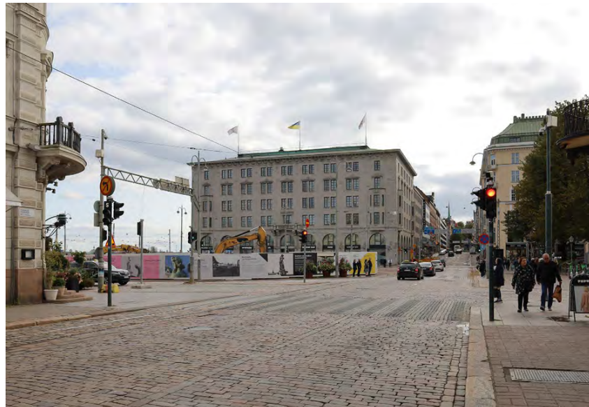
Näkymä pohjoisesta kohti Kaartinkaupunkia ja Unioninkadun akselia pitkin etelään. Kaupunkikuvaa hallitsee Karl Lindahlin suunnittelema rakennus.
