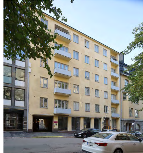
Kortteli 56. Unioninkatu 10 (1933) 6-kerroksinen asuinkerrostalo, arkkitehti Gunnar Wuorio.
