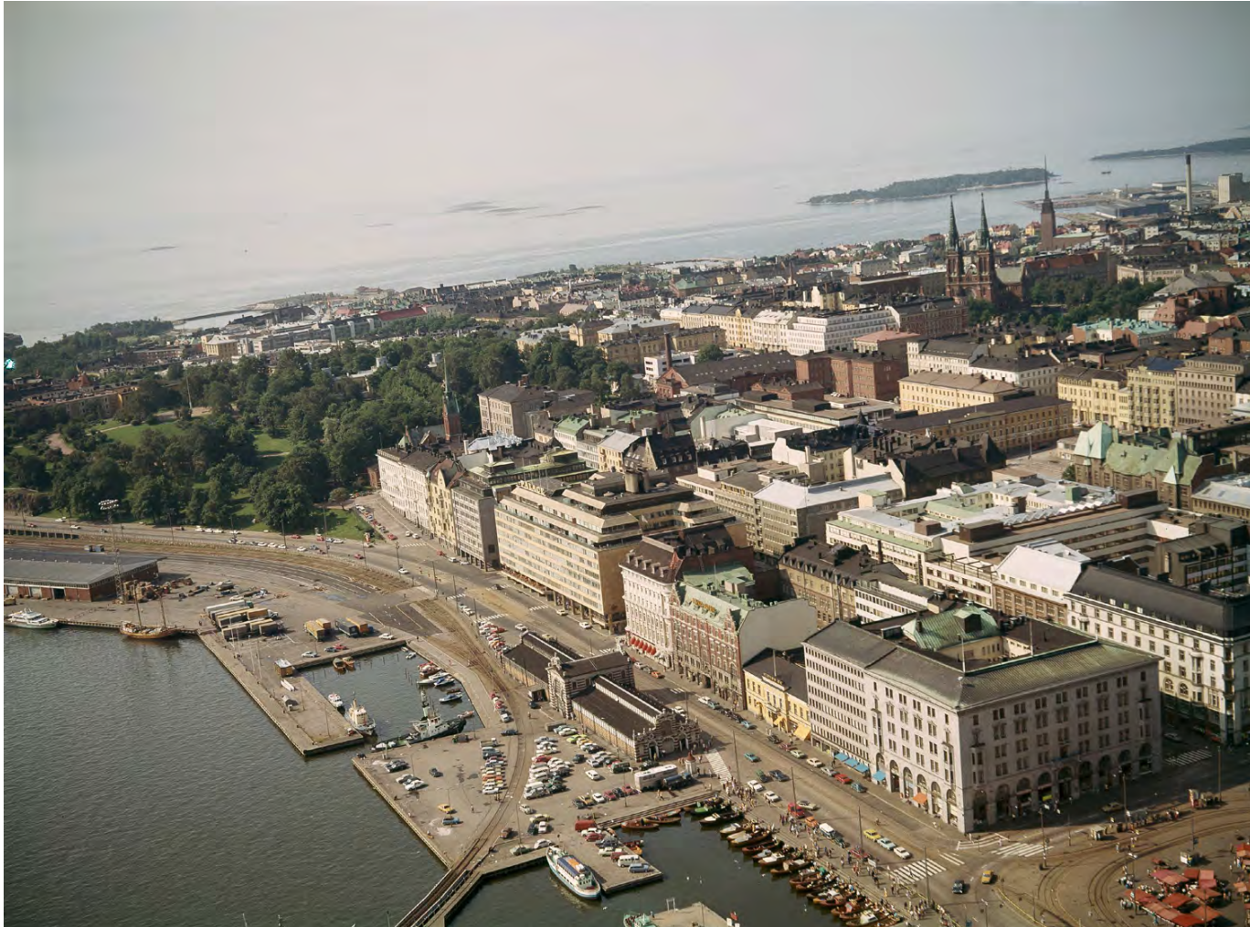
Eteläranta ja Kaartinkaupunki 1970-luvulla, viistokuva Sky-Foto Möller. HKM. Etelärannan, Unioninkadun ja Fabianinkadun kaupunkikuvassa näkyy selvästi 1940-luvulta alkanut muutosvaihe uusine toimisto- ja liikerakennuksineen.
