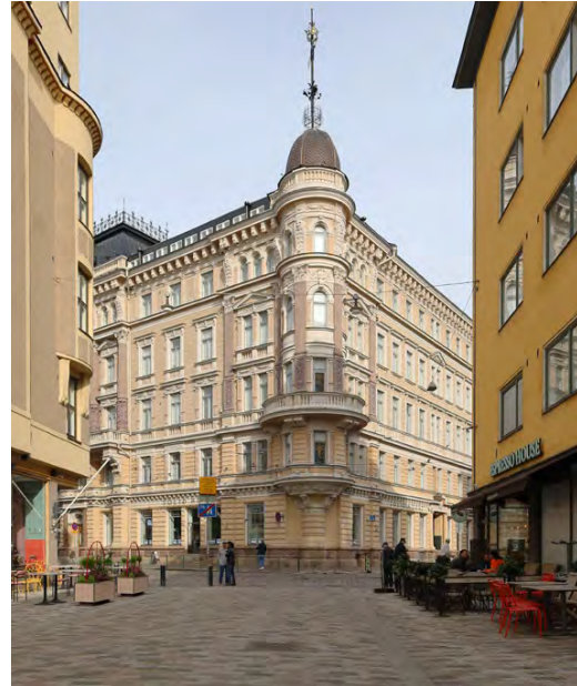
Kortteli 51. Erottajankatu 1-3 (1891), Rakennustoimisto Kiseleff & Heikel; August Nordberg.
