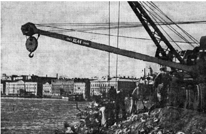
Lapiot heiluvat Eteläsataman puoleisen vanhan laiturin purkutöissä Katajanokalla. Vuosisadan vaihteessa rakennettua laituria on määrä hajoittaa yli 400 metrin pituudelta. Ensimmäiseen tavoitteeseen kuuluu tosin vain 300 metrin pätkä. Tänä vuonna pitäisi vesirajan yläpuolelle kohdistuvat purkuhommat saada päätökseen. — Uuden laiturin on laskettu maksavan ainakin miljoona markkaa metriä kohti, mutta ruoppaukset vaativat myös osansa kustannuksista, joten laiturin hinta nousee hyvän matkaa 600 miljoonan paremmalle puolelle.
