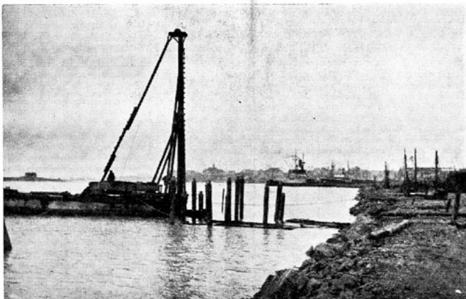
Uuden hiililaiturin rakennustyöt ovat parhaillaan käynnissä Katajanokan kärkeen ja sandoan laiturin osittain huutoon jo tänä syksynä.
