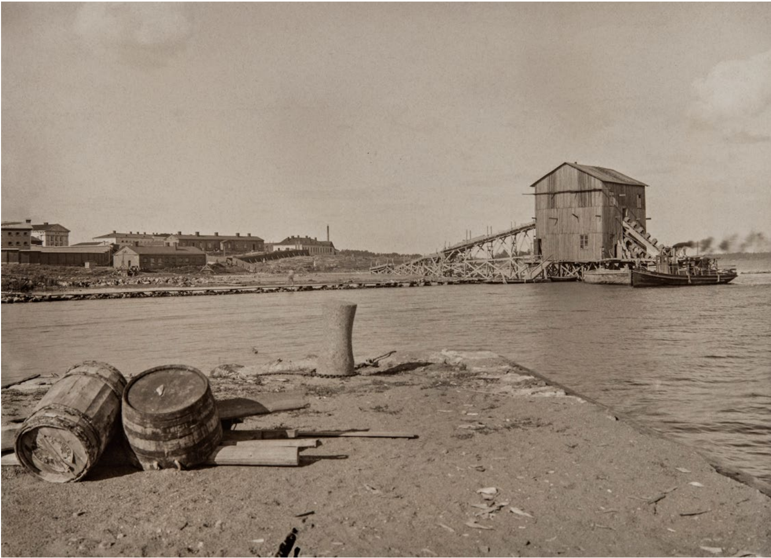
n. 1897 Rahapajanrannan laiturin rakennustyöt
