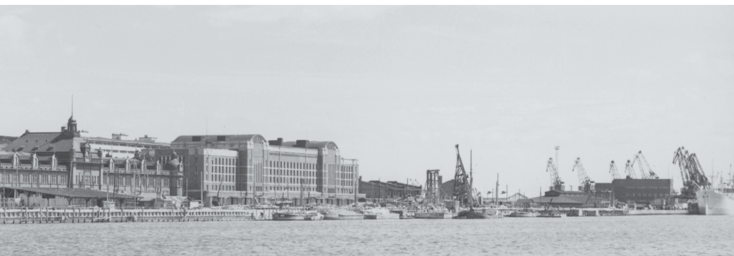
Ajoittamaton valokuva Katajanokanlaiturista. Sataman punatiilinen makasiinijulkisivu näkyy selkeästi, koska nykyisiä, 60-luvulla valmistuneita terminaalirakennuksia ei ole vielä rakennettu, rannan varastorakennukset ovat vielä yksikerroksisia. Kuva on rakennuksista päätellen todennäköisesti 1950-luvun lopulta. Valokuvaaja FotoRoos, HKM
