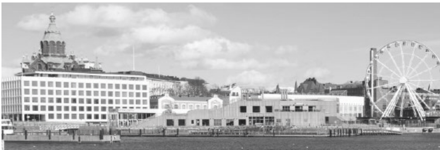
Katajanokan kerroksellinen julkisivu vuonna 2020. Kuvan ottamisen jälkeen toinen punatiilisistä terminaalirakennuksista on purettu, ja paikalle rakentuvaan uudisrakennukseen sijoittuvat Enson pääkonttori ja hotelli. Makasiinirakennuksista muodostunut julkisivu on jäänyt terminaalirakennusten taakse, ja Rahapajan edustalle on rakennettu väliaikainen Meriuimalan rakennus.
