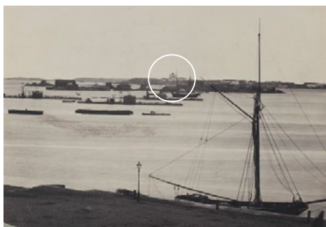
kuva 4. 1870-1879. Näkymä Eteläsataman Keisarinluodolta (Nyk. keisarinluodon laiturin kohdalla) kohti Suomenlinnaa. Valkosaarella ei ole vielä korkeita rakennuksia ja luodot ovat puustosta paljaat, joten näköyhteys Suomenlinnan kirkolle on siksi hyvin selkeä. Härth, C.A. / Finna
