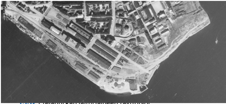
1932 Etelänurkan laituralueen täyttötöyt
