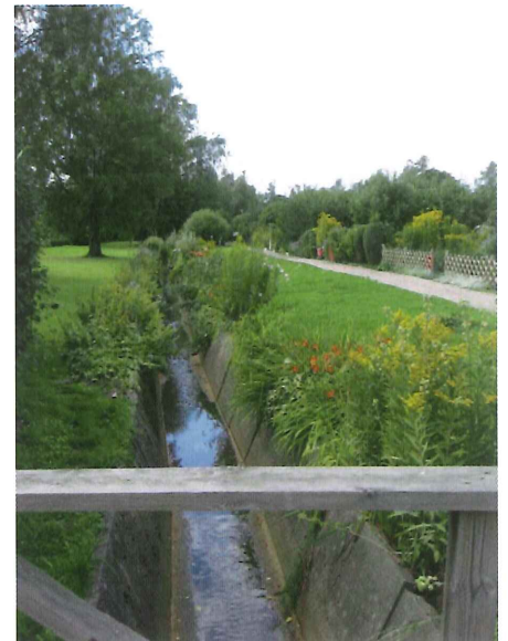
Kumpulanpuro nykytilassaan betonoidussa kaukalossa. Kuva: Loci Oy
