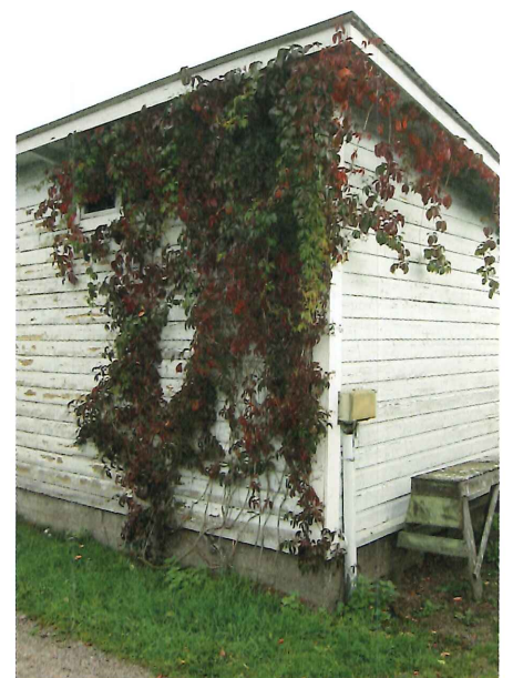
Alueen alkuperäinen huoltorakennus. Kuva: Loci Oy
