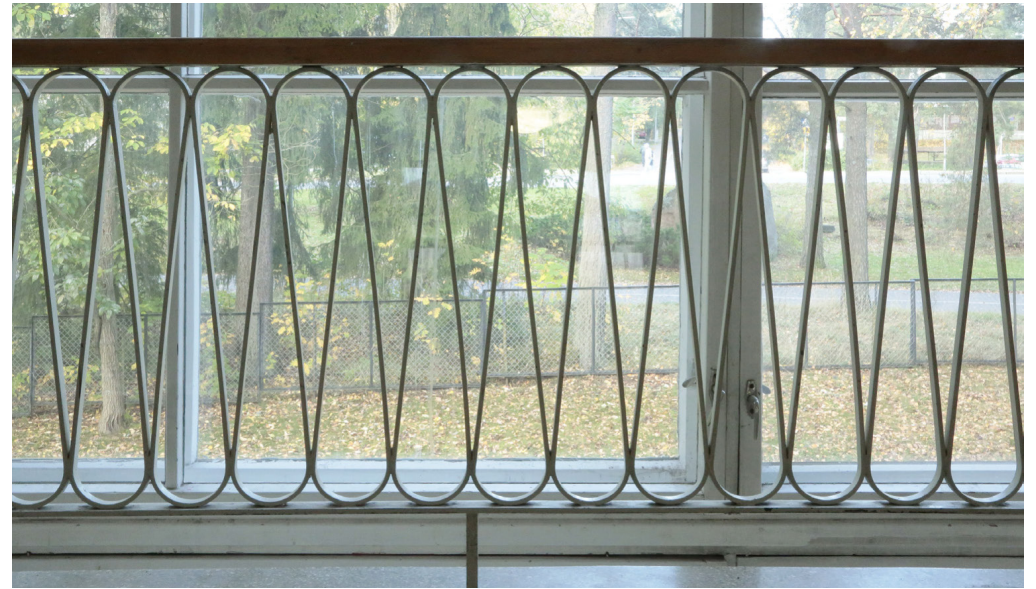
Portaiden välitasanteen kaide
