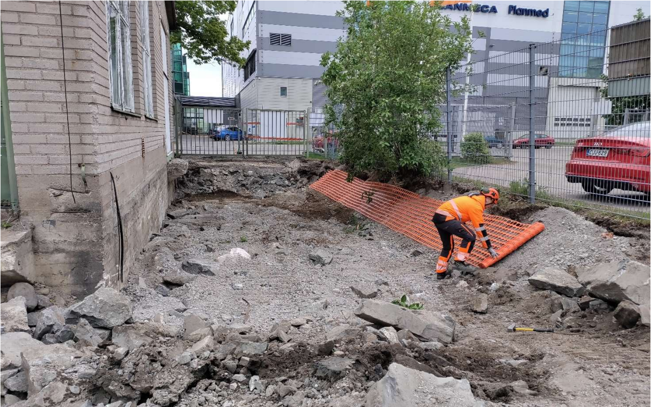
Kuva 6. Huomioverkon asennus tontin eteläreunalle
