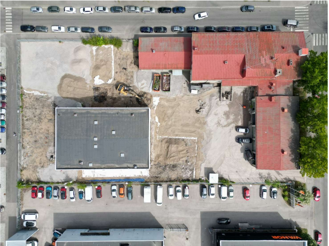
Kuva 9. Kunnostuksen loppuvaihetta. Suurin osa täytöistä on tehty länsi-keskiosaan ja luoteisnurkkaan (6.6.2023).
