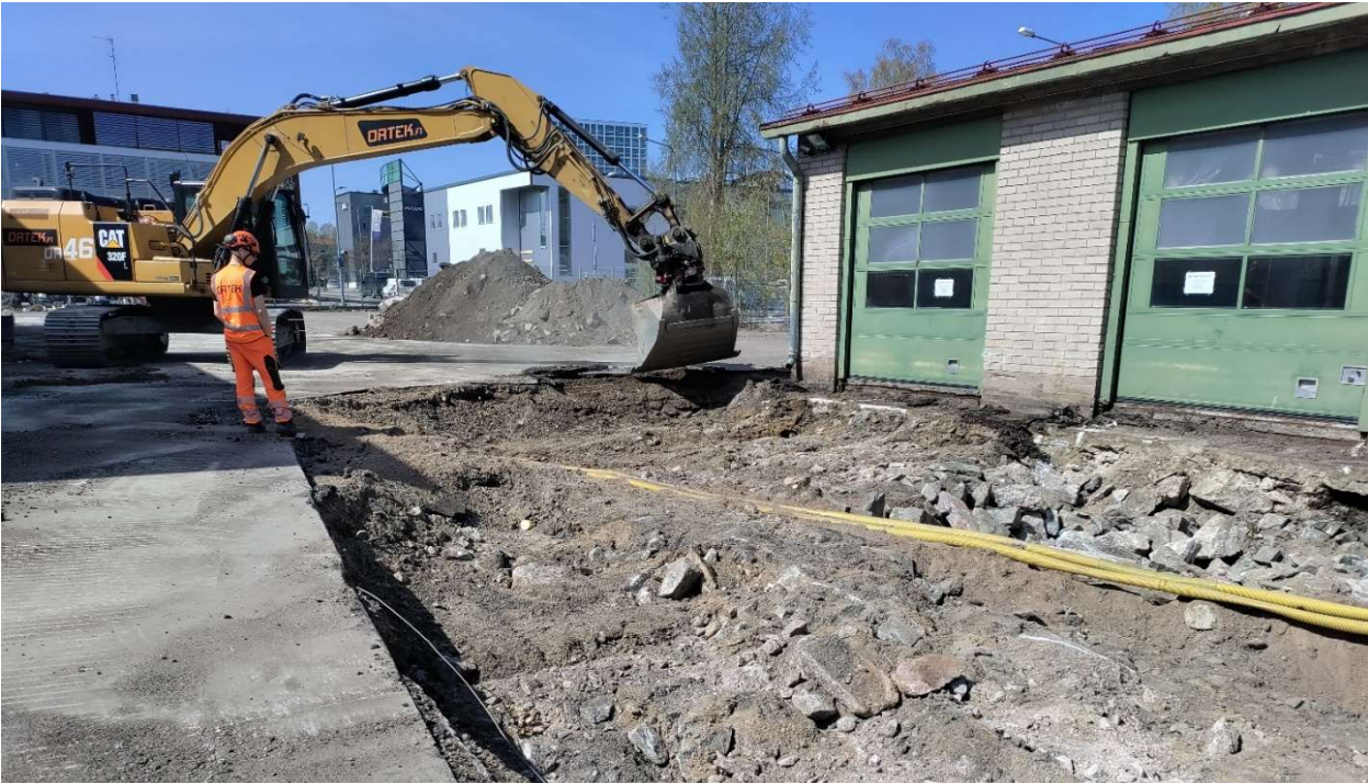
Kuva 1. Öljypilaantumien kaivua tontin pohjoisosan hallin edustalta. Louhe paikoin pinnassa.
