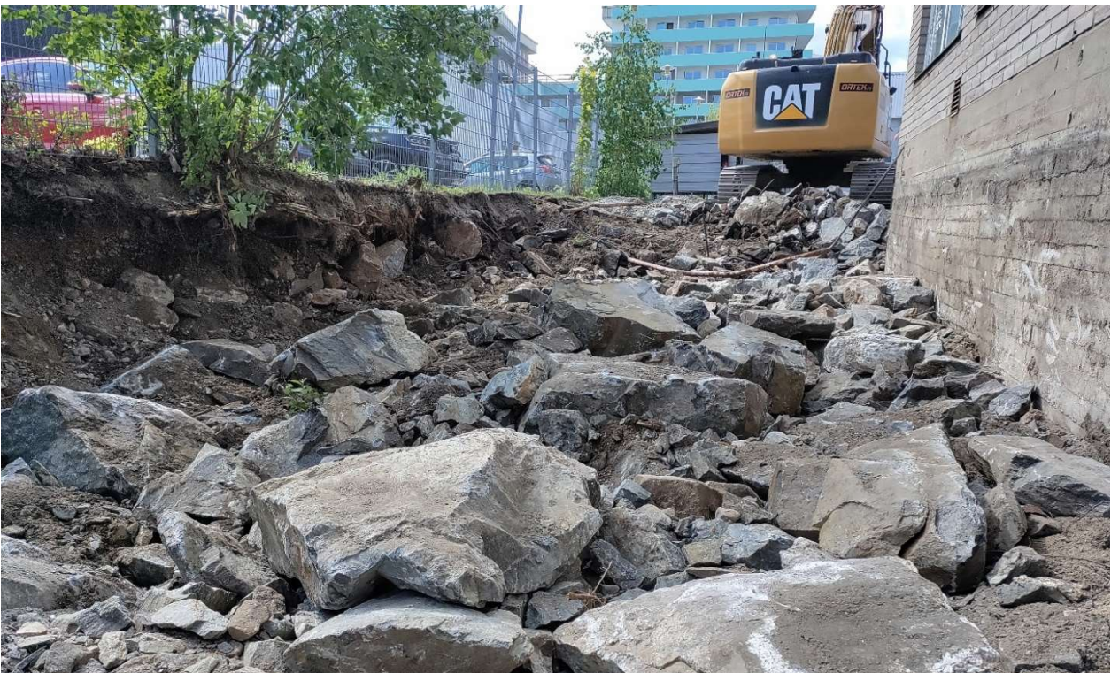
Kuva 4. Tontin kaakkoisnurkan kaivanto. PAH-yhdisteiden takia kaivantoa syvennettiin. Vasemmalla sivulla metalliromua sisältävä seinämä (N47).
