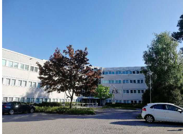
Kuva 2. Kiinteistön sisäpiha, johon tutkimuspisteet sijoitettiin. Kulmassa pääsisäänkäynti.
