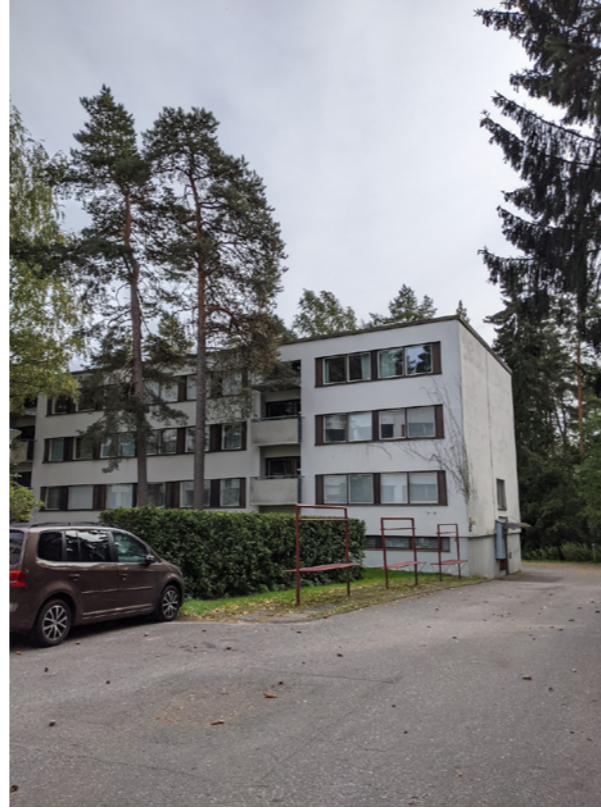
Tuuletustelineet ja pensasrivi tulevat säilymään osittain uuden ulkovälinevaraston vieressä
