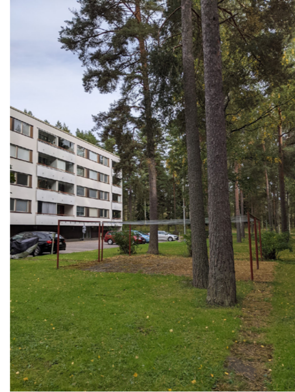
Kuivaustelineet ja polku nykyisten rakennusten välissä
