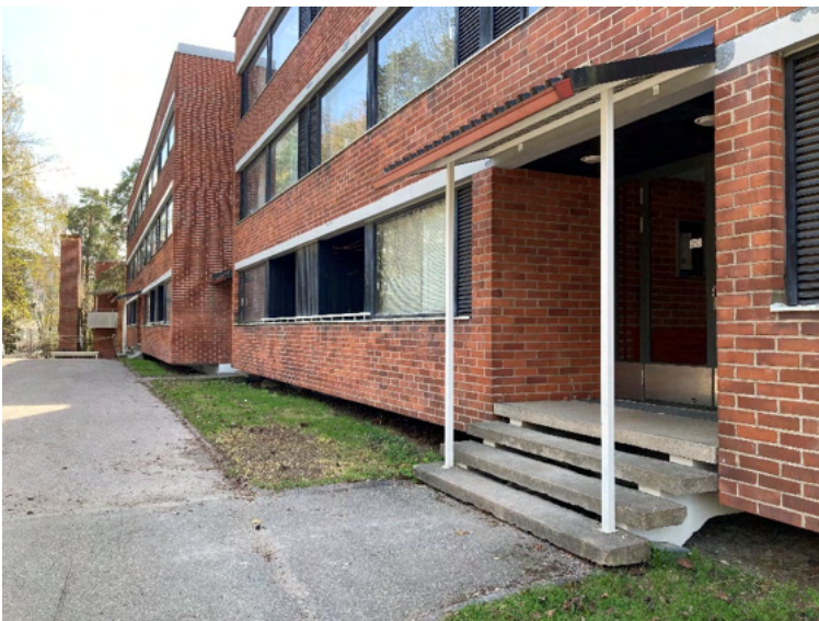
Kuva 9. Medioma II, julkisivu länteen, pysäköintialueen puolelle. Taustalla Medioma I. Teräsrakenteiset katokset eivät ole alkuperäisiä.
