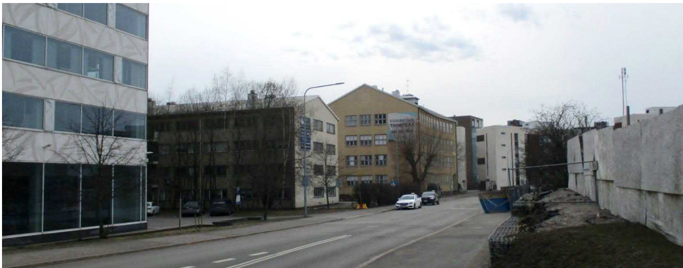
Kuva 32. Näkymä rakennukseen Kutomotien itämaisestä varresta.
