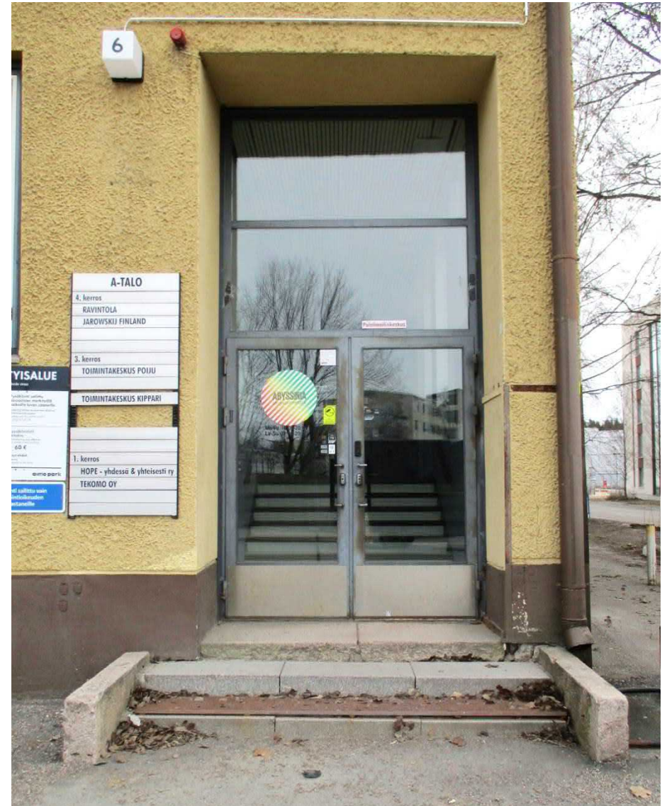
Kuva 42. Pääsisäänkäynti. Ovi on uusittu, ajankohta ei tiedossa.
