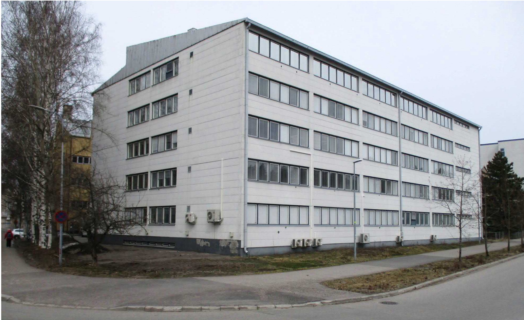
Kuva 72. Näkymä Kutomokujan käännteestä. Siporex -elementtien jako on julkisivuille tärkeä ominaispiirre. Katomuoto ja julkisivut ovat säilyneet ennallaan.
