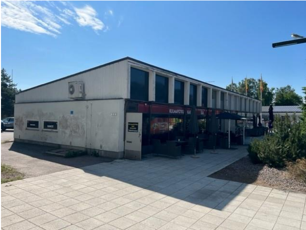
Rakennuksen pohjoispääty ja itäpuoli.
