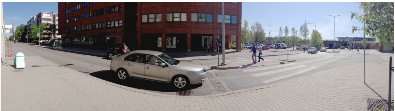
Kuva 5. Eskolantien ja Säterintien risteysalue on korotettu sen päädyissä olevilla hidastetöy-syillä, jotka muodostavat tarkastelualan merkittävimmän liikennetärinän lähteen.
