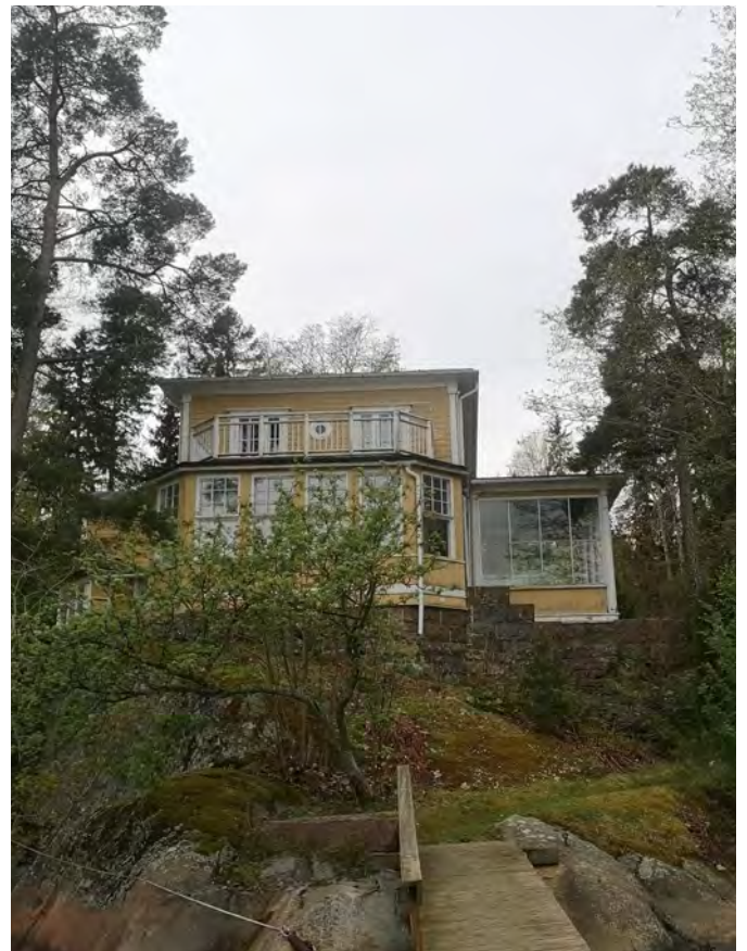
Kuva 57. Sama kohta vuonna 2021.
