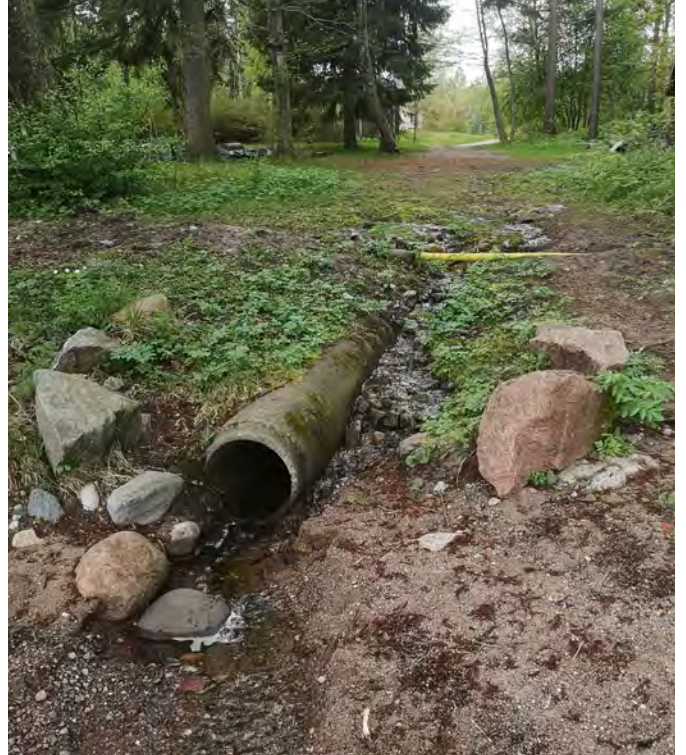
Kuva 89. Puuskakujalta laskeva betoninen hulevesiputki purkaa hiekkarannalle. Kesä 2021.
