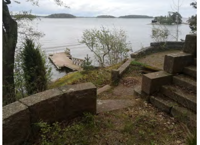
Kuva 33. Villa Svalvikin graniittikivimuureja ja -portaita kevät 2021.
