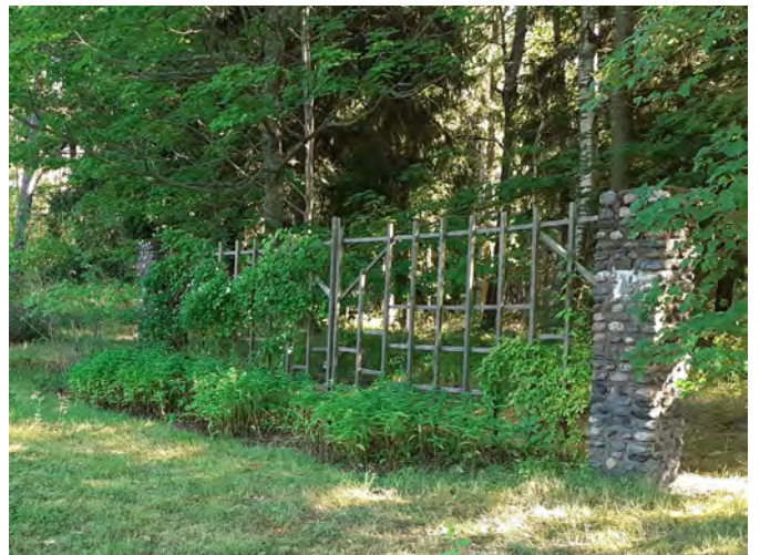
Kuva 34. Säilyneet pergolan kivipylväät.
