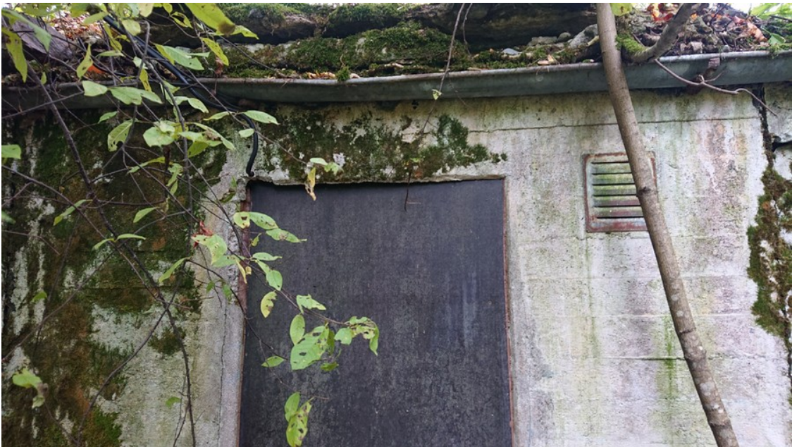
Kuva 6.20. Kallioniementie 8:n tontin laidalla on ilmeinen bunkkeri.
