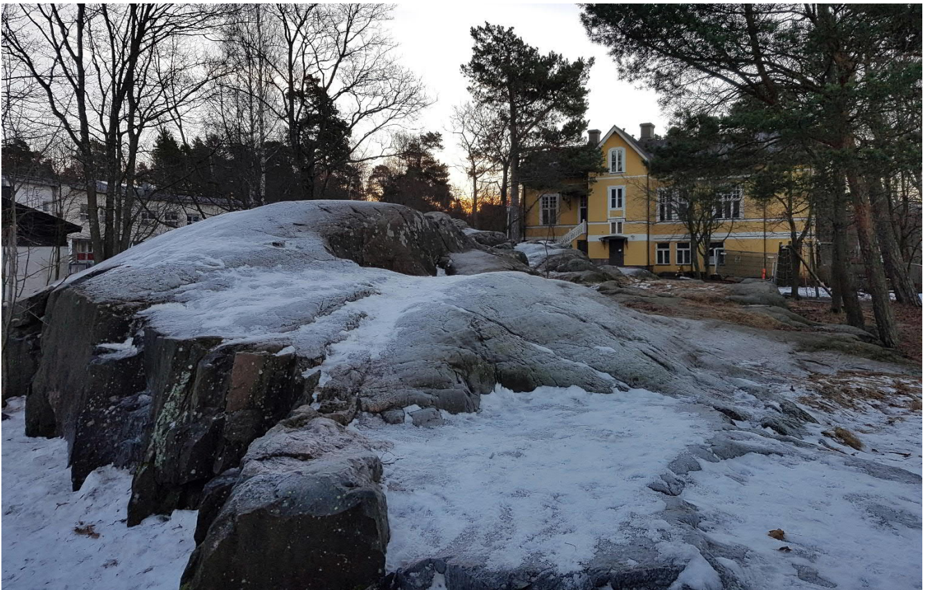
Yläkuva: Rakennus Sibeliuksen puiston suunnasta 1960- tai 1970-luvulta. Kuvaaja A. Ryyppö, Helsingin kaupungin museo. Alakuva: Rakennuksen rajautuminen Rajasaarentien puolella sijaitseviin kallioihin, Kaupunkiympäristö, asemakaavoitus.
