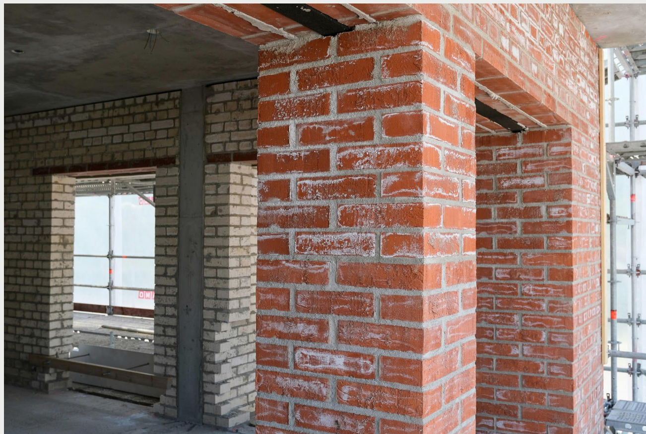
Kahden tiilen paksuinen ulkoseinä parvekevyöhykkeen kohdalla
