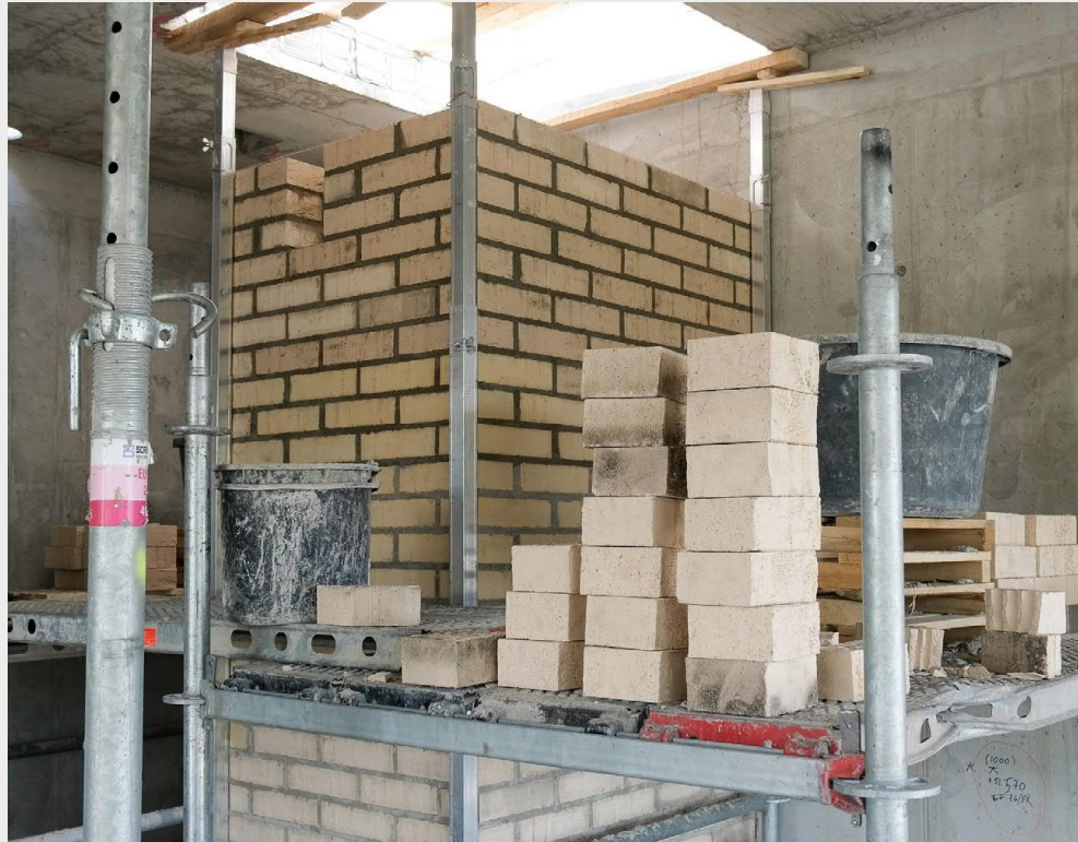
Painovoimaisen ilmanvaihdon hormin muuraustyö käynnissä
