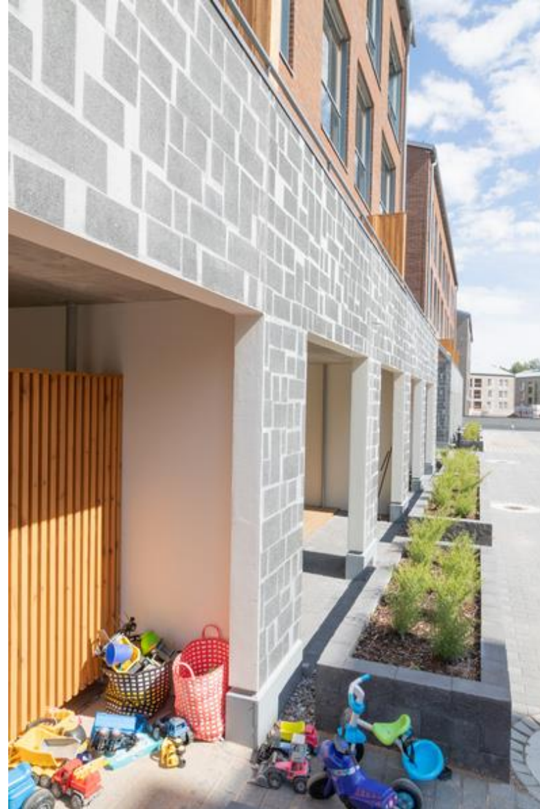
Muuntojoustava kerrostalo, Haaga
