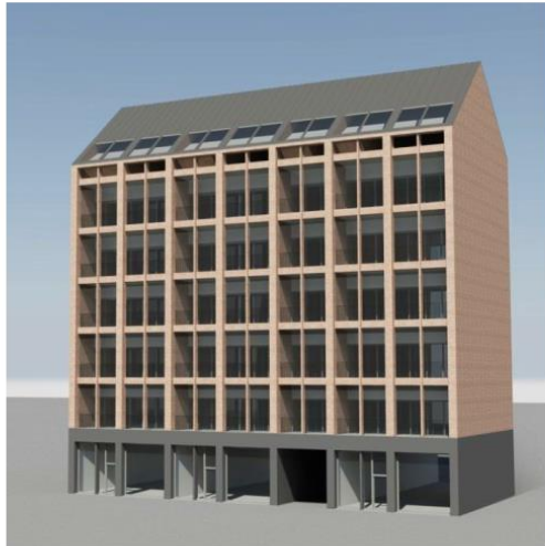
Kuva 10. SunZEB-kaupunkitalo. Perinteisen, helsinkiläisen umpikorttelikerrostalon malliin perustuvassa asuinkerrostalotyypissä on katujulkisivun mittainen lasitettu parvekevyöhyke, joka torjuu sisätilojen liiallisen yllämpenemisen.
