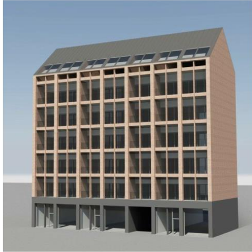
Kuva 10. SunZEB-kaupunkitalo. Perinteisen, helsinkiläisen umpikorttelikerrostalon malliin perustuvassa asuinkerrostalotyypissä on katujulkisivun mittainen lasitettu parvekevyöhyke, joka torjuu sisätilojen liiallisen yllälämpenemisen.
