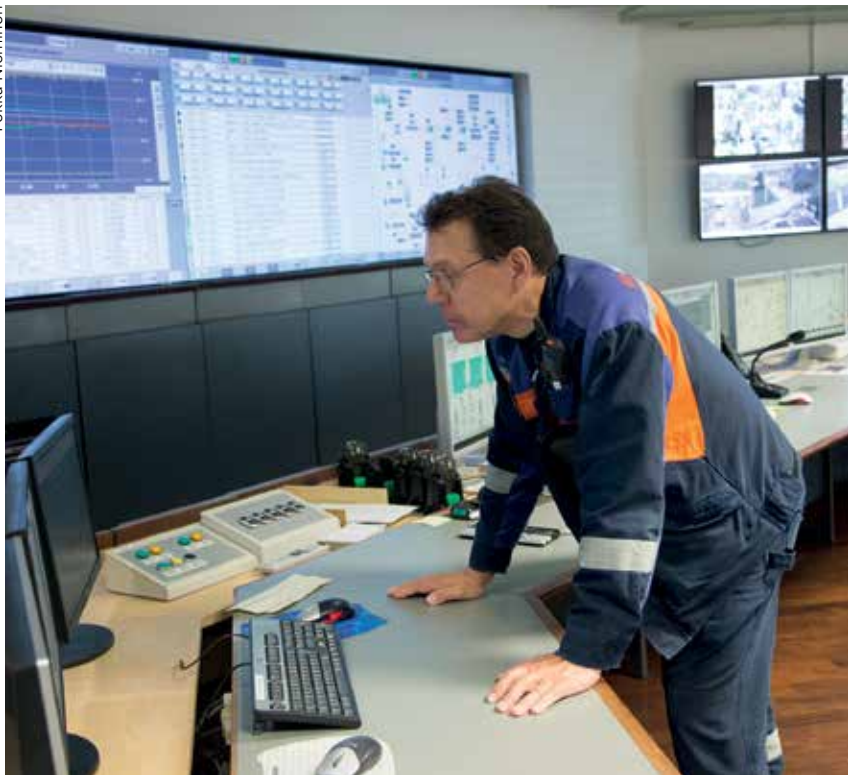
Kaupungin sisäisen valvonnan ja riskienhallinnan tila on kohtuullinen. Helsingin Energian Vuosaaren voimalaitoksella valvomossa työvuorossa vuoromestari Jouni Vihko.
